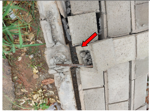
Ausência de Armadura nos pilares e interrupção dos arranques (onde existem).
