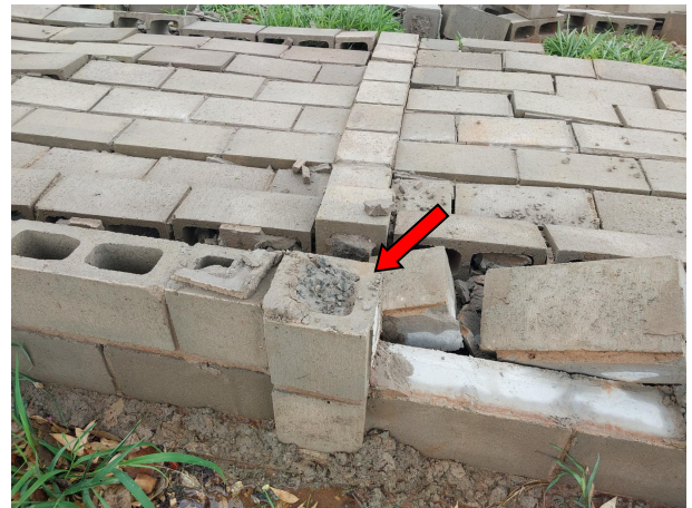
Ausência de Armadura nos pilares.
