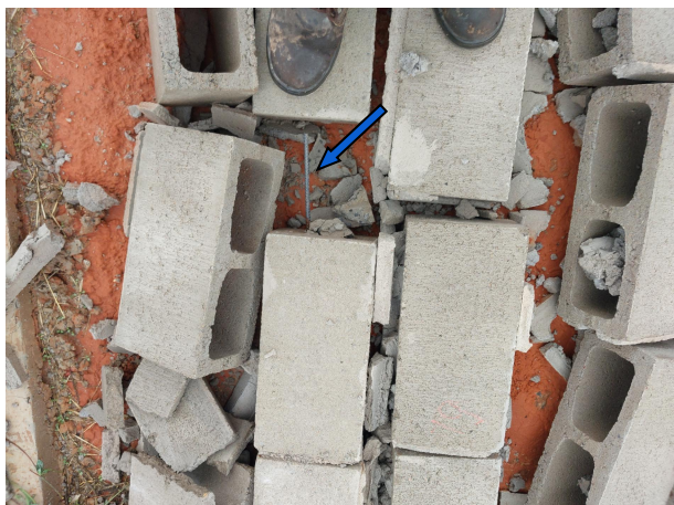
Cintas de amarração com apenas 1 vergalhão de 8mm em desacordo com o projeto qual solicitava 2 vergalhões, seccionada de modo a deixar parte da cinta sem nenhuma armadura.
