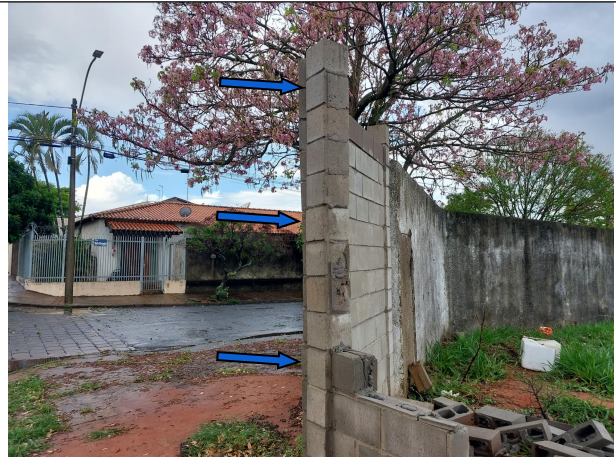
Ausência de Armadura nos pilares e falta de transpasse das cintas de amarração em desacordo com o projeto. Locais onde deveriam estar transpassadas as armaduras das cintas (seta azul)
