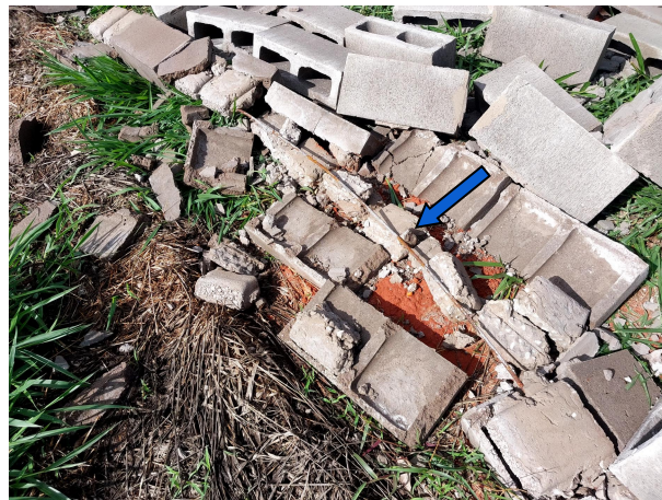
Cintas de amarração com apenas 1 vergalhão de 8mm em desacordo com o projeto qual solicitava 2 vergalhões.
