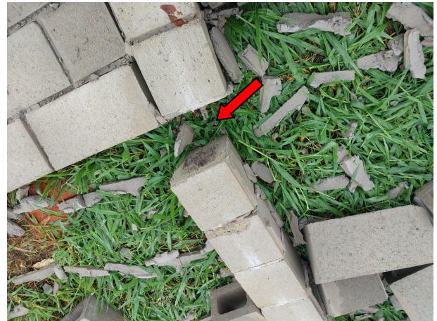
Ausência de Armadura nos pilares.
