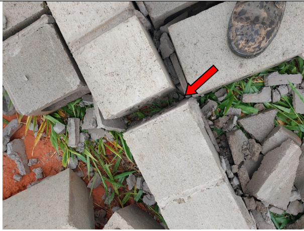
Ausência de Armadura nos pilares e interrupção dos arranques (onde existem).
