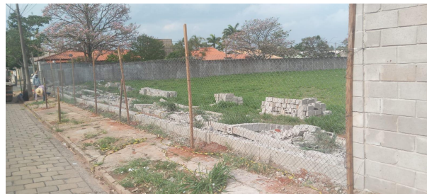
Fechamento do acesso com alambrado realizado em 31/10/2025.
