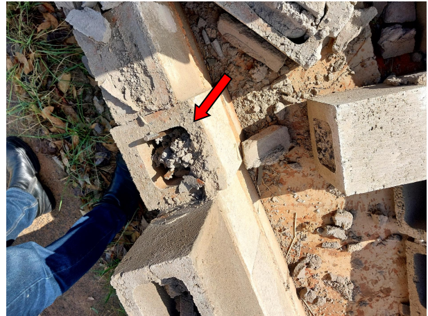
Conforme projeto a armadura dos pilares deveria vir continuamente dos baldrames e percorrer toda a extensão dos pilares. As fotos revelam pilares sem armadura, com a armadura interrompida e sem preenchimento.
