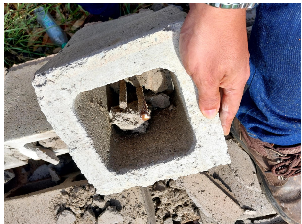
Cintas de amarração (azul), pilares (vermelho). Pilares que deveria estar preenchidos.
