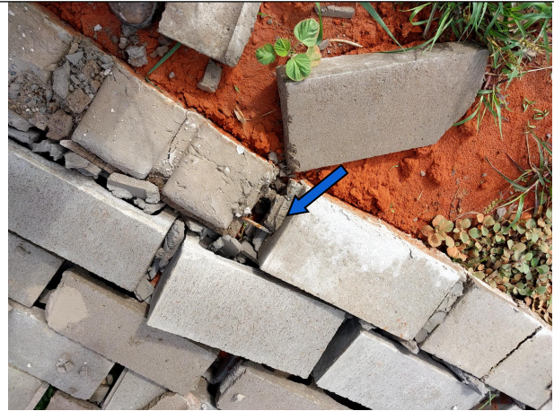
Pilares com preenchimento porém sem armadura e cintas de amarração nas mesmas condições das anteriores.
