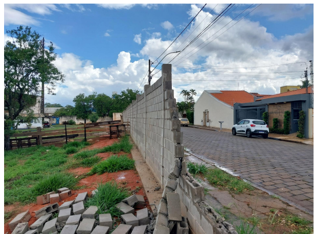
Cintas de amarração com apenas 1 vergalhão de 8mm em desacordo com o projeto qual solicitava 2 vergalhões, seccionada de modo a deixar parte da cinta sem nenhuma armadura.
