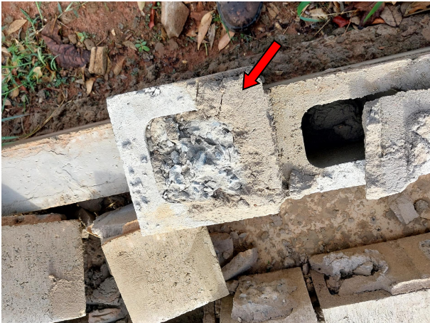
Conforme projeto a armadura dos pilares deveria vir continuamente dos baldrames e percorrer toda a extensão dos pilares. As fotos revelam pilares sem armadura, com a armadura interrompida e sem preenchimento.
