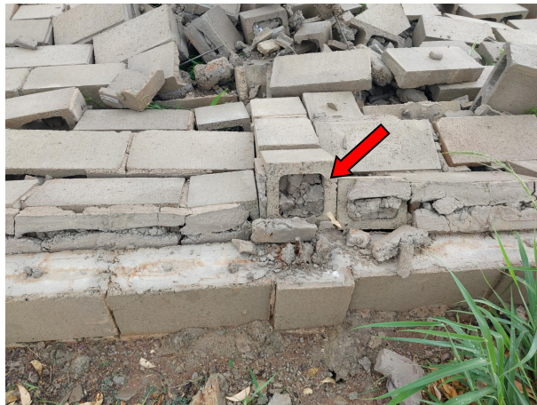
Ausência de Armadura nos pilares.
