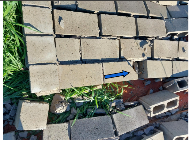
Cintas de amarração com transpasse insuficiente e em desacordo com o projeto, iniciando com 2 vergalhões e continuando com apenas 1 vergalhão de 8mm em desacordo com o projeto.
