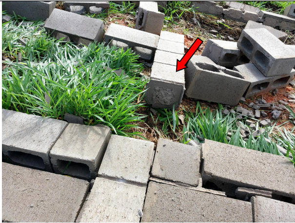
Pilares com preenchimento porém sem armadura e cintas de amarração nas mesmas condições das anteriores.
