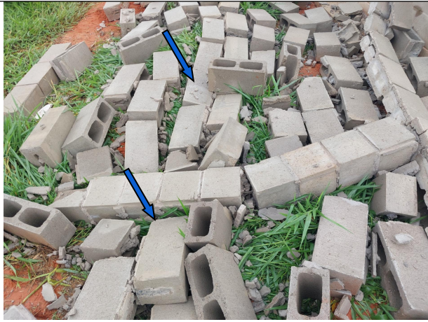
Pilares sem grauteamento e sem armadura.
