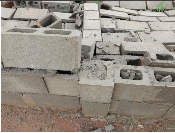
Ausência de Armadura nos pilares e falta de transpasse das cintas de amarração em desacordo com o projeto. Locais onde deveriam estar transpassadas as armaduras das cintas (seta azul)
