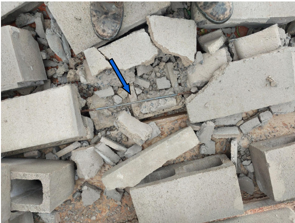
Cintas de amarração com apenas 1 vergalhão de 8mm em desacordo com o projeto.
