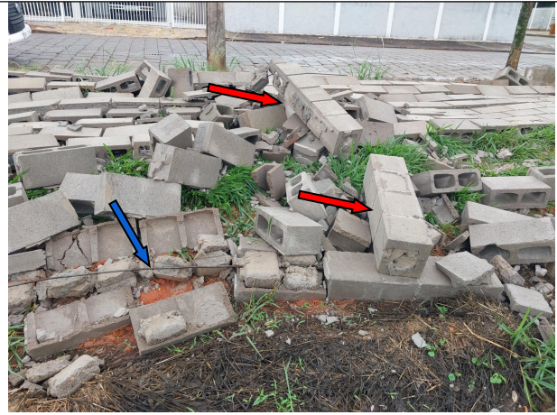
Cintas de amarração (azul) não ligada aos pilares (vermelho).
