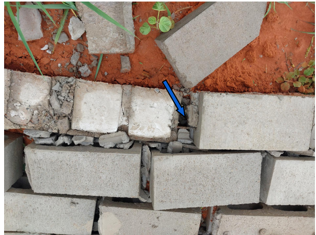
Cintas de amarração com apenas 1 vergalhão de 8mm em desacordo com o projeto.
