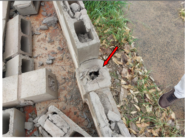
Pilares sem grauteamento e sem armadura.
