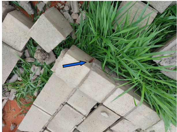
Falta de transpasse das cintas de amarração em desacordo com o projeto, onde deveria ter 30cm de transpasse foi identificado apenas 5cm. No geral não foram encontrados mais pontos de transpasse das armaduras.
