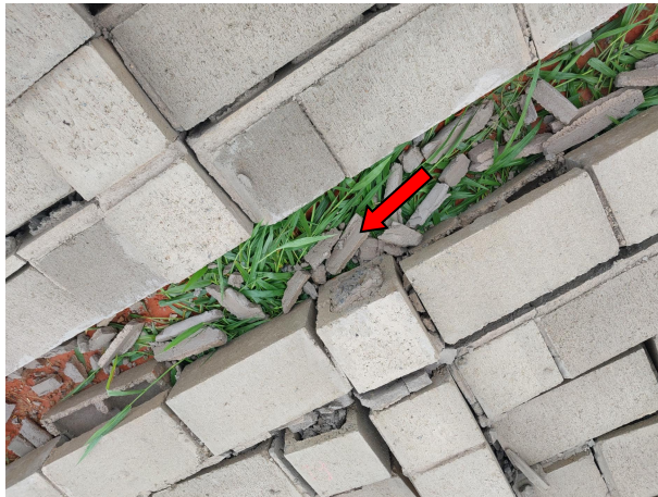
Ausência de Armadura nos pilares.
