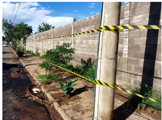
Cintas de amarração com apenas 1 vergalhão de 8mm em desacordo com o projeto qual solicitava 2 vergalhões.
