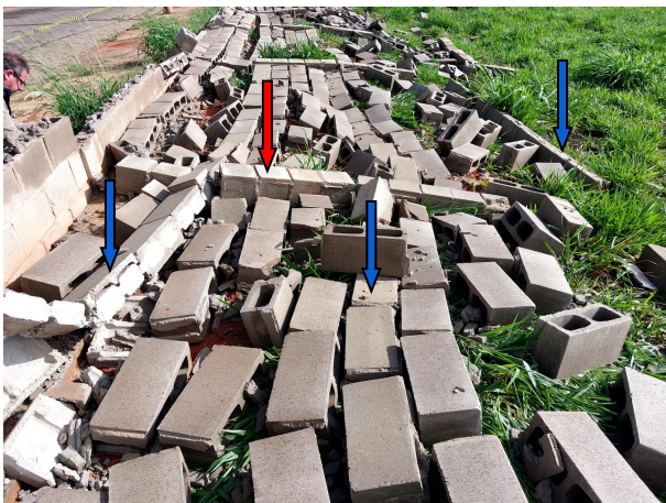
Cintas de amarração (azul), pilares (vermelho). Pilares que deveria estar preenchidos.
