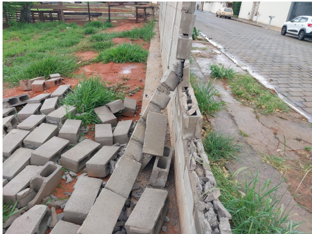
Falta de transpasse das cintas de amarração em desacordo com o projeto, onde deveria ter 30cm de transpasse foi identificado apenas 5cm. No geral não foram encontrados mais pontos de transpasse das armaduras.
