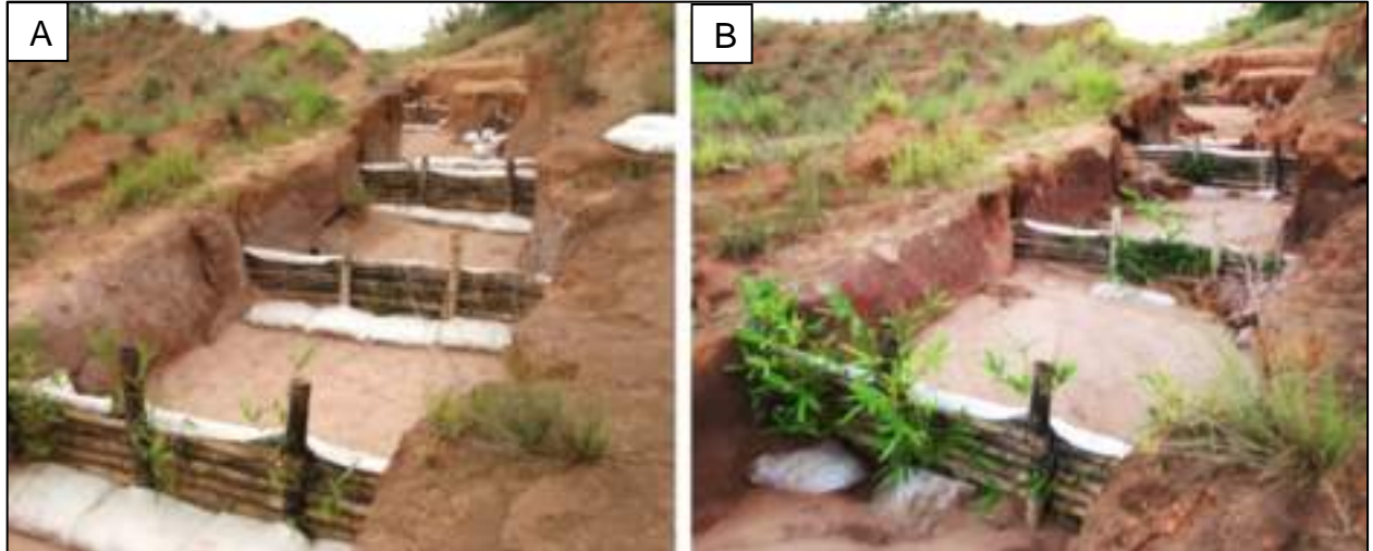
Figura 151 – Paliçadas de bambu e barramento com retentores de sedimentos, fotos de antes (A) e depois (B).
