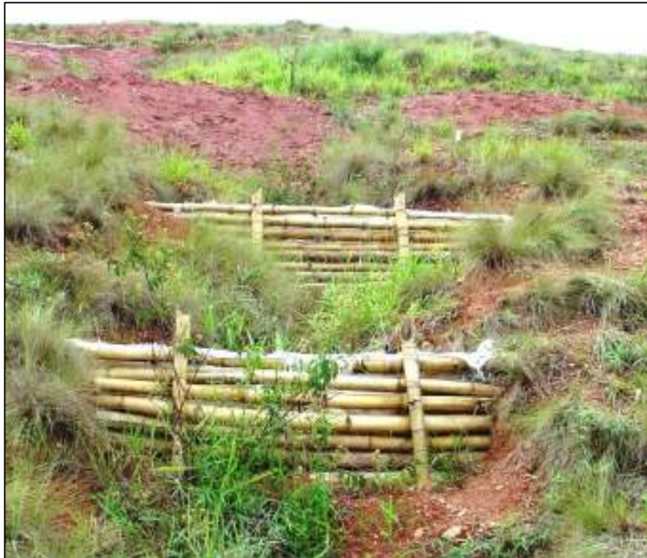
Figura 148 - Paliçada de bambu na contenção da erosão em sulco.
