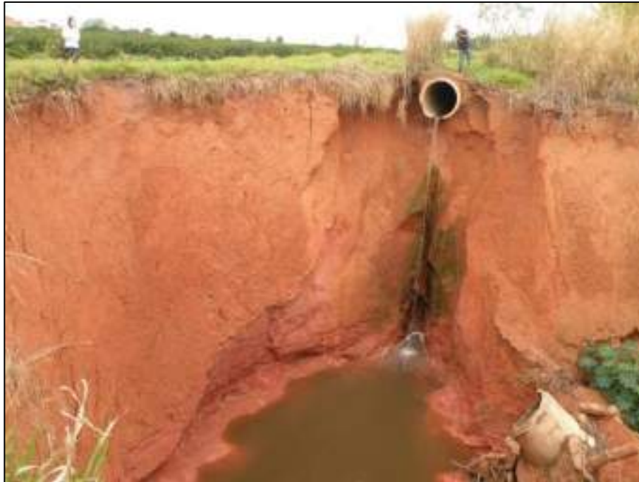
Figura 132 - Processo erosivo desencadeado pelo lançamento das águas pluviais da rede de microdrenagem diretamente na cabeceira de drenagem, sem a presença de obras de dissipadores de energia.
