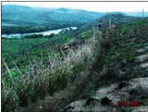
Figura 145 - Cordão em contorno vegetado com capim vetiver em área de encosta.
