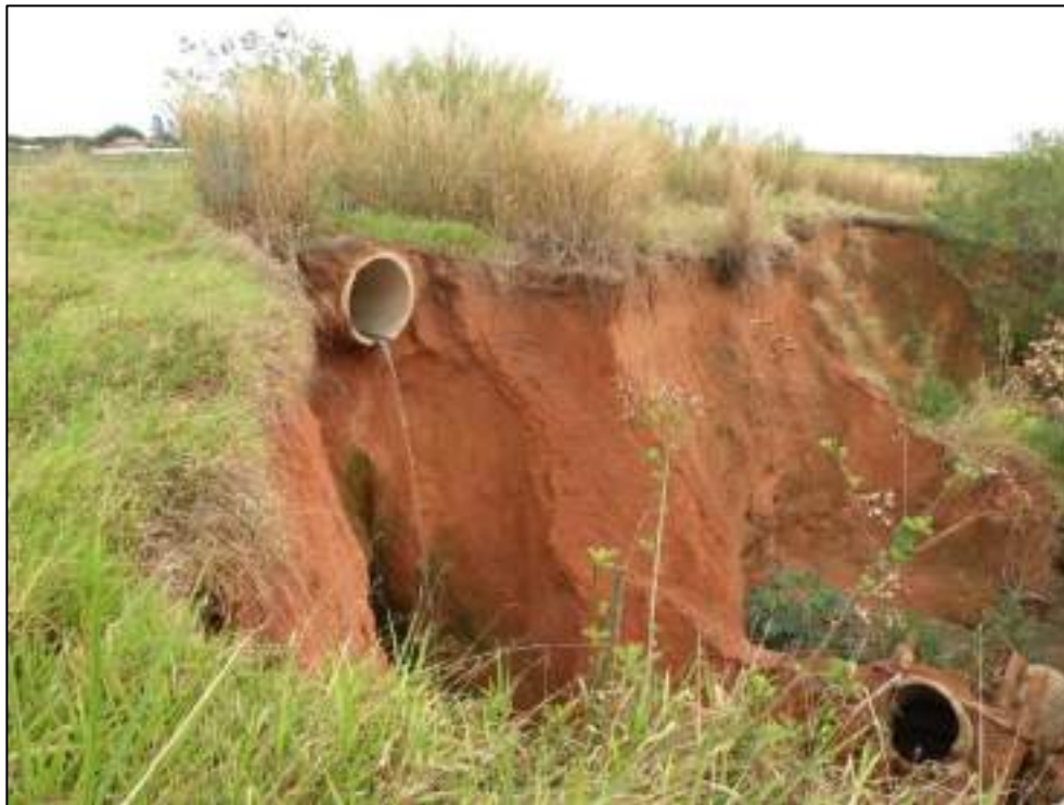
Figura 173 – Vista da cabeceira e da lateral da feição erosiva. Notar no fundo da erosão, parte da tubulação destruída.
