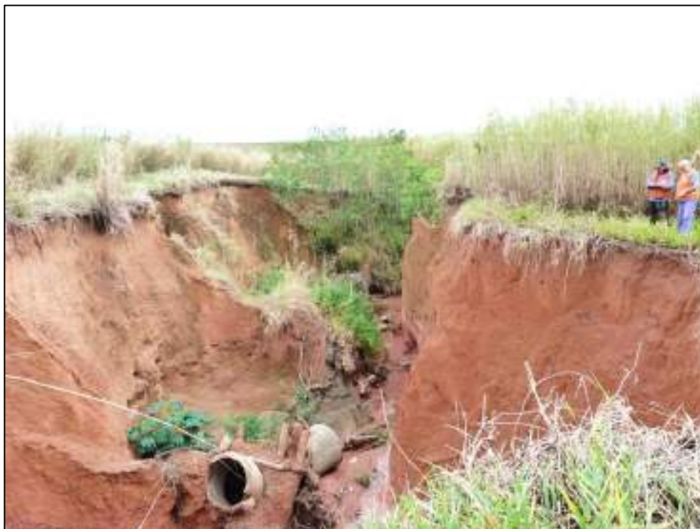
Figura 174 – Vista a jusante da cabeceira da erosão. Notar o dissipador de energia da galeria existente totalmente destruído.
