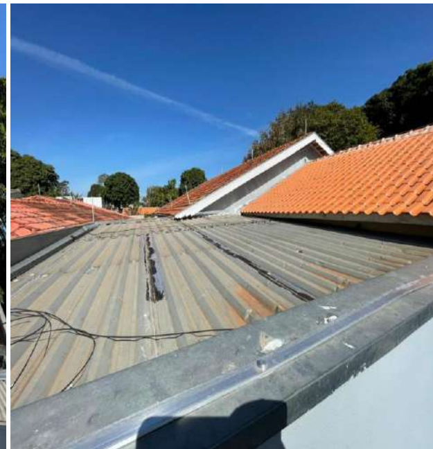
Finalização da obra.
