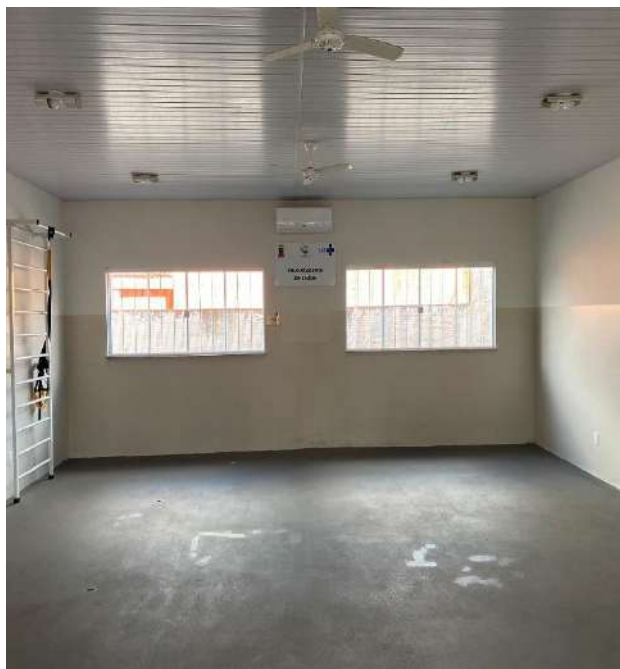
Vistoria inicial da unidade.
