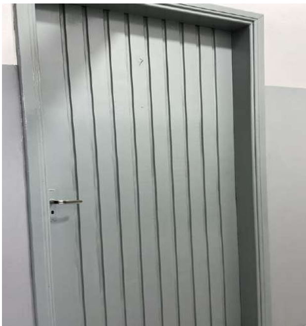
Finalização da pintura da área interna.
