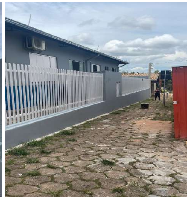
Finalização da obra.
