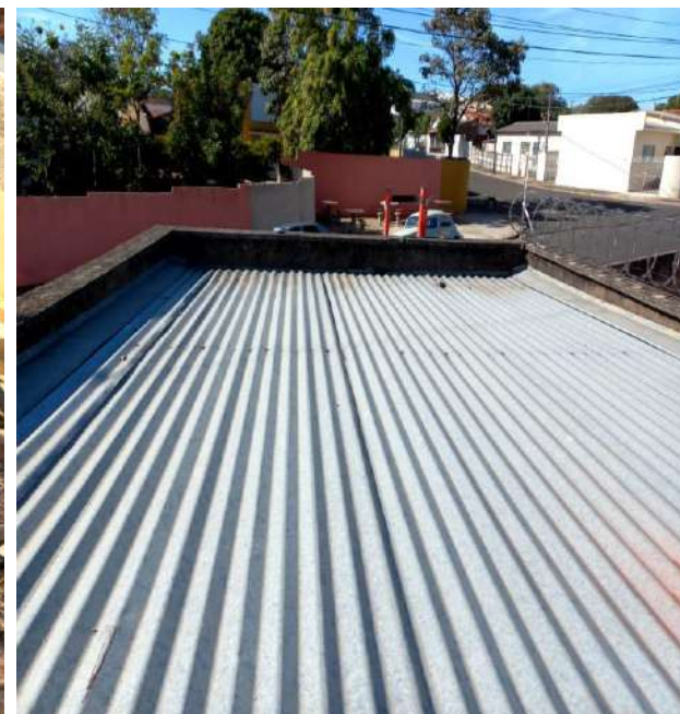
Reparo dos madeiramentos e telhas.
