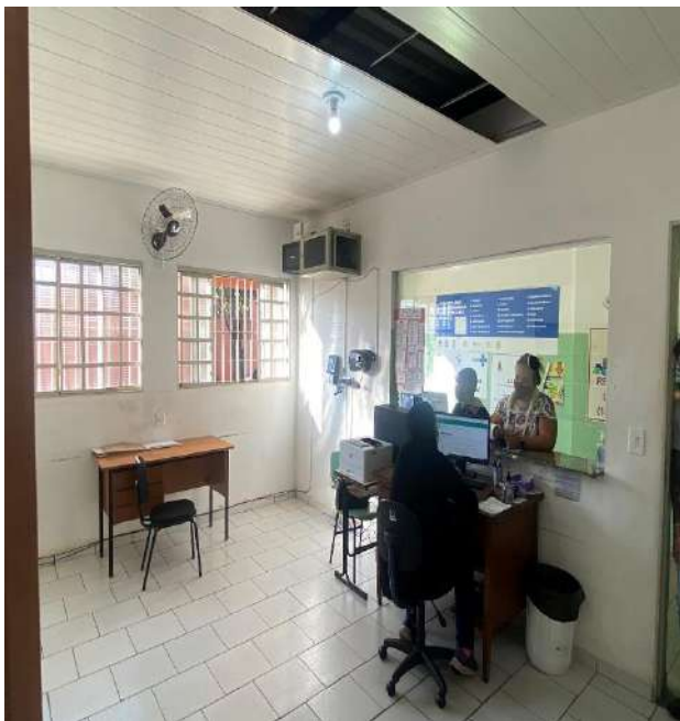
Vistoria inicial da unidade.
