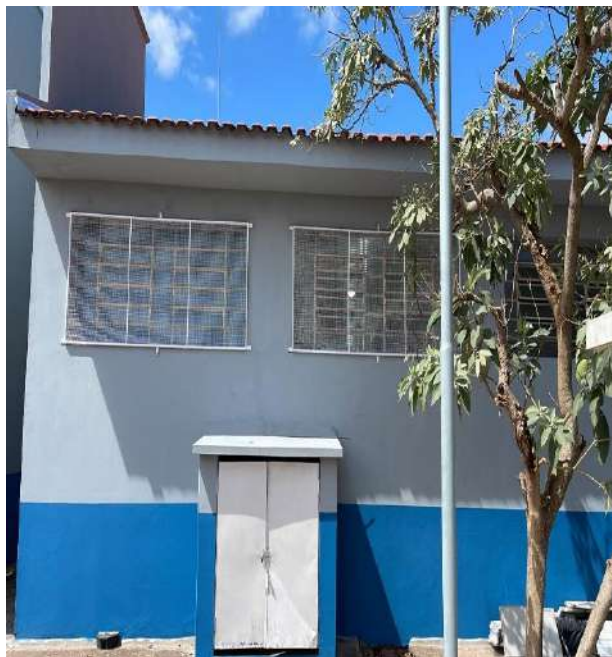
Finalização da pintura da área externa.
