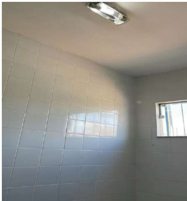
Finalização da pintura da área interna.
