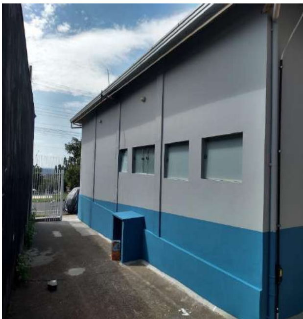
Finalização da pintura externa.
