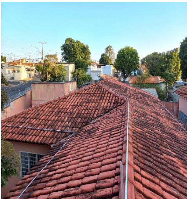
Instalação do SPDA.
