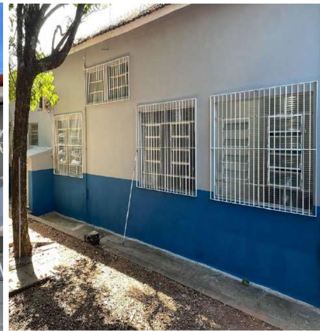
Finalização da obra.
