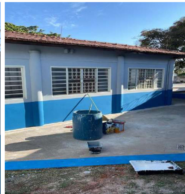
Finalização da obra.
