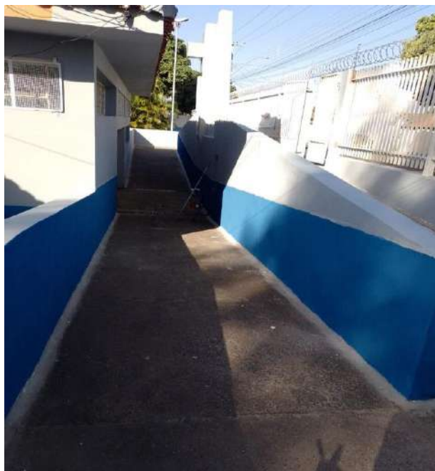
Finalização da pintura da área externa.
