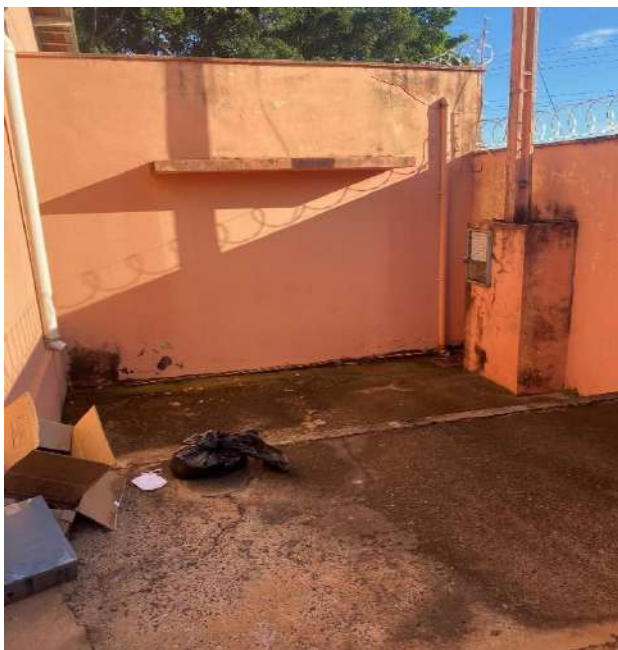
Vistoria inicial da unidade.
