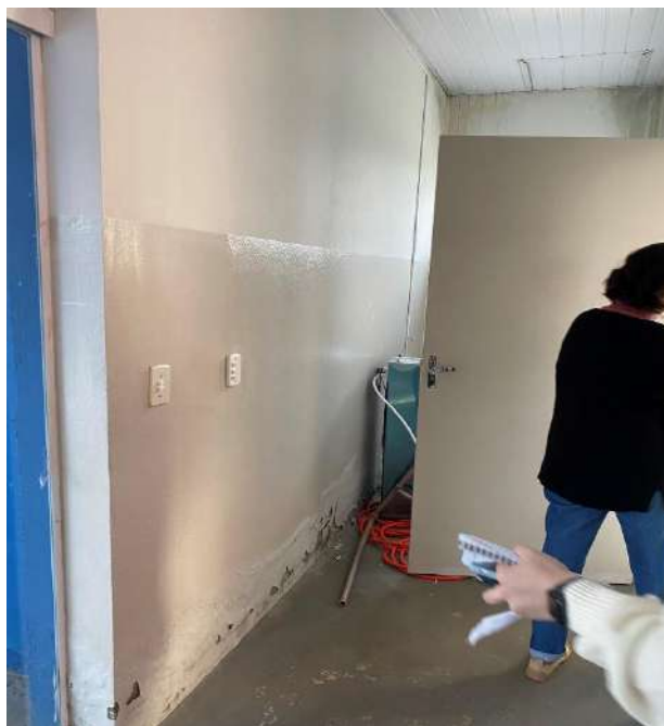
Vistoria inicial da unidade.
