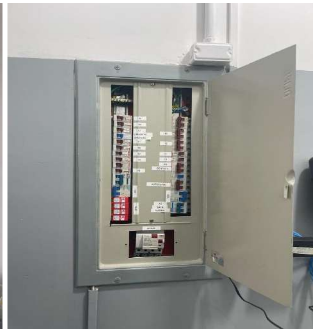
Finalização da obra.
