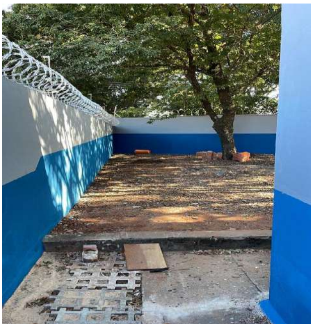
Finalização da obra.
