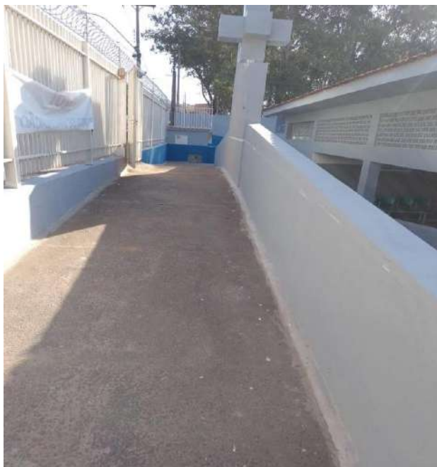
Finalização da pintura da área externa e dos gradis.
