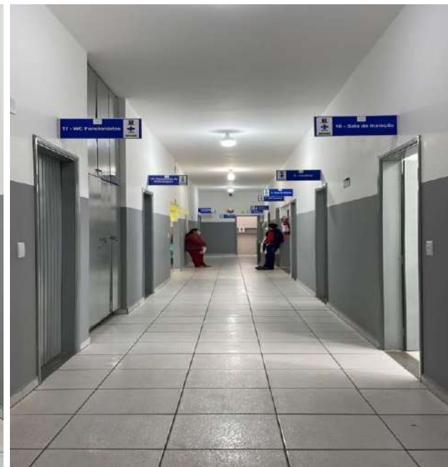
Finalização da pintura da área interna.
