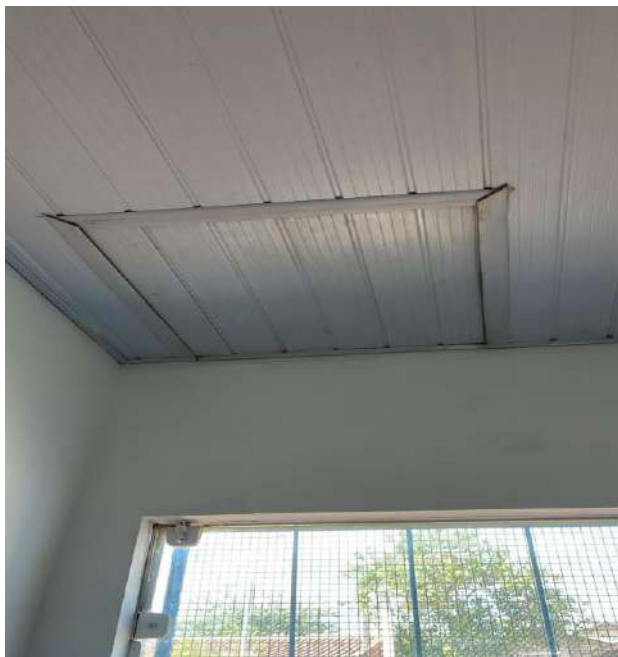
Finalização da pintura da área interna.
