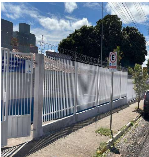
Finalização da pintura da área externa.
