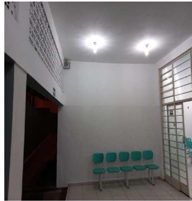
Finalização da pintura interna, unidade Eucaliptos.
