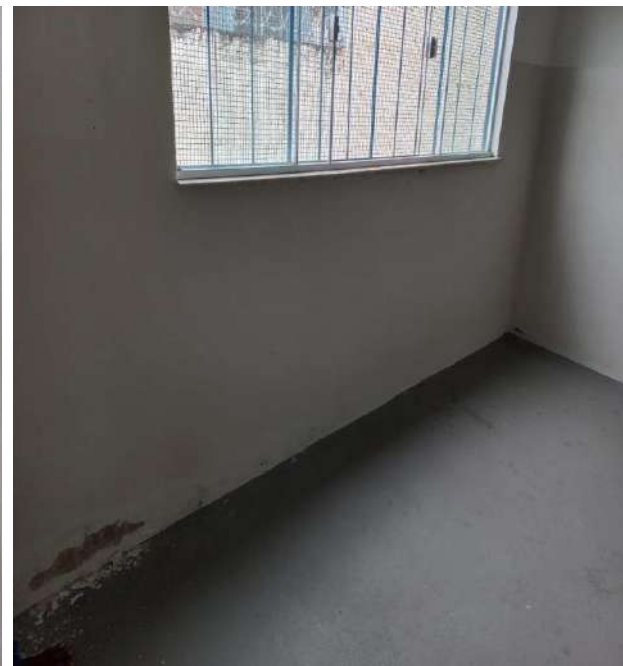
Reparos de trincas unidade polo.
