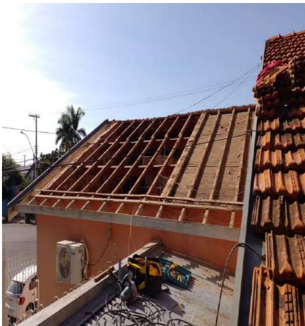
Reparo dos madeiramentos e telhas.
