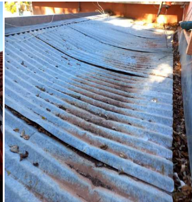
Reparo dos madeiramentos e telhas.
