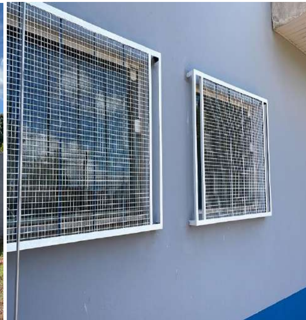
Finalização da pintura da área externa.
