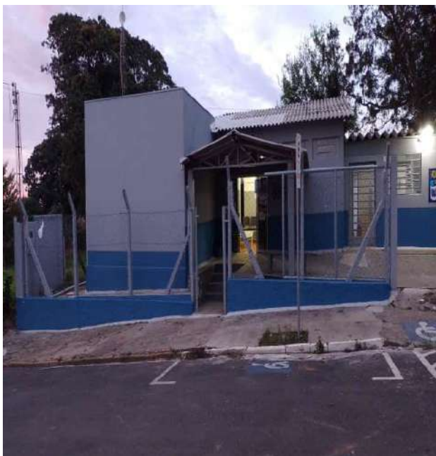
Finalização da pintura.
