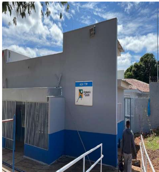
Finalização da pintura da área externa.
