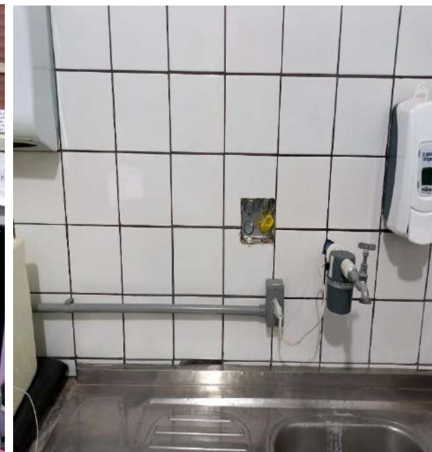
Passagem dos conduítes e troca das tomadas .
