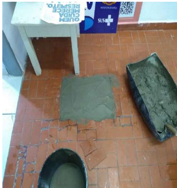
Reparo no piso interno da unidade.
