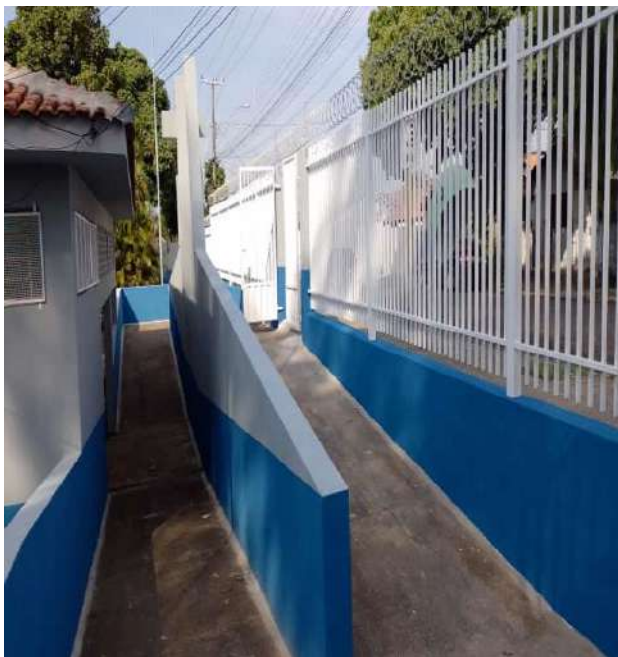
Finalização da obra.
