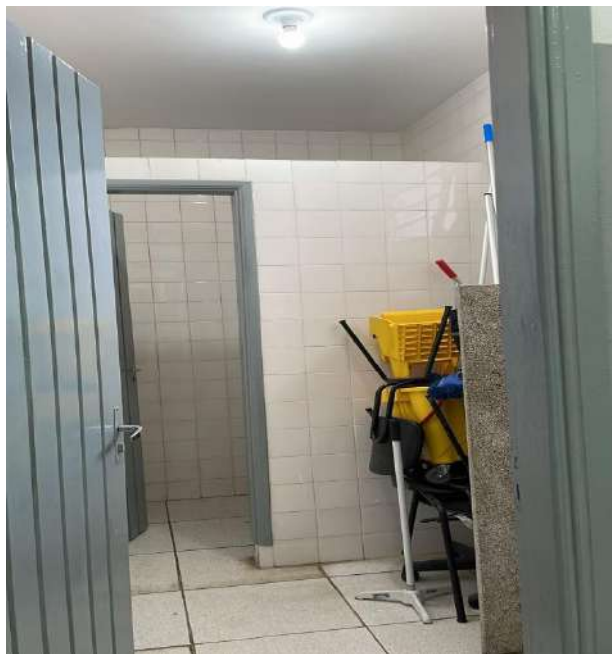
Finalização da pintura da área interna.
