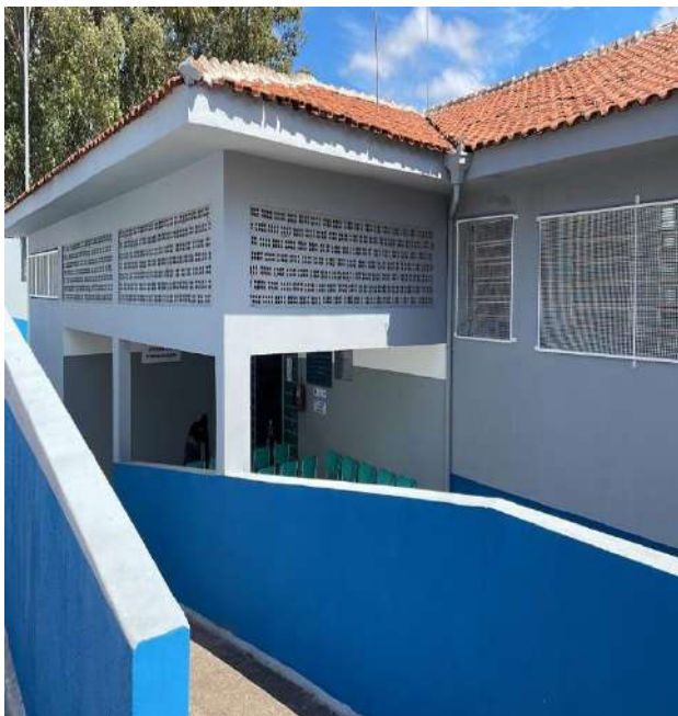
Finalização da pintura da área externa.
