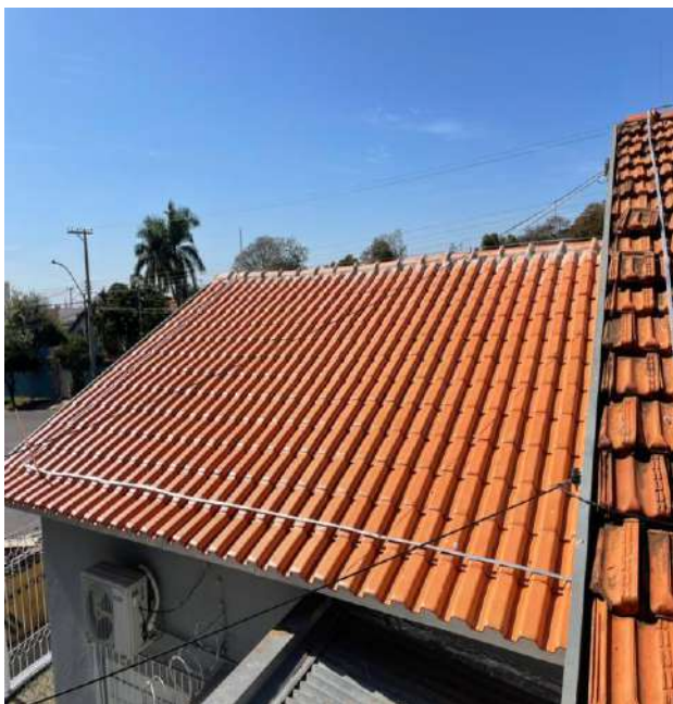
Finalização da obra.
