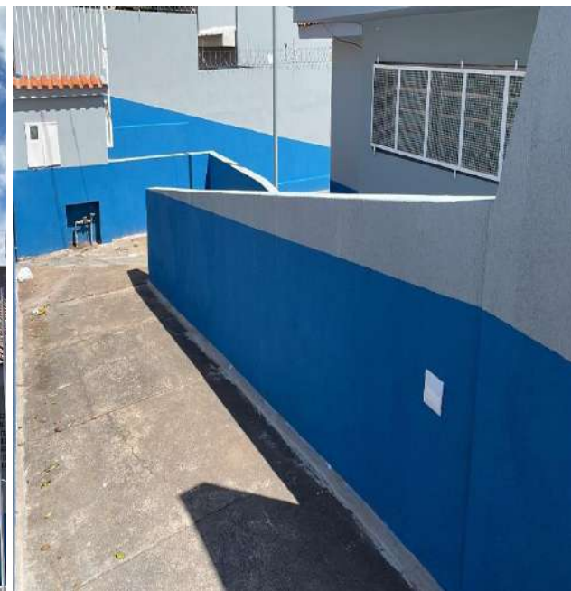
Finalização da pintura da área externa.
