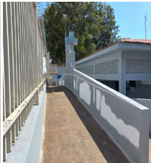
Finalização da pintura da área externa.
