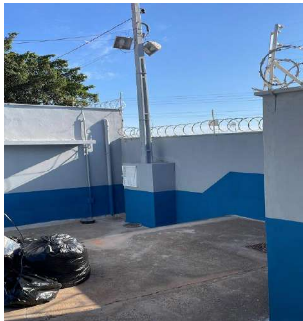
Finalização da obra.
