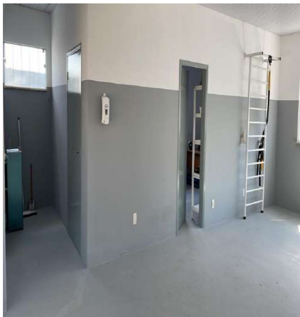
Finalização da pintura da área interna.
