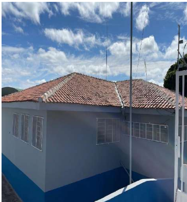
Finalização da pintura da área externa.
