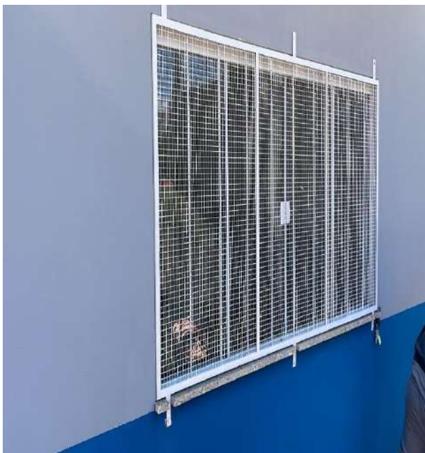
Finalização da pintura da área externa.
