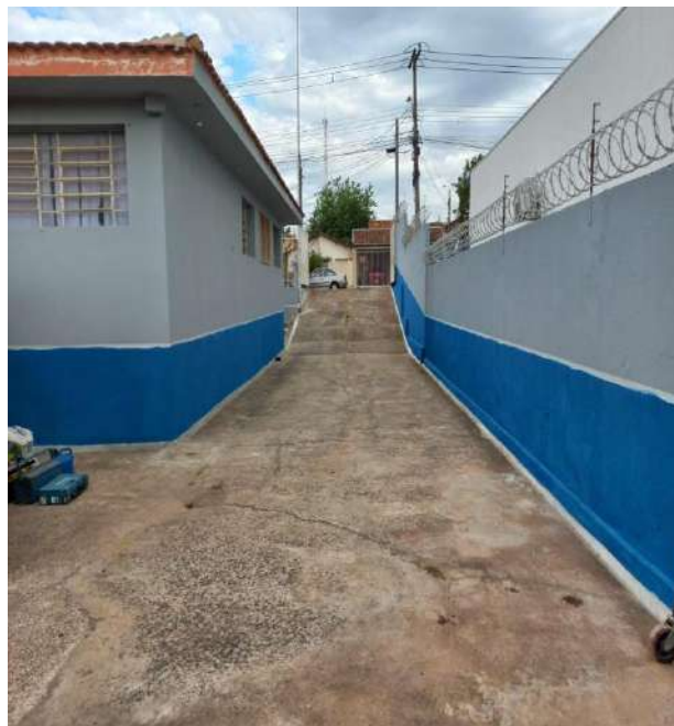
Finalização da pintura externa eucaliptos.
