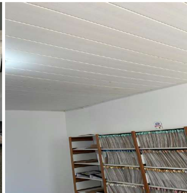
Finalização da obra.
