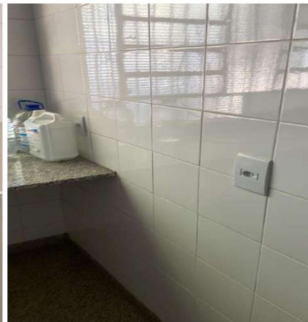
Finalização da obra.
