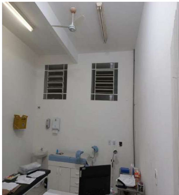
Finalização dos tetos unidade Eucaliptos.
