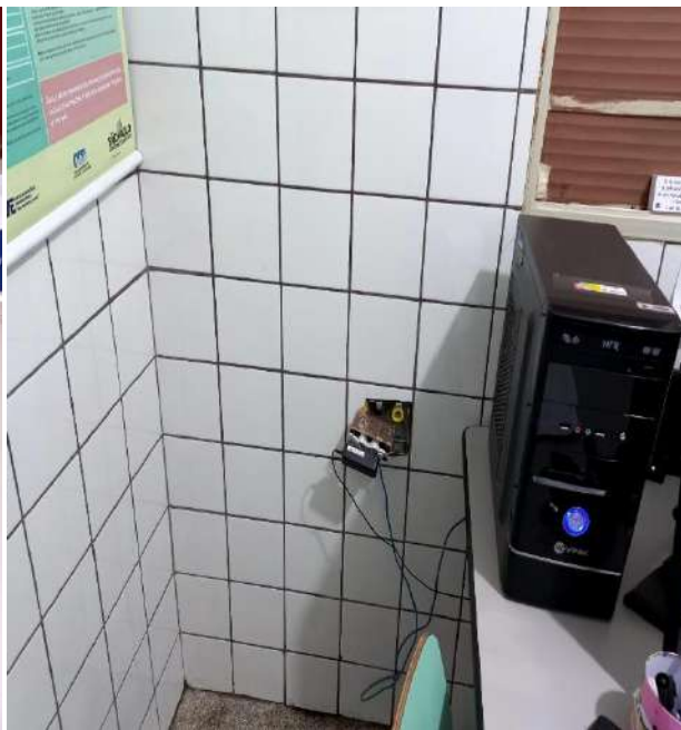
Passagem dos conduítes e troca das tomadas .
