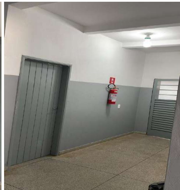
Finalização da obra.
