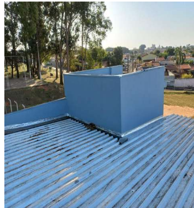
Finalização da pintura da área externa.
