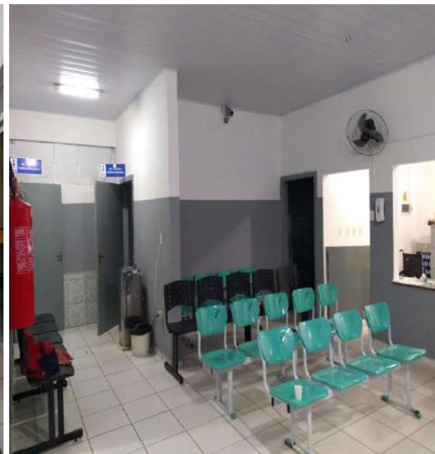
Finalização da pintura interna.
