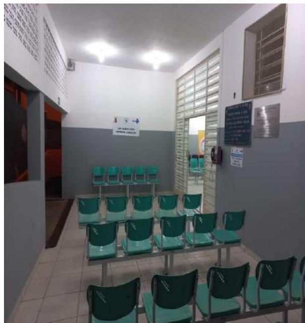
Finalização da pintura da área interna.
