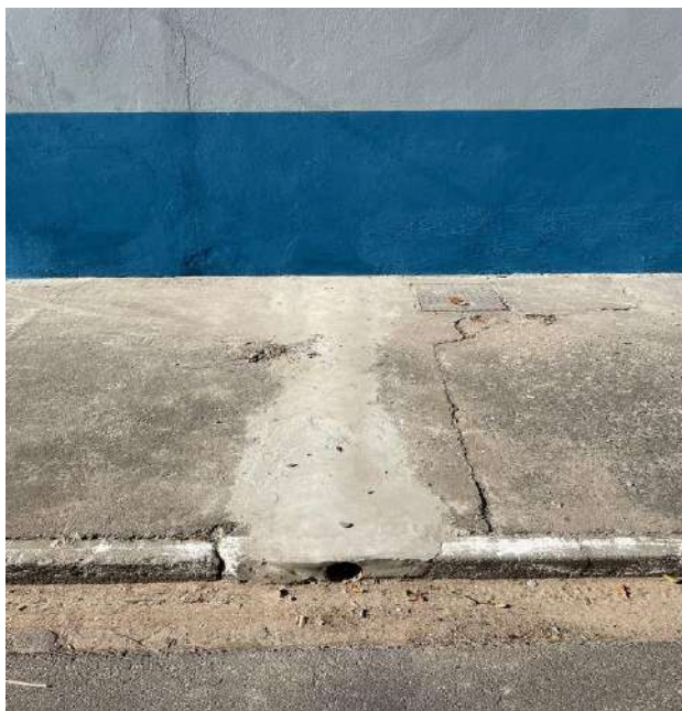
Finalização da obra.
