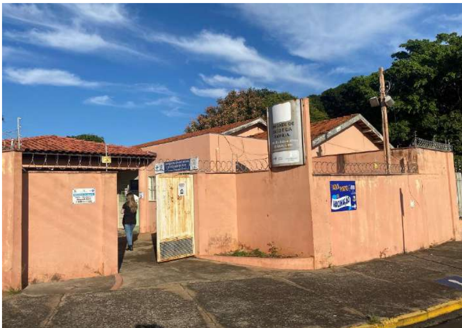
Vistoria inicial da unidade.
