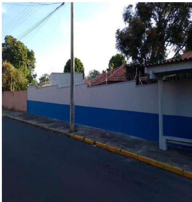
Finalização da obra.
