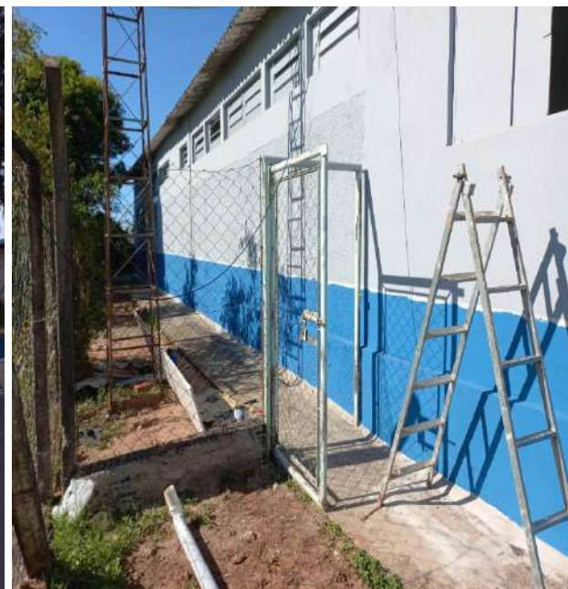
Finalização da pintura.
