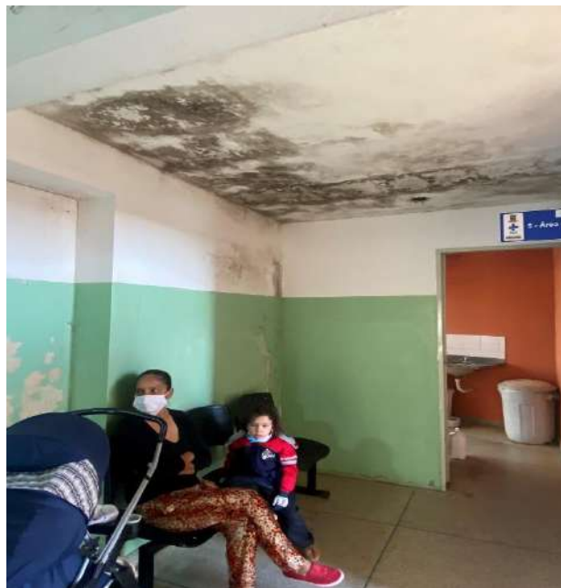
Vistoria inicial da unidade.
