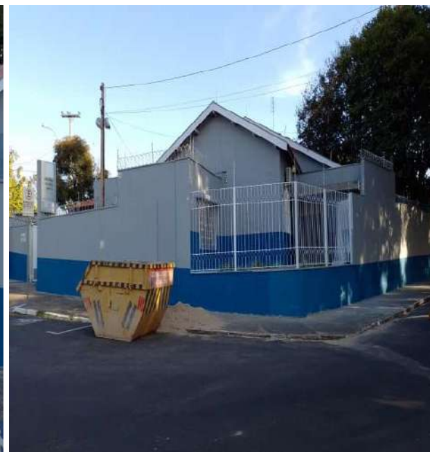
Finalização da obra.
