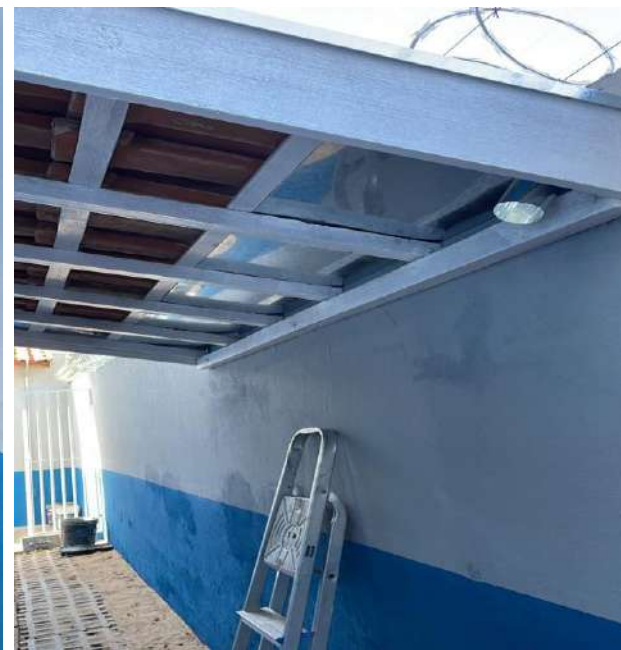
Finalização da obra.
