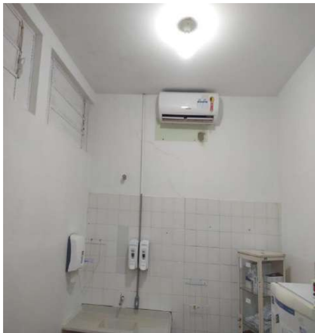
Tratamento de rachaduras e trincas da parte interna dos consultórios.
