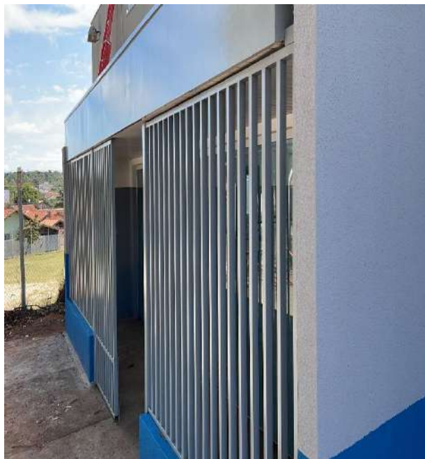
Finalização da pintura da área externa.
