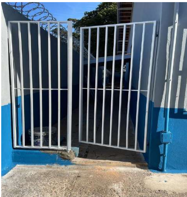
Finalização da obra.
