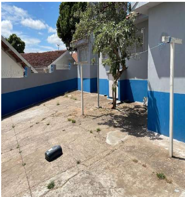
Finalização da pintura da área externa.
