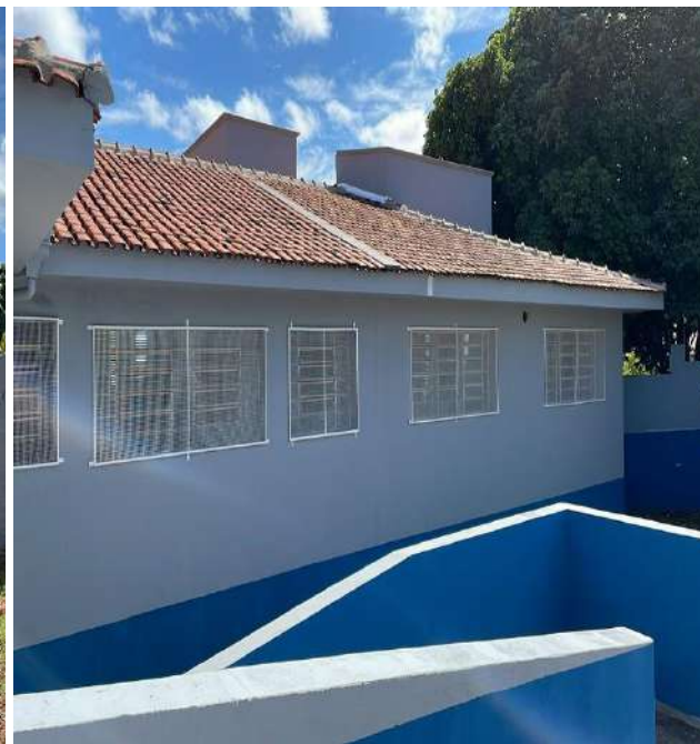
Finalização da obra.
