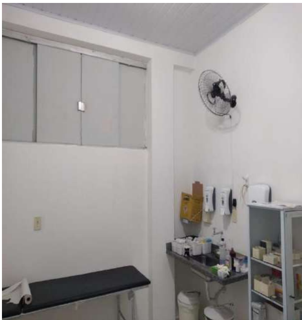
Finalização da pintura interna.
