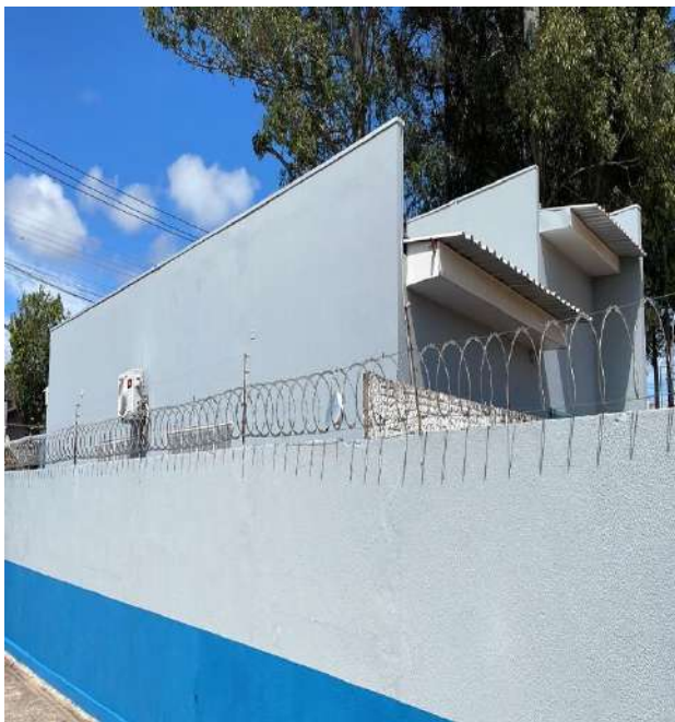
Finalização da pintura da área externa.
