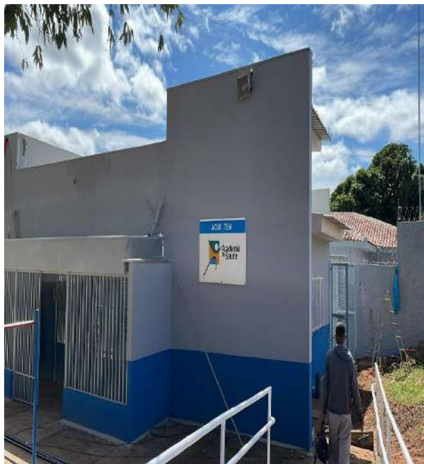
Finalização da obra.
