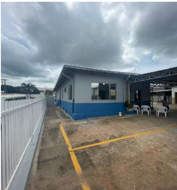
Finalização da obra.
