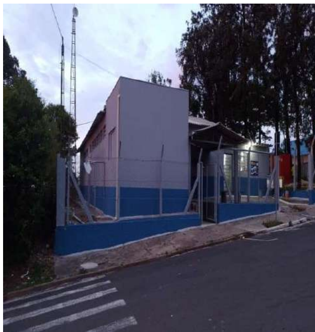
Finalização da pintura.
