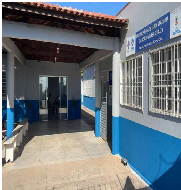
Finalização da obra.
