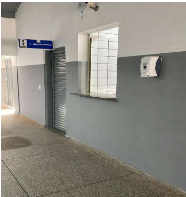
Finalização da obra.
