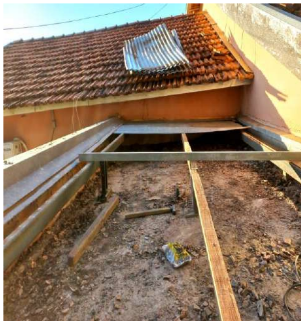
Reparo dos madeiramentos e telhas.
