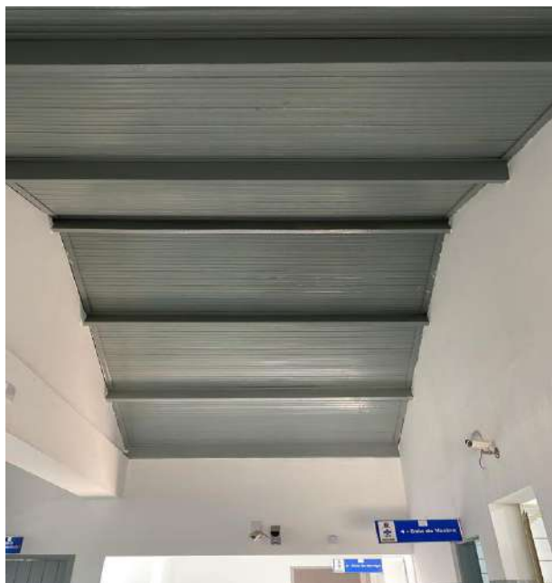
Finalização da obra.
