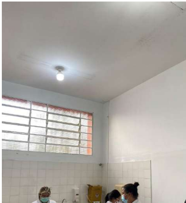
Vistoria inicial da unidade.
