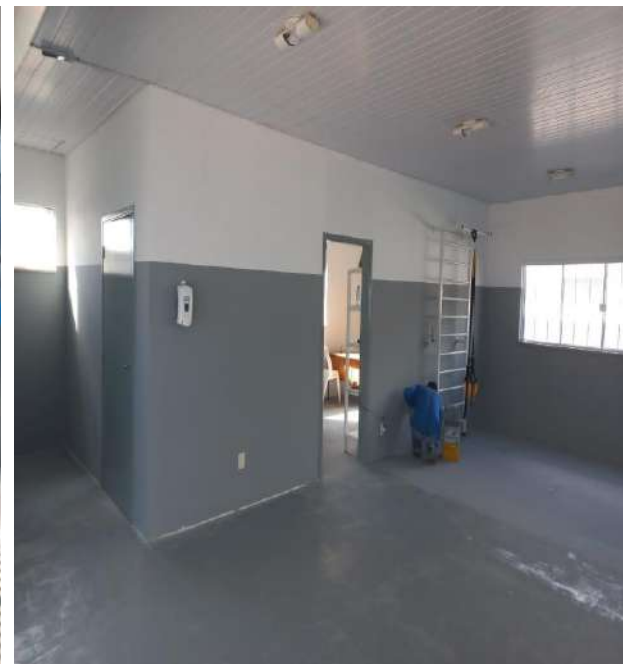
Finalização da pintura da área interna da unidade Polo.
