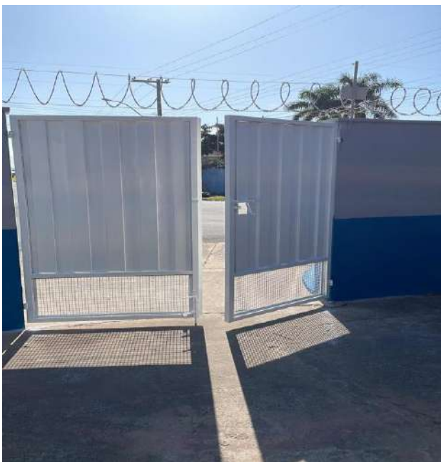
Finalização da obra.
