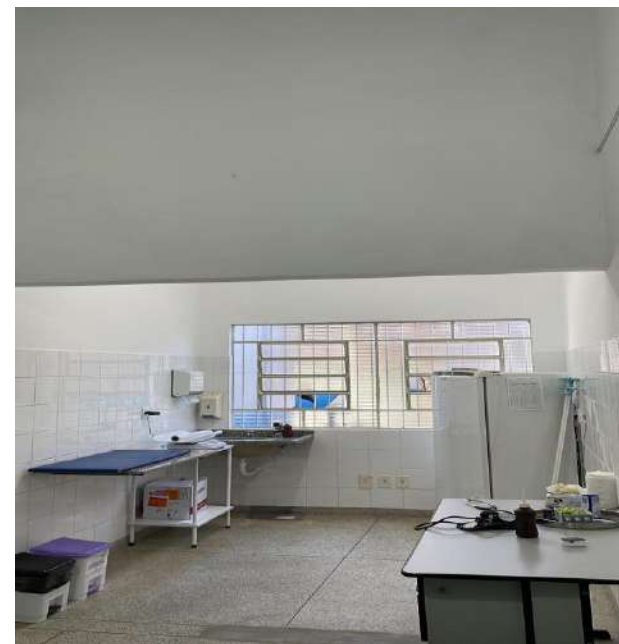
Finalização da obra.
