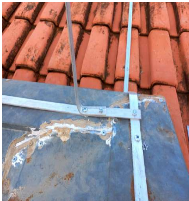
Instalação do SPDA.
