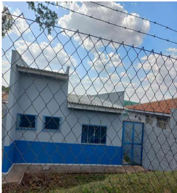
Finalização da pintura da área externa.
