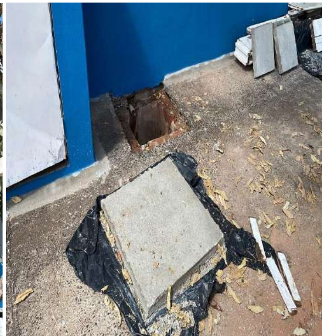
Finalização da pintura da área externa.
