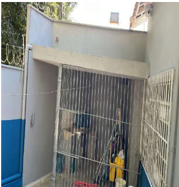
Finalização da obra.
