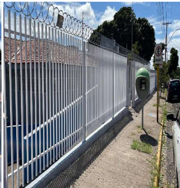
Finalização da pintura da área externa.
