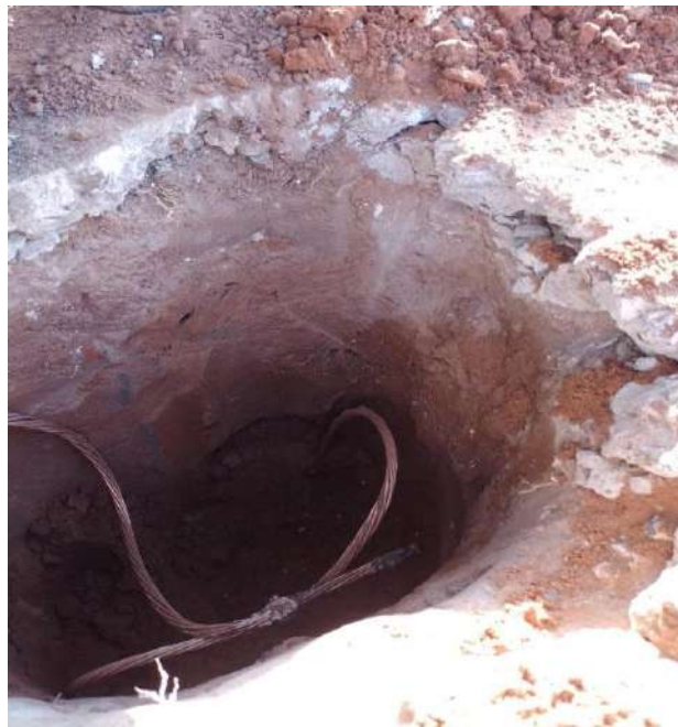
Começo da instalação do SPDA, enterramento dos cabos.
