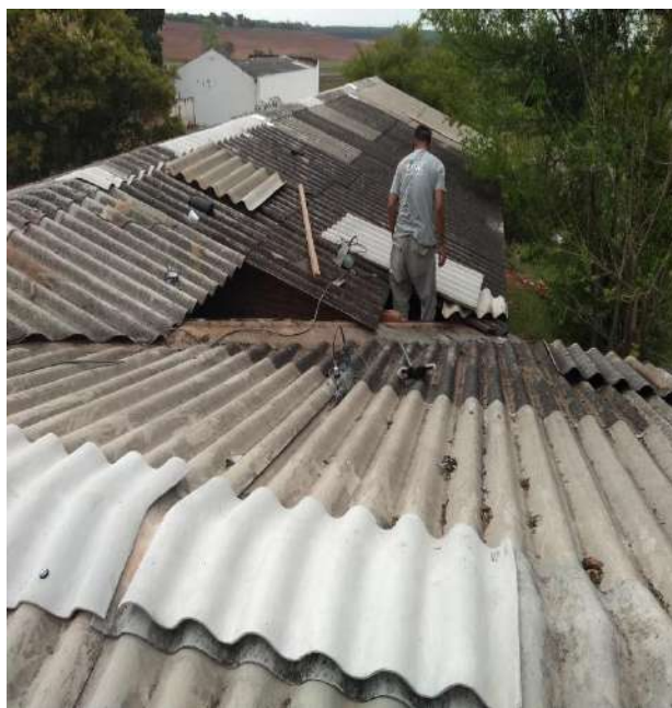
Troca das telhas e madeiramentos danificados.
