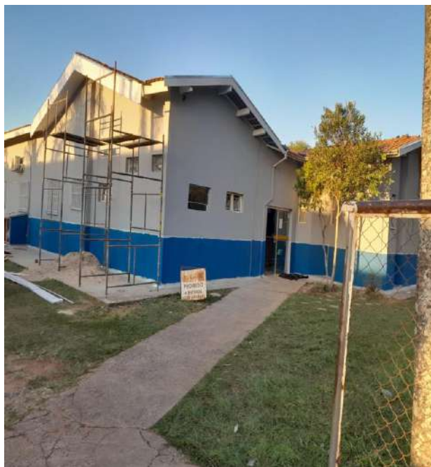
Finalização da obra.
