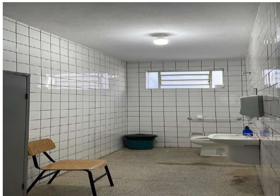
Finalização da obra.
