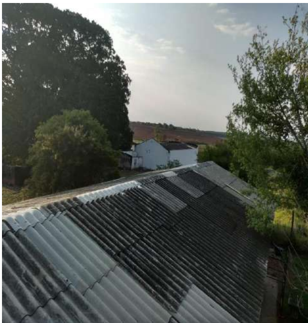
Finalização das trocas de telhas e madeiramentos.
