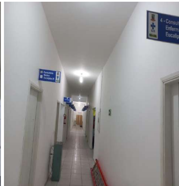
Emassamento e pintura das paredes e dos tetos.
