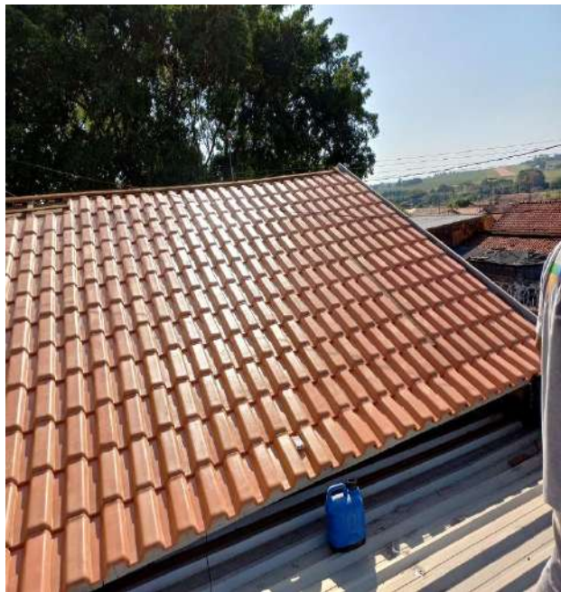
Reparo dos madeiramentos e telhas.
