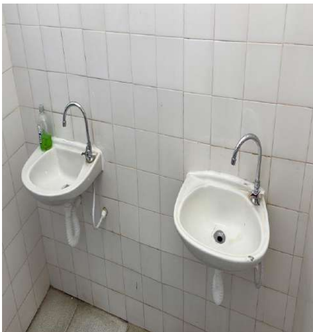
Finalização da pintura da área interna.
