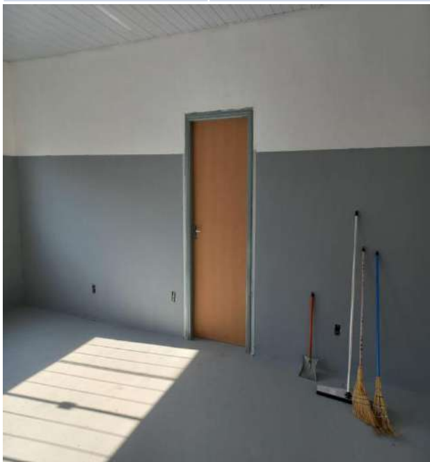
Finalização da pintura da área interna.
