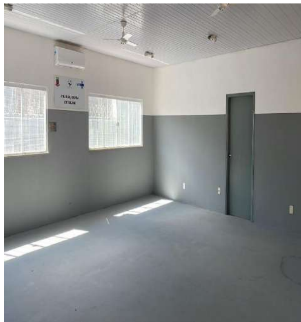
Finalização da pintura da área interna.
