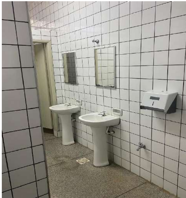
Vistoria inicial da unidade.
