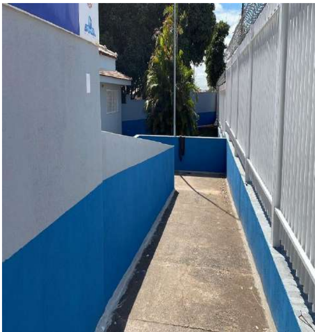
Finalização da pintura da área externa.
