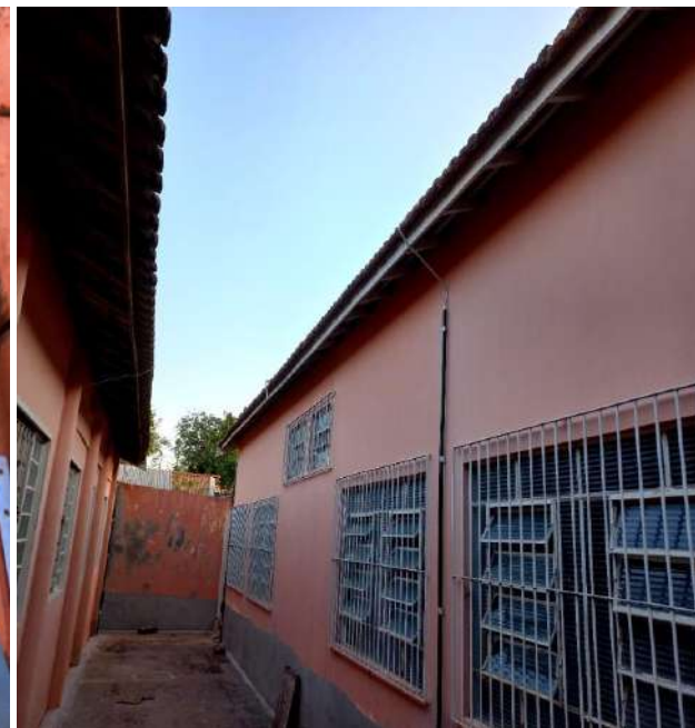
Instalação do SPDA.
