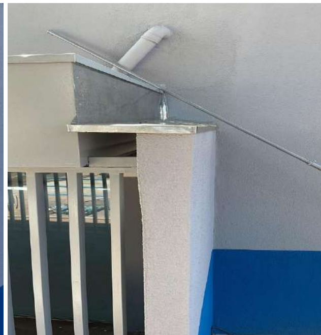
Finalização da pintura da área externa.
