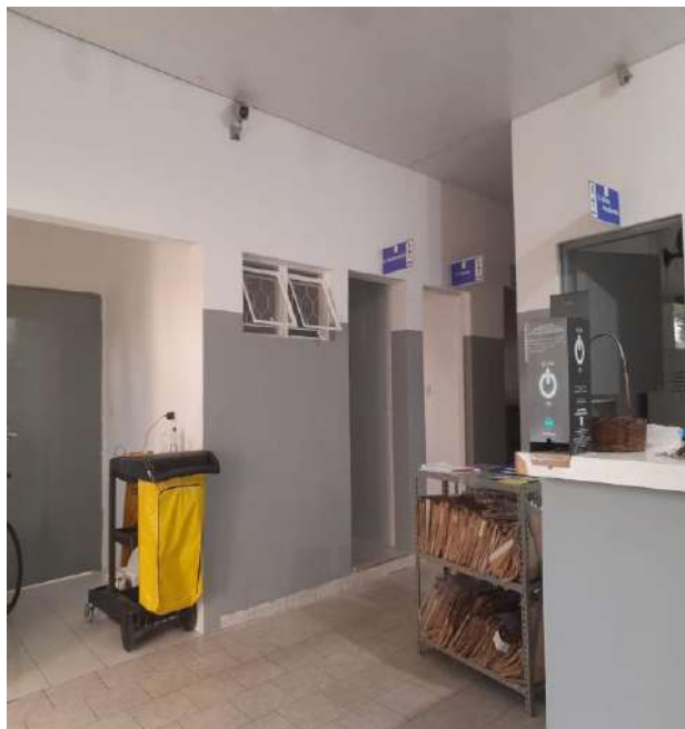
Finalização da obra.
