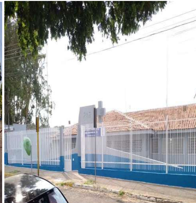
Finalização da obra.
