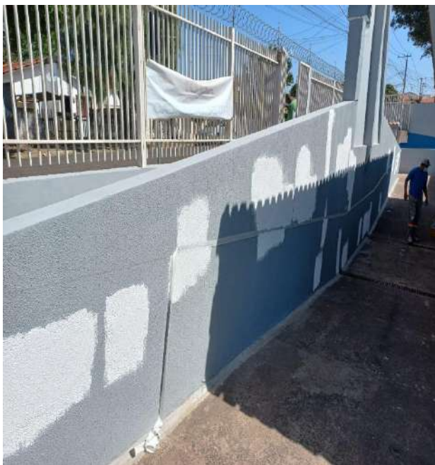
Finalização da pintura da área externa.
