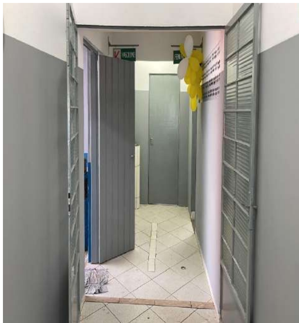
Finalização da pintura da área interna.
