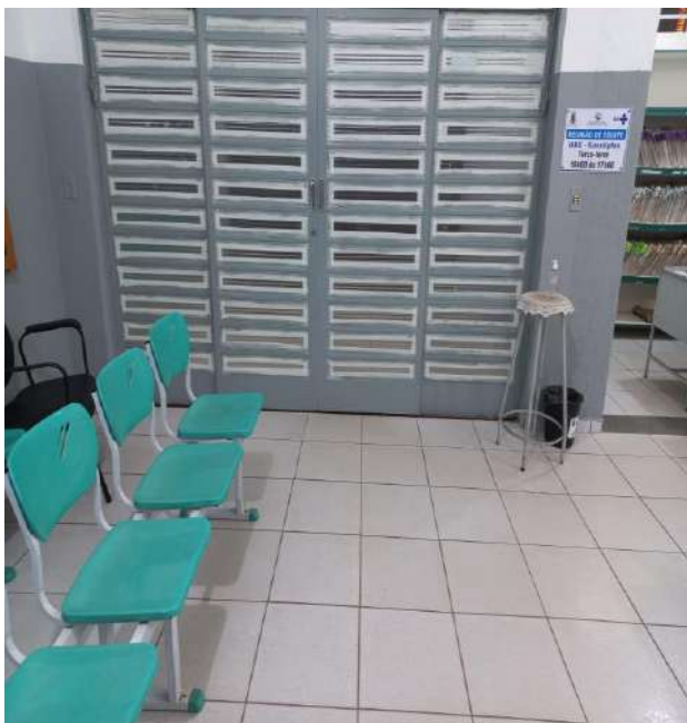
Finalização da pintura da área interna.
