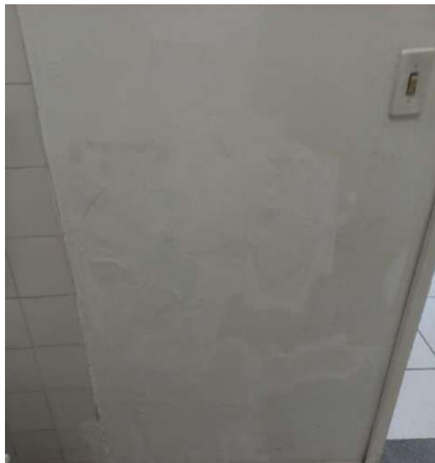
Emassamento das paredes internas, preparação para a pintura.
