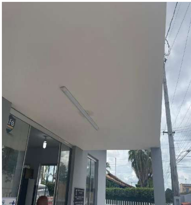
Finalização da obra.
