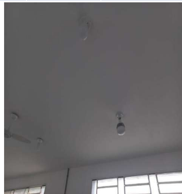
Finalização da pintura da área interna.
