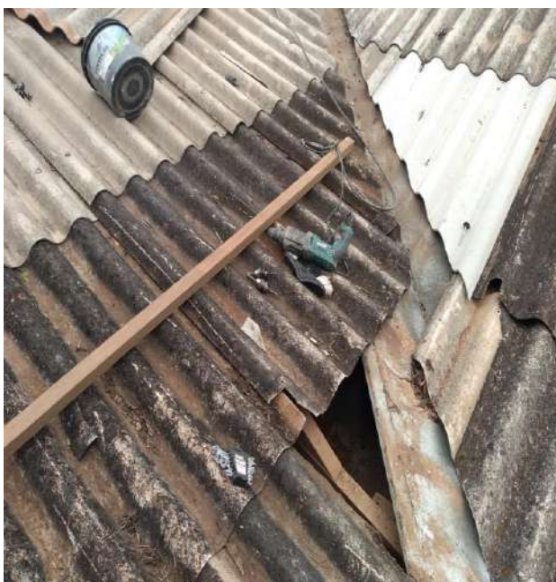
Troca das telhas e madeiramentos danificados.
