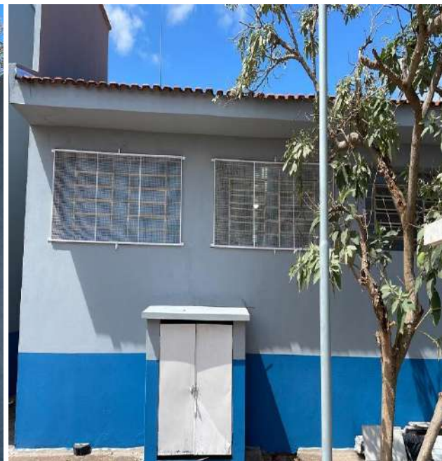
Finalização da pintura da área externa.
