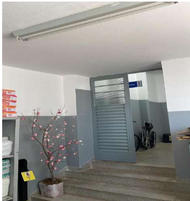
Finalização da obra.
