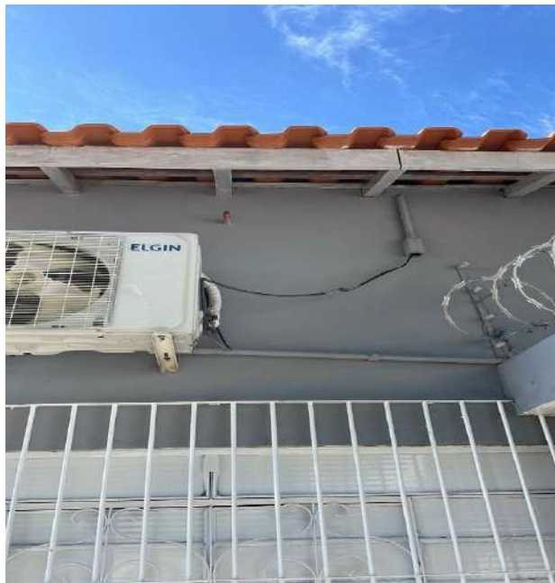
Finalização da obra.
