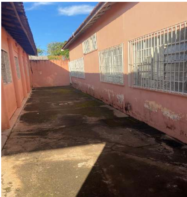
Vistoria inicial da unidade.
