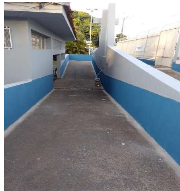
Finalização da pintura da área externa.
