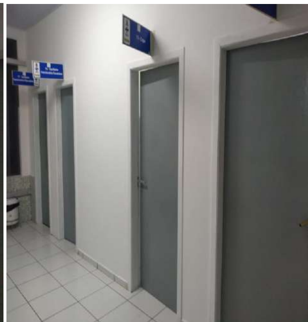
Finalização da pintura interna da unidade.
