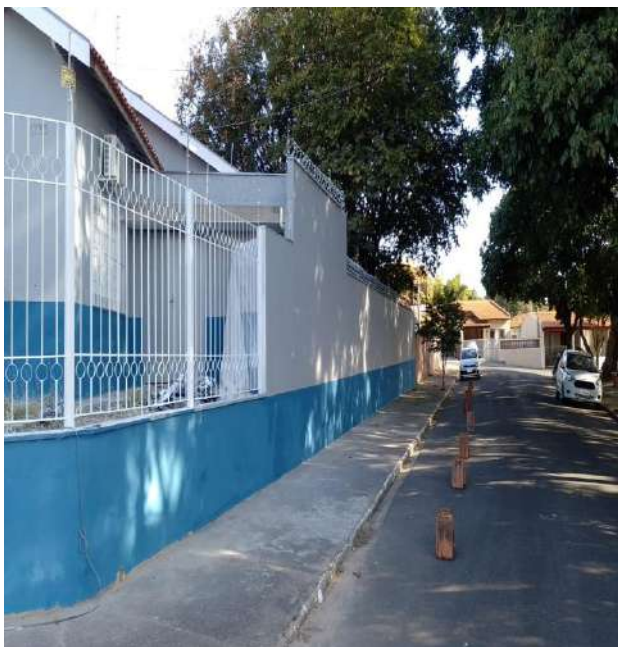
Finalização da obra.
