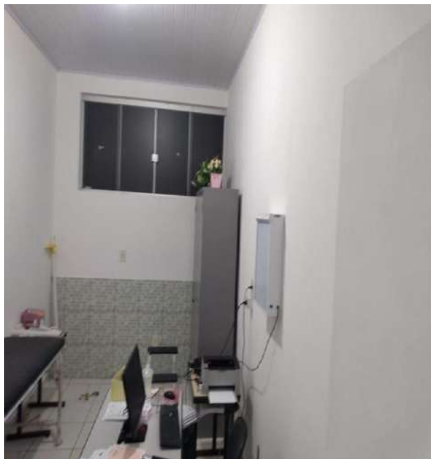
Finalização da pintura interna.
