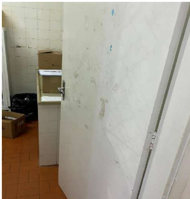
Vistoria inicial da unidade.
