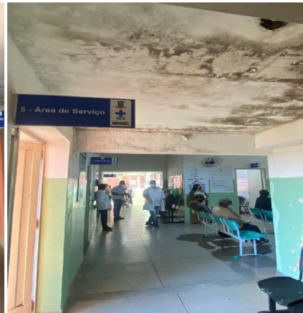
Vistoria inicial da unidade.
