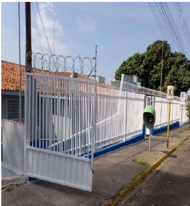
Finalização da obra.
