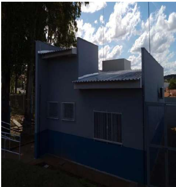
Finalização da obra.
