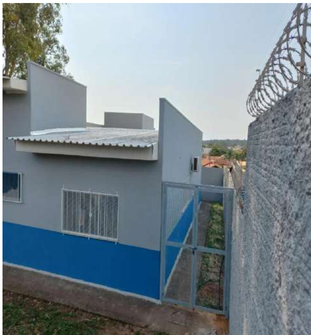
Finalização da pintura da área externa.
