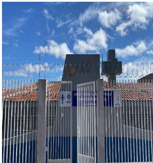
Finalização da pintura da área externa.
