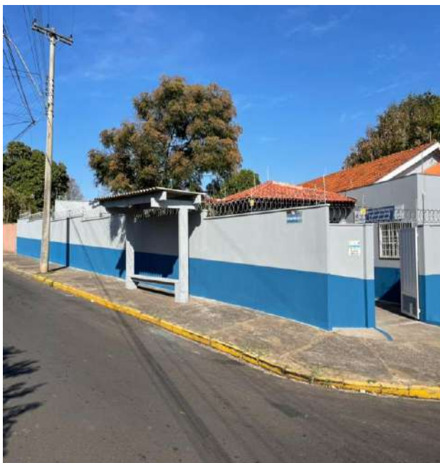
Finalização da obra.
