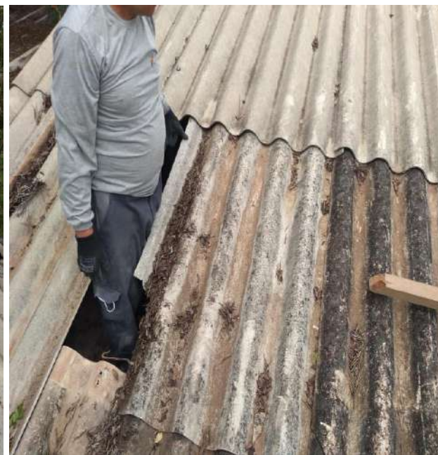
Troca das telhas e madeiramentos danificados.
