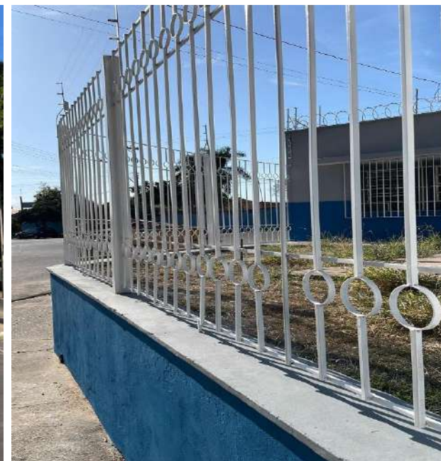
Finalização da obra.
