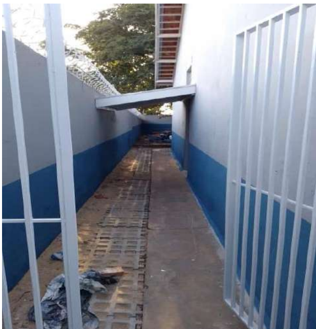
Finalização da obra.
