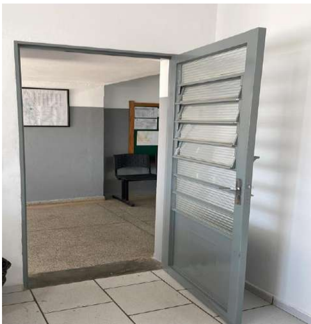
Finalização da obra.
