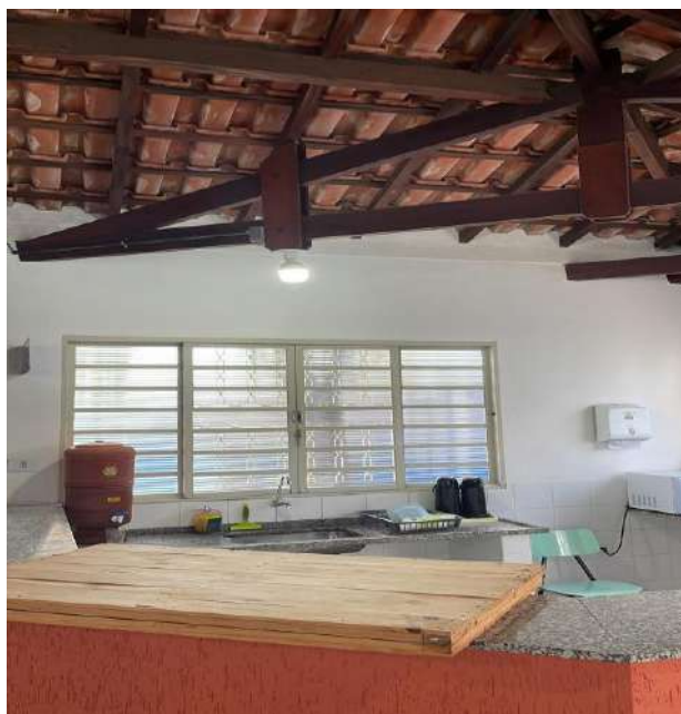
Finalização da obra.
