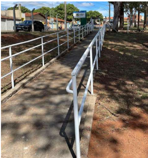
Finalização da pintura da área externa.
