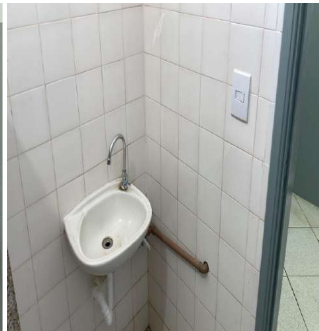
Finalização da pintura da área interna.
