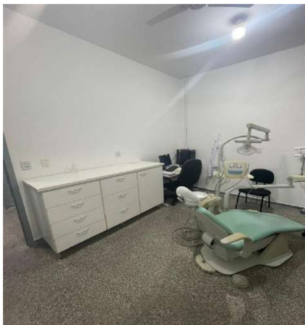
Finalização da obra.
