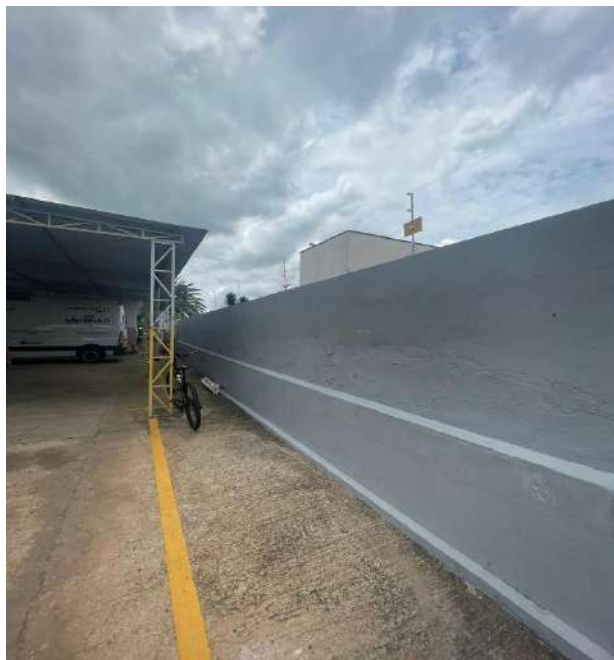
Finalização da obra.
