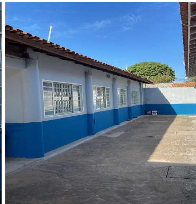
Finalização da obra.
