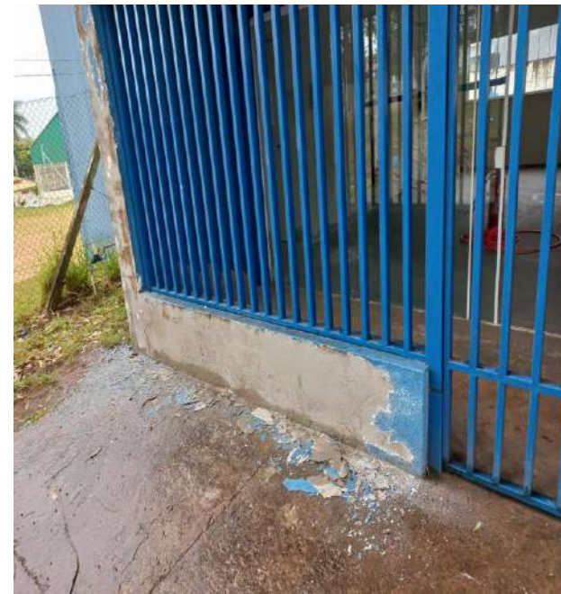
Reparo de trincas unidade polo.
