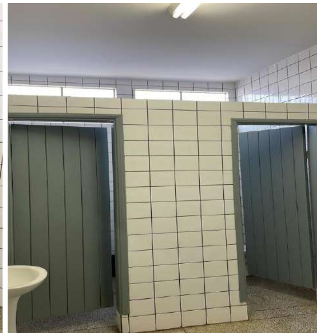
Finalização da obra.
