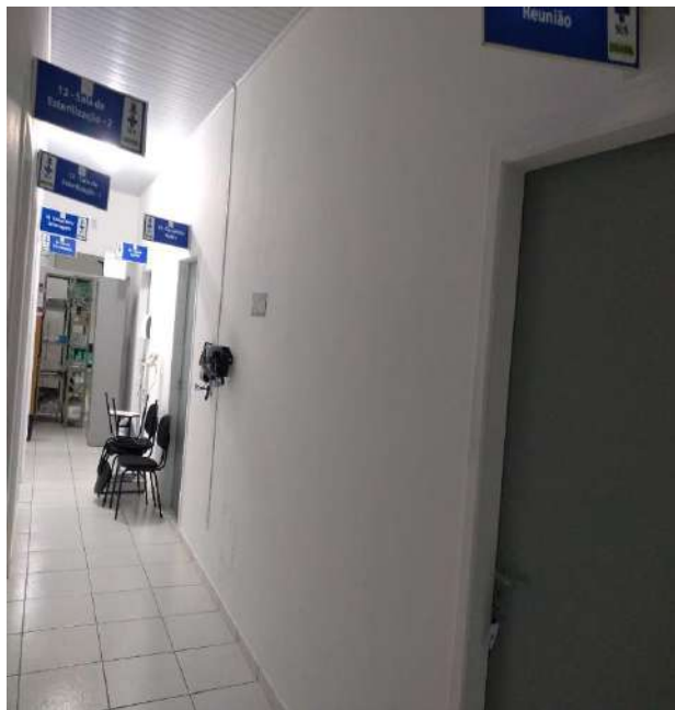
Finalização da pintura interna da unidade.
