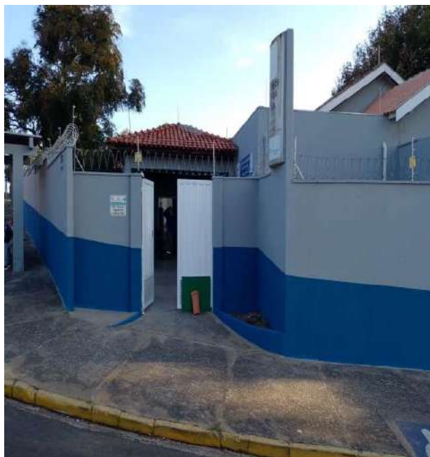
Finalização da obra.
