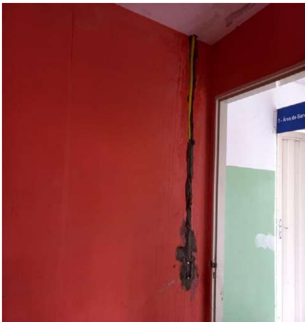
Passagem dos conduítes e troca das tomadas .
