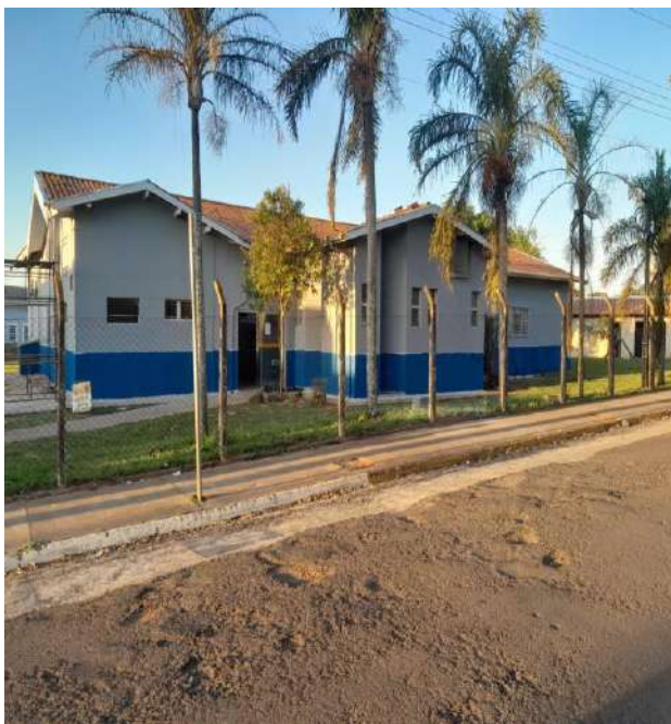
Finalização da obra.
