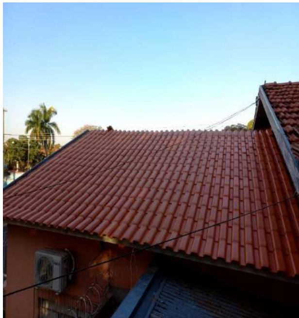
Reparo dos madeiramentos e telhas.
