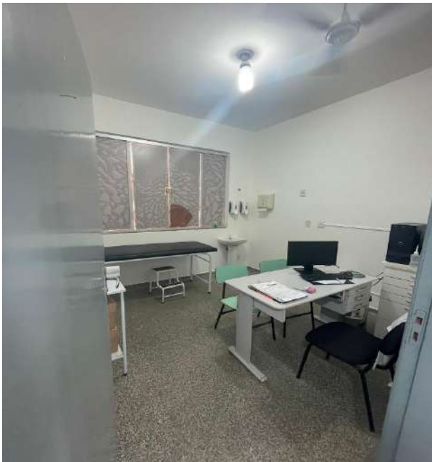
Finalização da obra.
