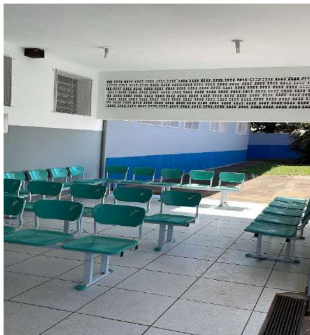
Finalização da pintura da área interna.
