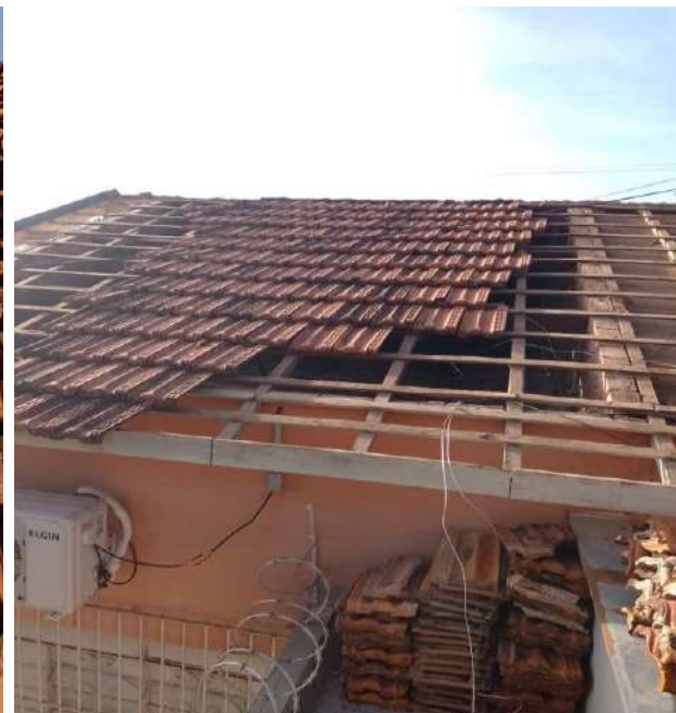
Reparo dos madeiramentos e telhas.
