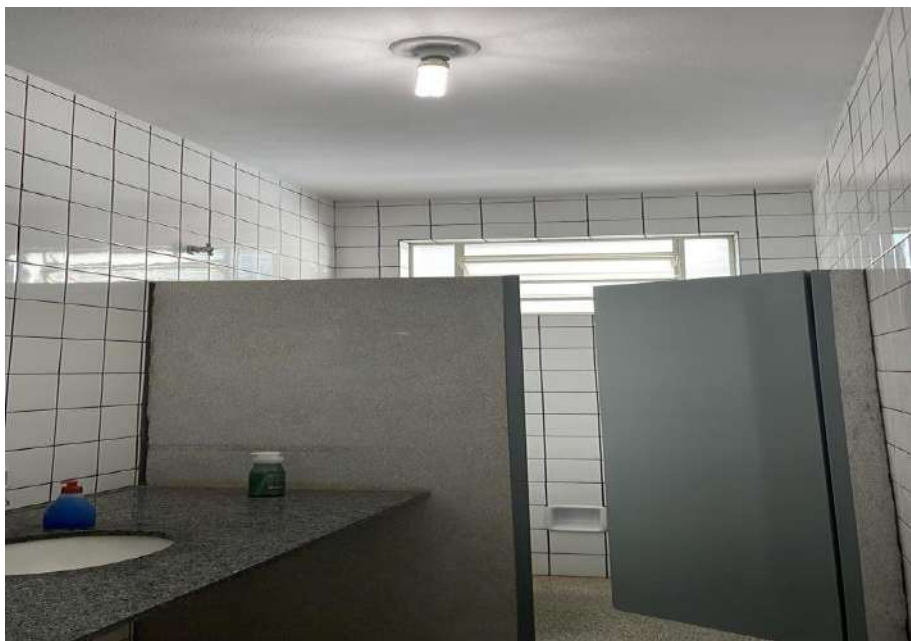
Finalização da obra.
