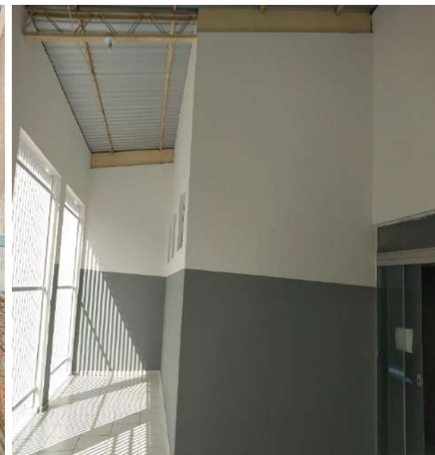
Finalização da pintura externa.
