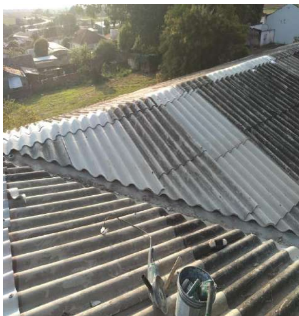
Finalização das trocas de telhas e madeiramentos.
