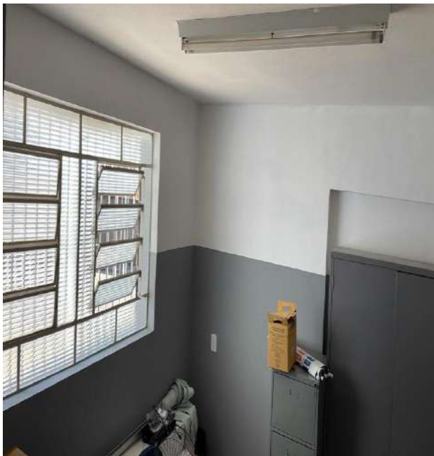
Finalização da obra.
