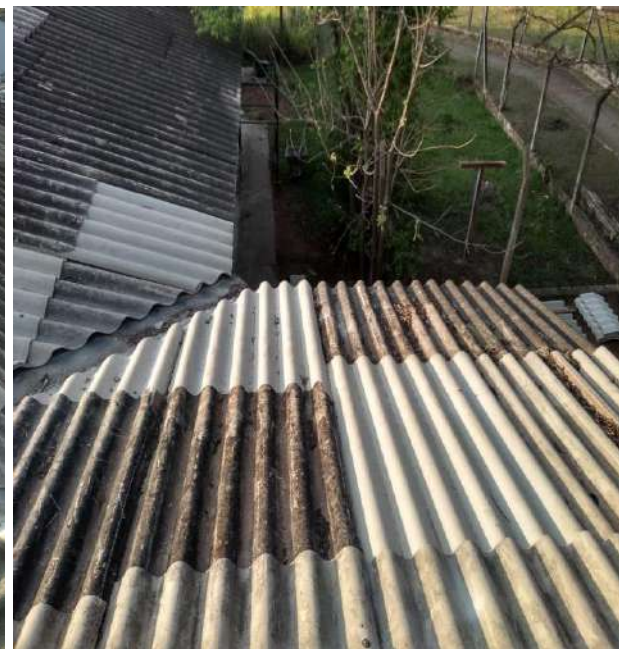
Finalização das trocas de telhas e madeiramentos.
