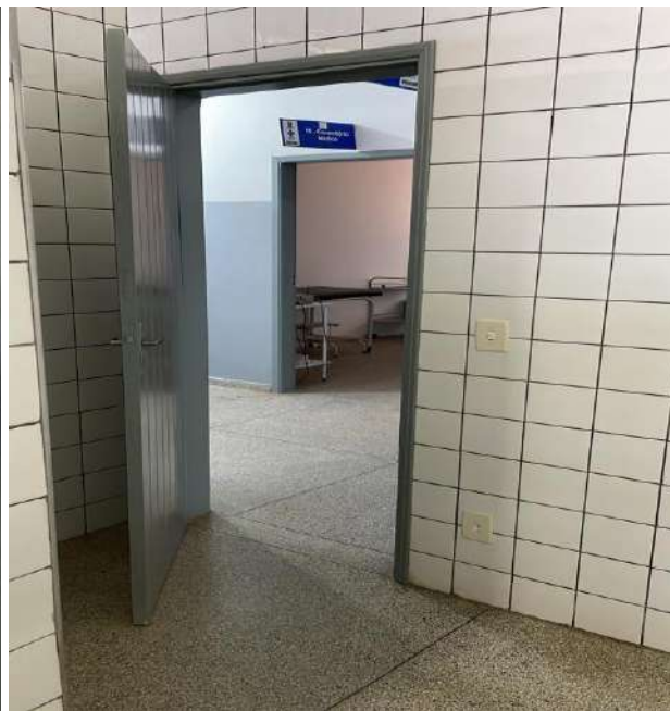
Finalização da obra.
