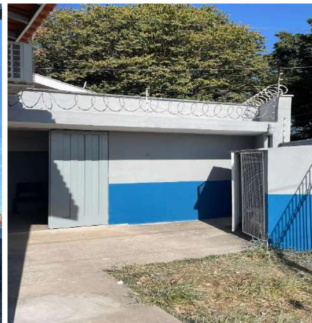
Finalização da obra.
