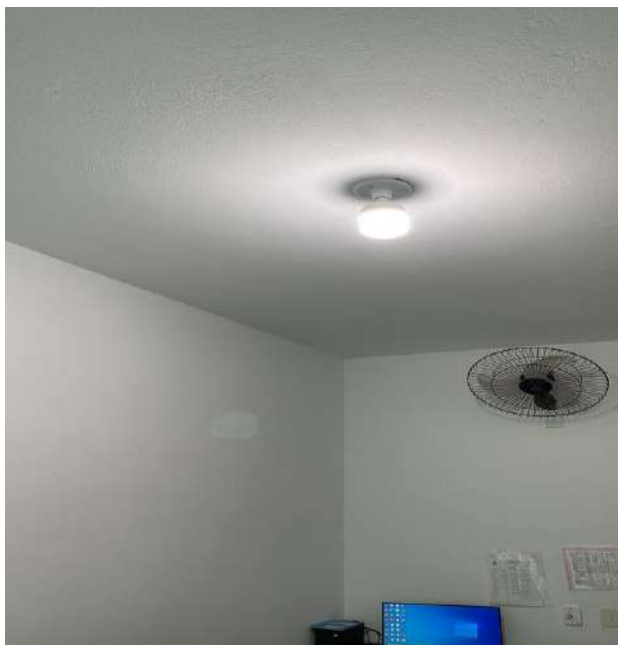
Finalização da obra.
