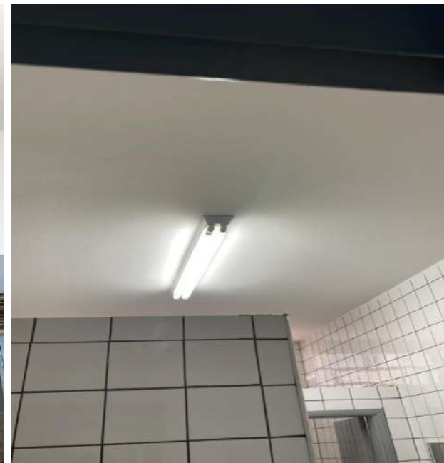
Finalização da obra.
