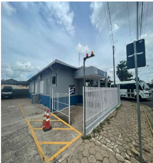
Finalização da obra.
