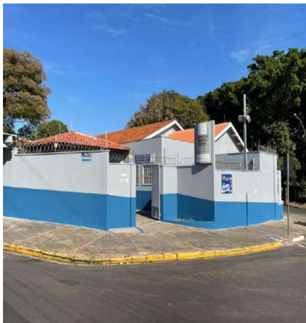
Finalização da obra.
