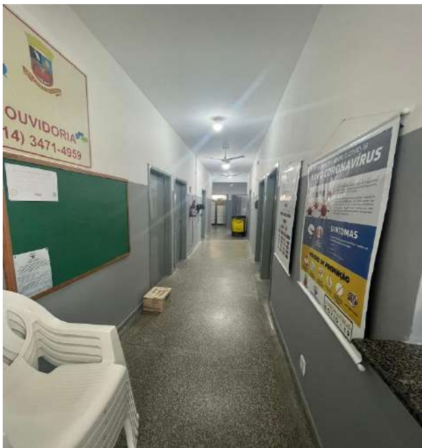
Finalização da obra.
