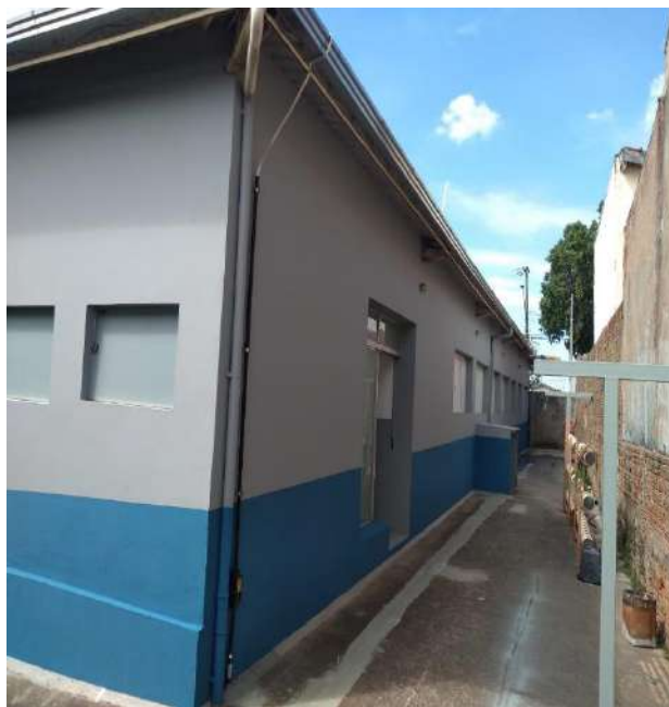
Finalização da pintura externa.
