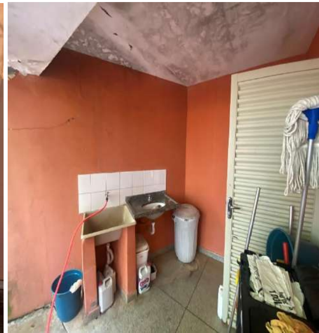
Vistoria inicial da unidade.
