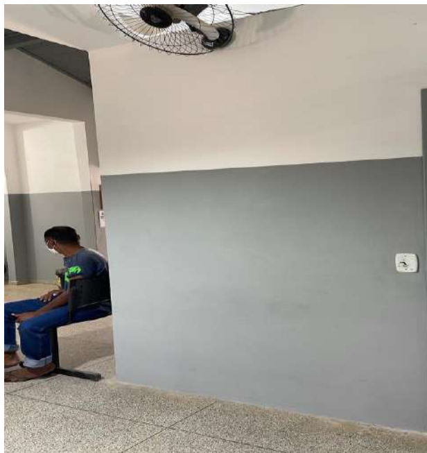
Finalização da obra.
