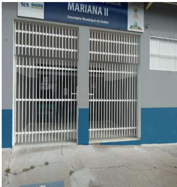
Finalização da pintura externa.
