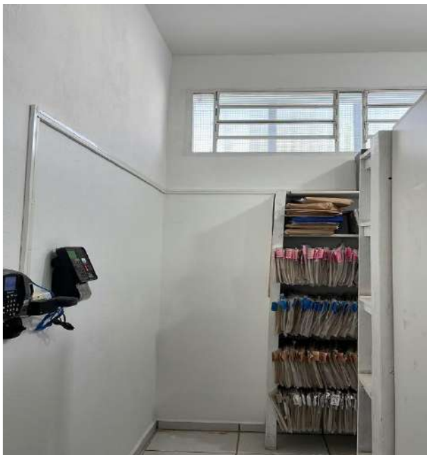
Finalização da pintura da área interna.
