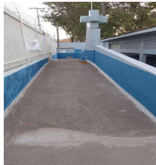
Finalização da pintura da área externa.
