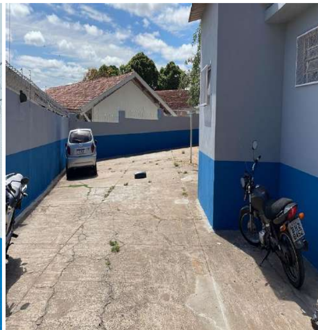
Finalização da pintura da área externa.
