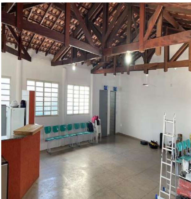
Finalização da obra.
