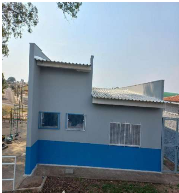
Finalização da obra.
