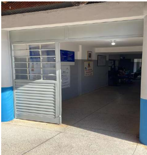
Finalização da obra.
