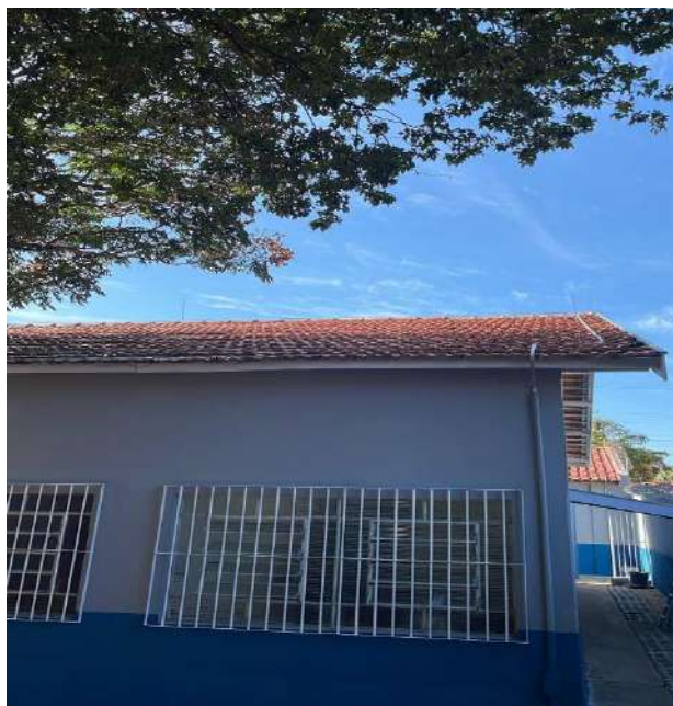
Finalização da obra.
