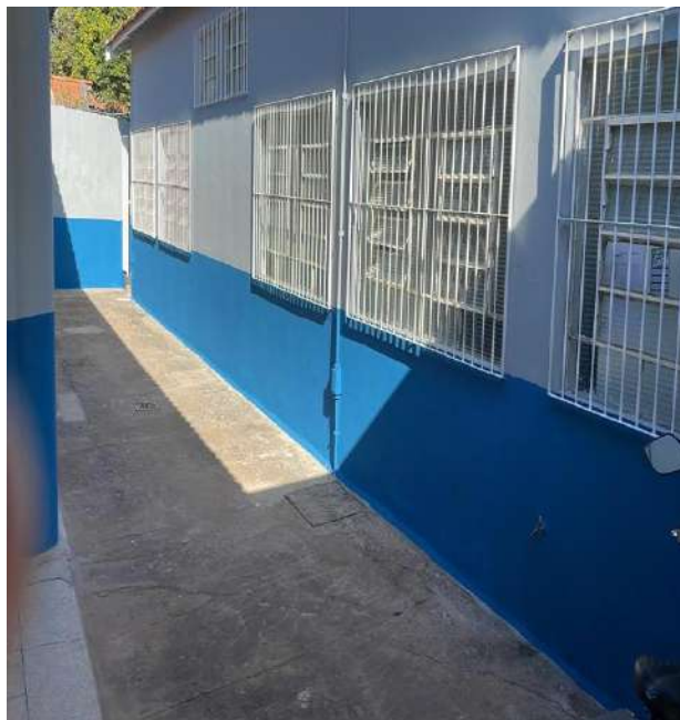
Finalização da obra.
