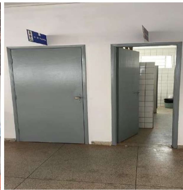
Finalização da obra.
