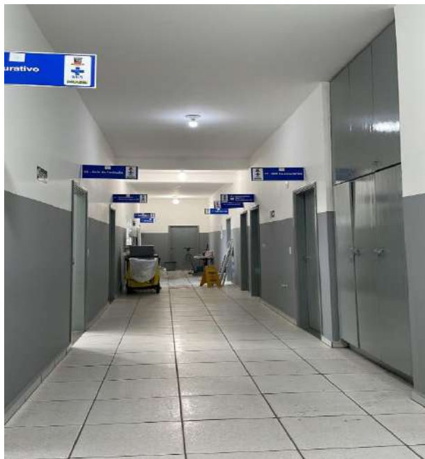
Finalização da pintura da área interna.
