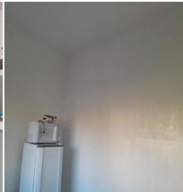
Finalização da obra.
