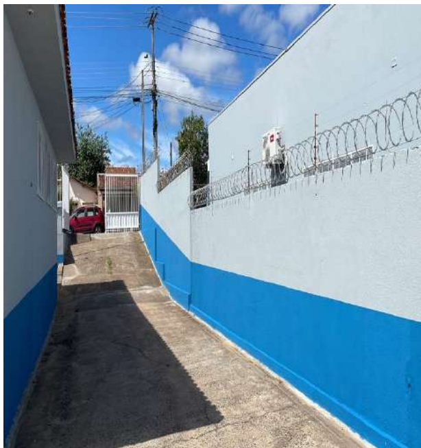
Finalização da pintura da área externa.
