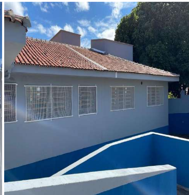
Finalização da pintura da área externa.
