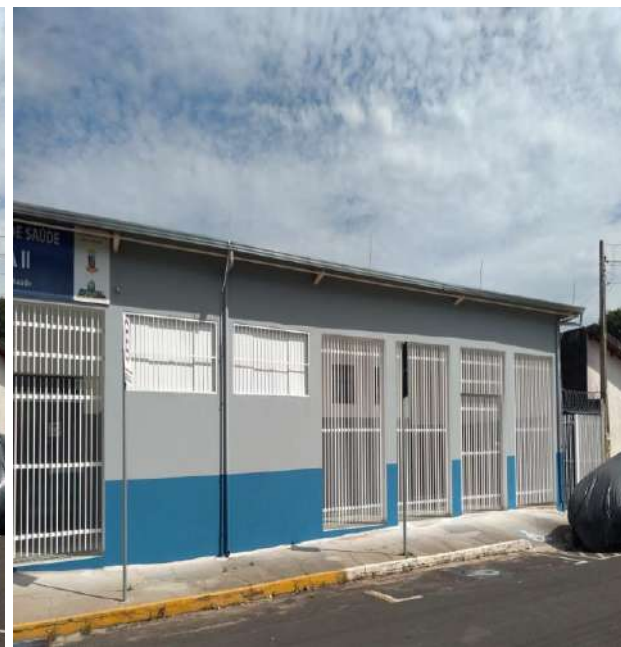
Finalização da pintura externa.
