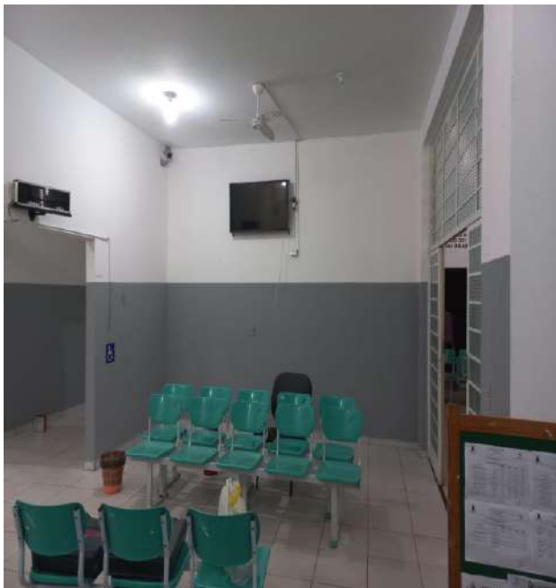
Finalização da pintura da área interna.
