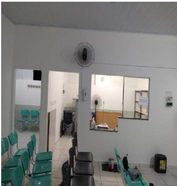
Finalização da pintura interna da unidade.
