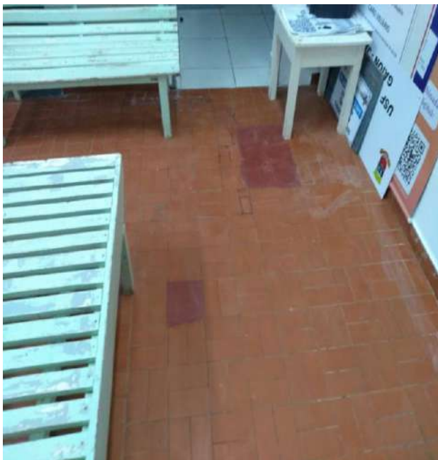
Reparo no piso interno da unidade.
