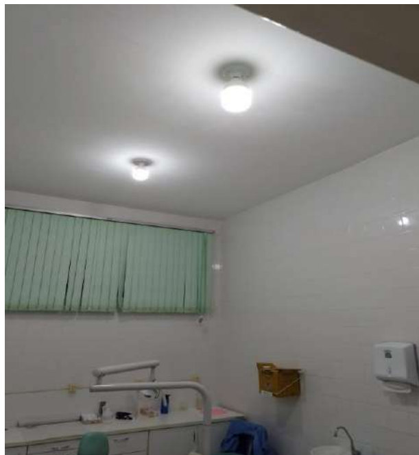
Pintura dos tetos internos das salas.
