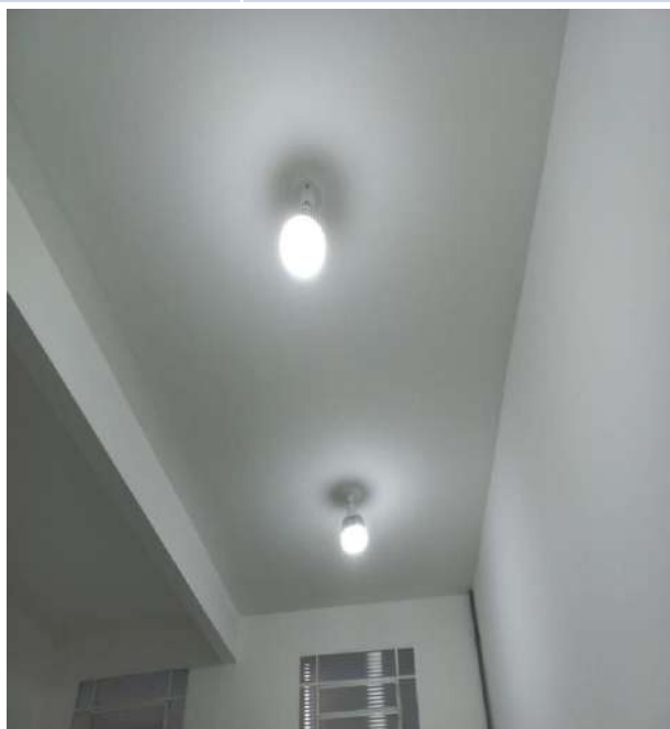
Finalização da pintura da área interna.
