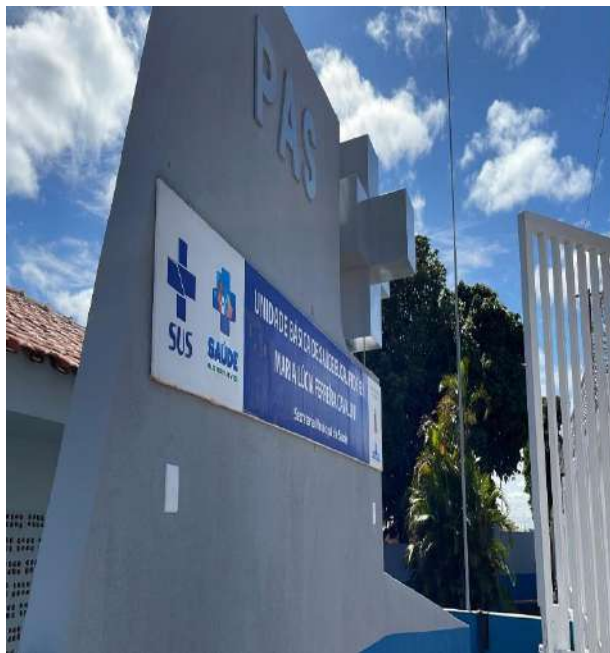
Finalização da pintura da área externa.
