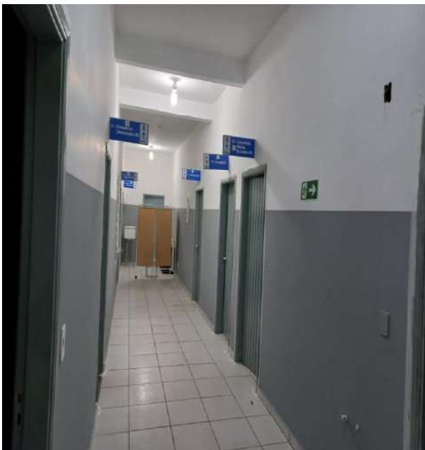
Finalização da pintura interna, unidade Eucaliptos.
