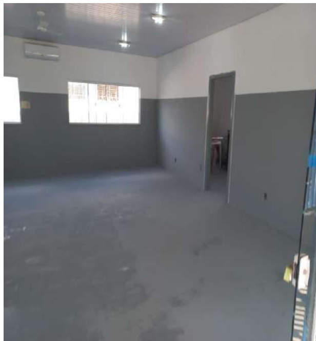
Finalização da pintura da área interna da unidade Polo.
