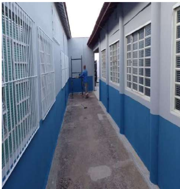
Finalização da obra.
