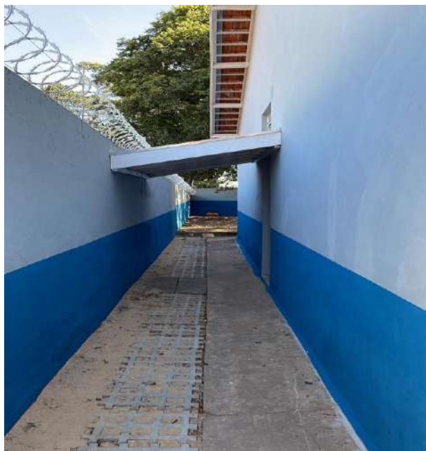
Finalização da obra.
