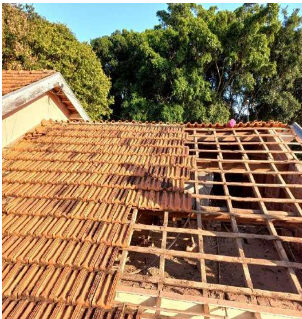
Reparo dos madeiramentos e telhas.
