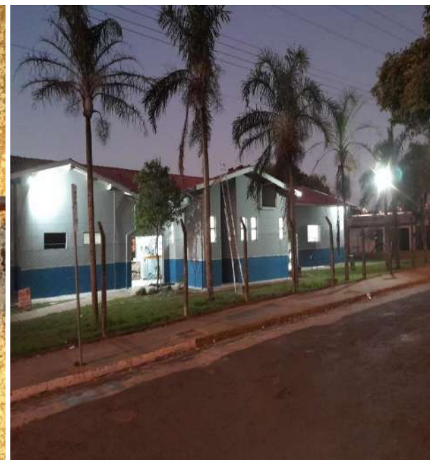
Finalização da obra.
