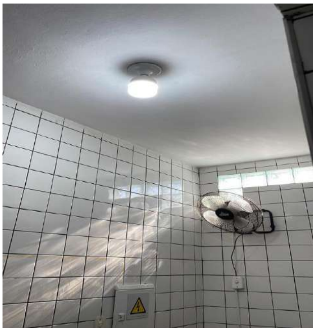
Finalização da obra.
