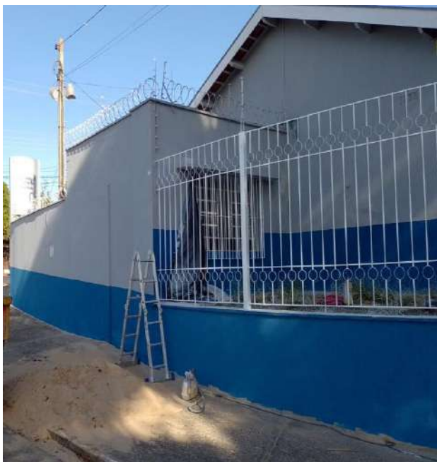
Finalização da obra.
