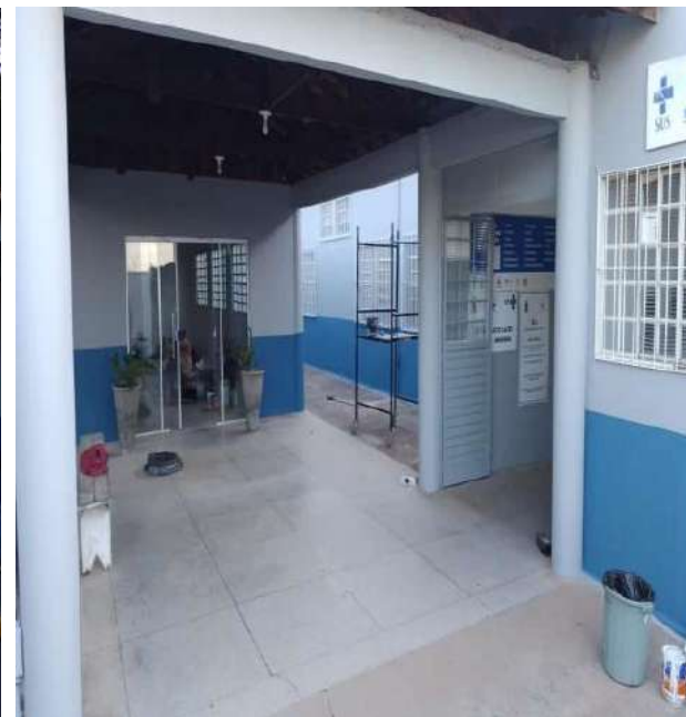
Finalização da obra.
