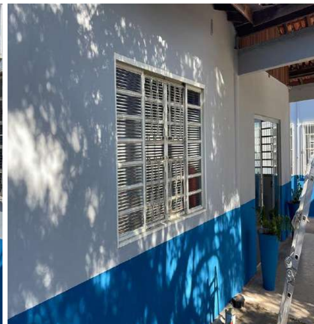
Finalização da obra.
