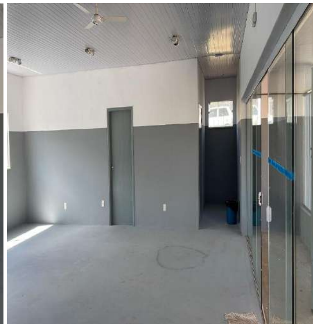
Finalização da pintura da área interna.
