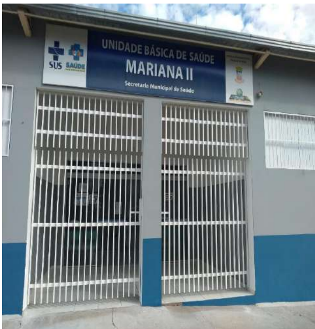
Finalização da pintura externa.
