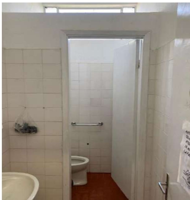
Vistoria inicial da unidade.
