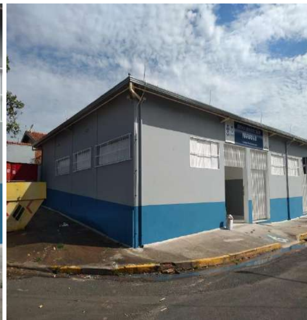
Finalização da pintura externa.
