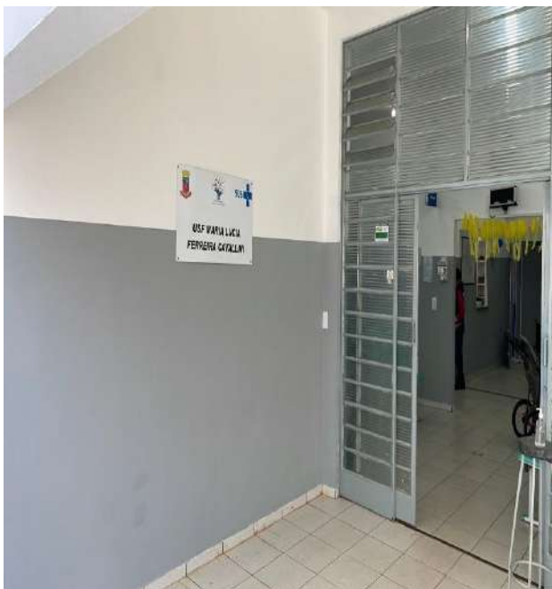
Finalização da pintura da área interna.
