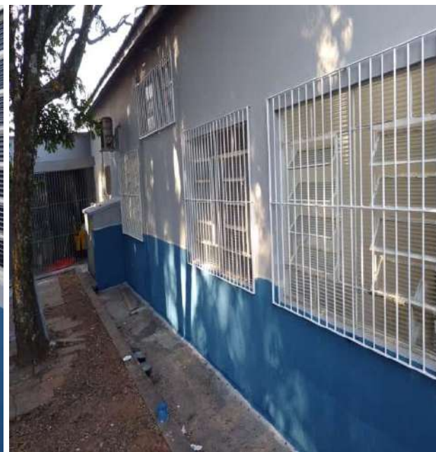
Finalização da obra.
