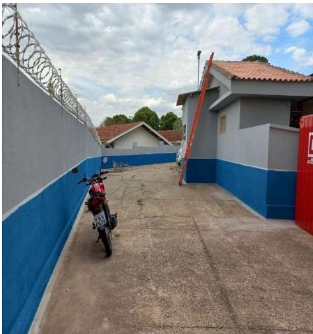
Finalização da pintura externa eucaliptos.
