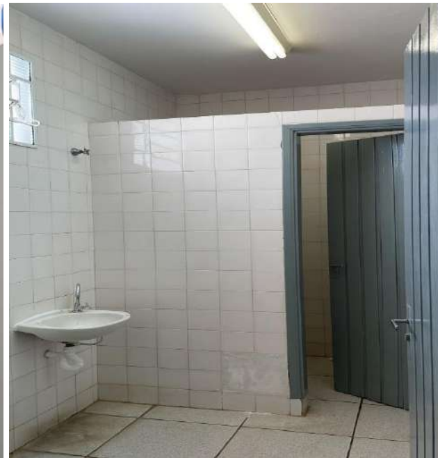
Finalização da pintura da área interna.
