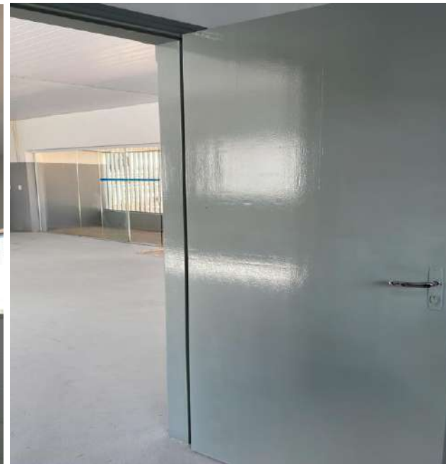
Finalização da pintura da área interna.
