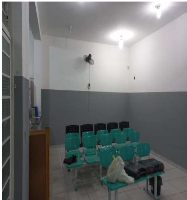
Finalização da pintura da área interna.
