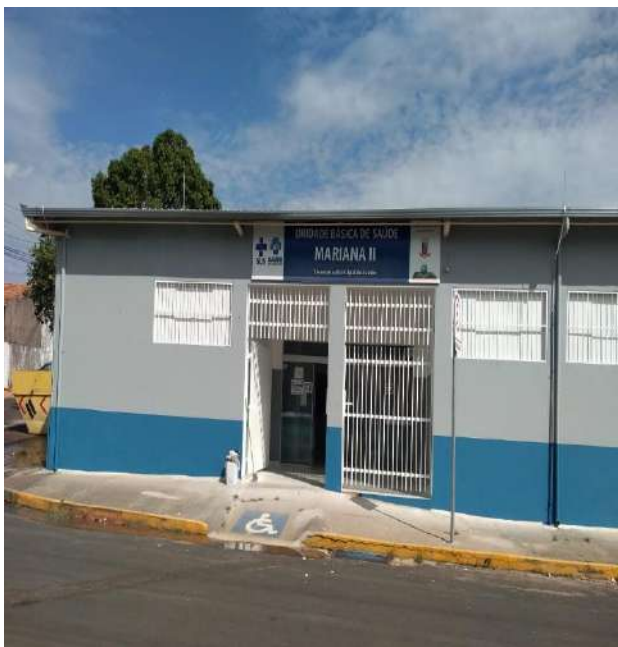
Finalização da pintura externa.
