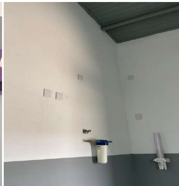
Finalização da obra.
