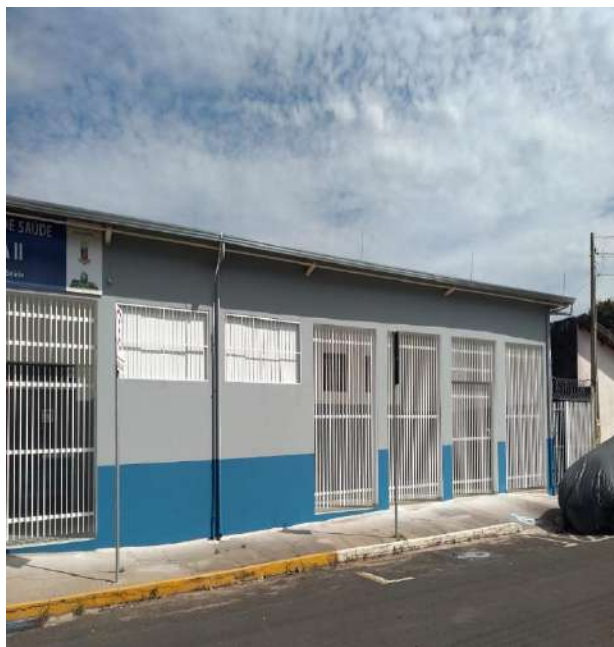
Finalização da pintura externa.
