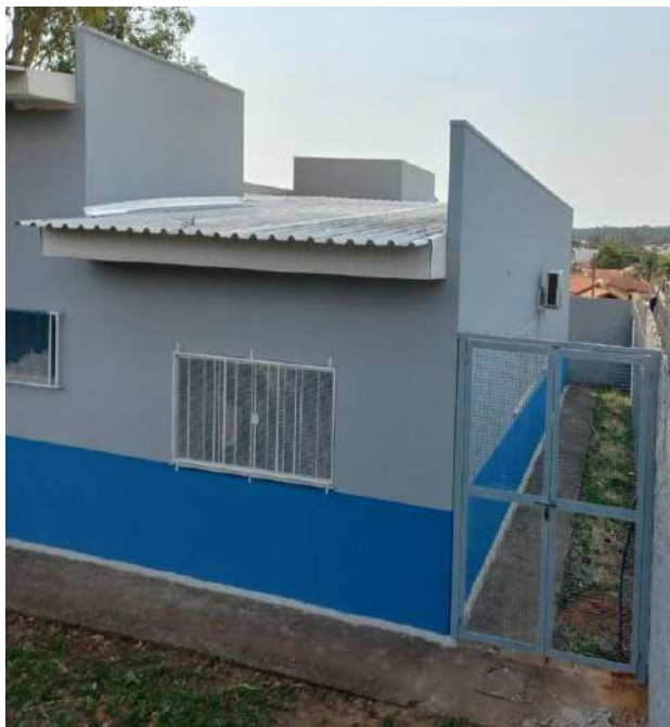
Finalização da obra.
