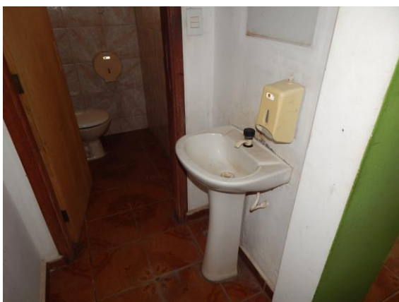
Imagem 10 – parcial sanitário (administração)
