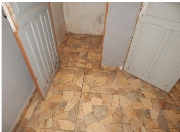
Imagem 13 – parcial sanitário funcionários
