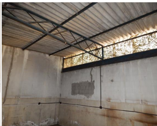
Imagem 18 – parcial galpão industrial
