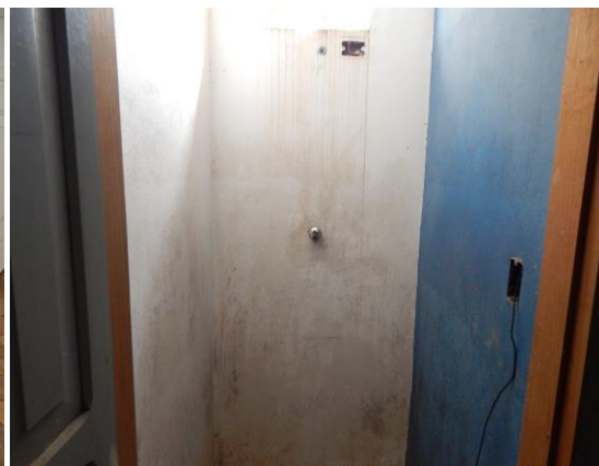
Imagem 14 – parcial sanitário funcionários
