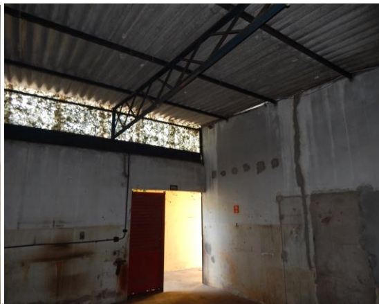
Imagem 16 – parcial galpão industrial
