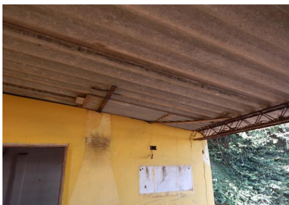
Imagem 30 – parcial cobertura edícula
