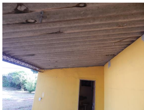
Imagem 32 – parcial cobertura edícula
