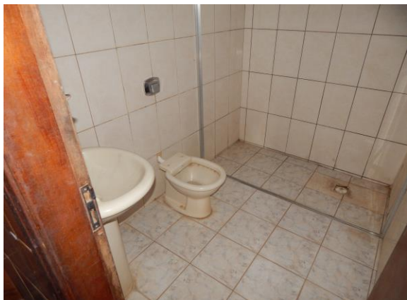
Imagem 09 – parcial sanitário apto
