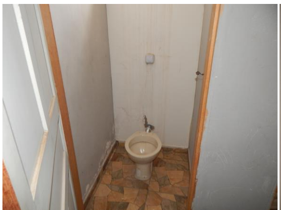
Imagem 11 – parcial sanitário funcionários
