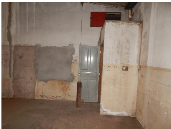
Imagem 15 – parcial galpão industrial
