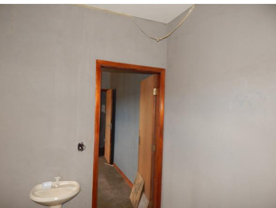
Imagem 12 – parcial sanitário funcionários
