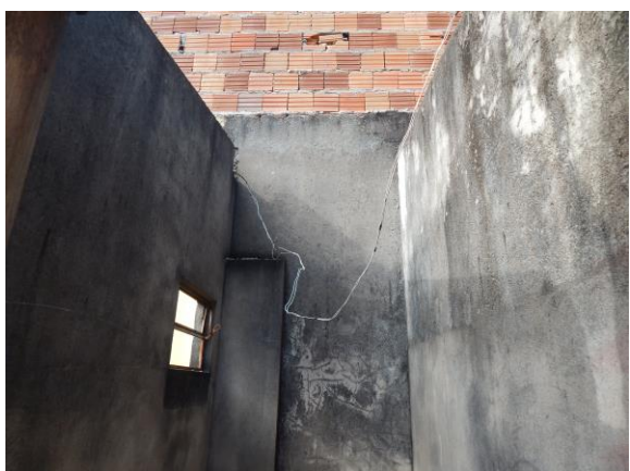
Imagem 27 – parcial área de serviço
