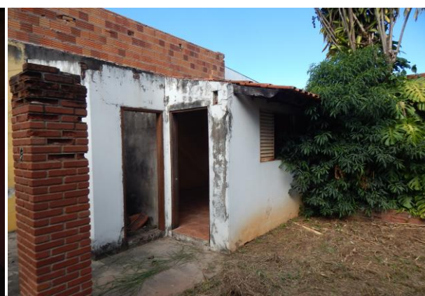
Imagem 22 – vista área de serviço
