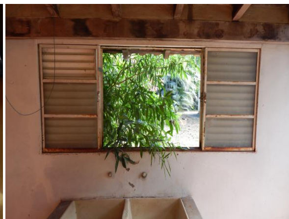
Imagem 26 – vista área de serviço
