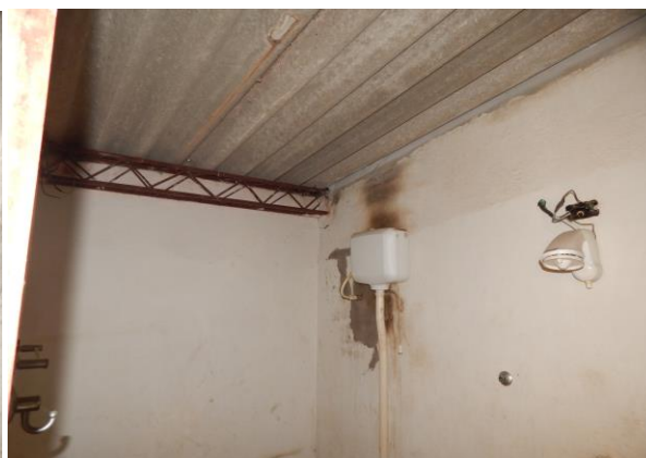
Imagem 34 – parcial sanitário edícula
