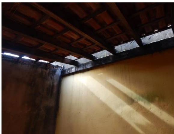
Imagem 25 – vista interna área de serviço
