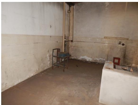
Imagem 17 – parcial galpão industrial
