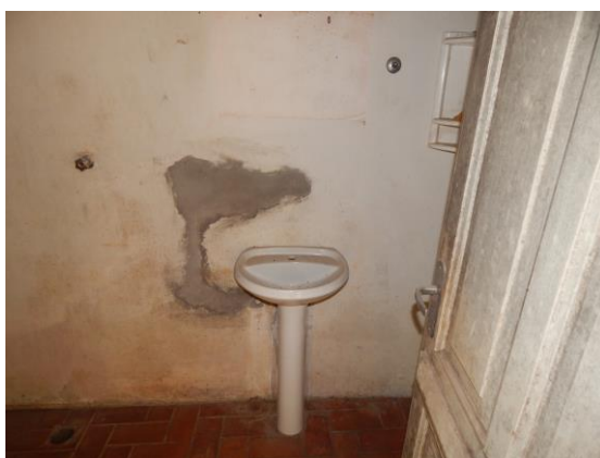
Imagem 33 – parcial sanitário edícula
