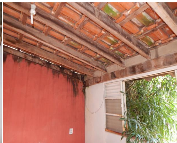
Imagem 24 – parcial área de serviço
