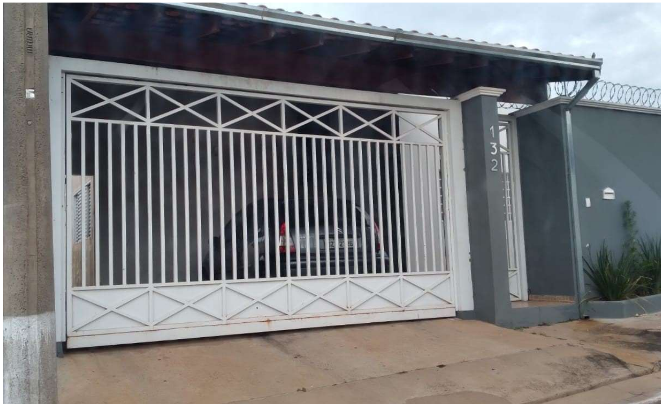
Foto 01 – Fachada da Edificação
