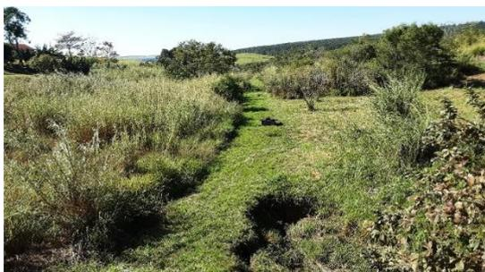
Figura 4.1.12 – Canaleta que escoia a água coletada pelos drenos para o tanque de concreto da ECR B2
