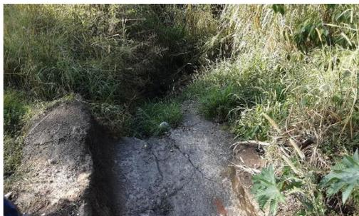
Figura 4.4.176 – Dispositivo de drenagem no Córrego Parque Real, que recebe três tubulações de drenagem superficial e uma tubulação que coleta água de minas que foram canalizadas
