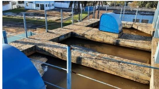
Figura 4.1.31 – Decantadores da ETA Garça
