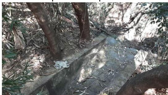
Figura 4.4.136 – Talude alto devido à erosão na nascente do corpo hídrico, à jusante do lançamento da drenagem superficial na R Antonio Ribeiro da Silva
