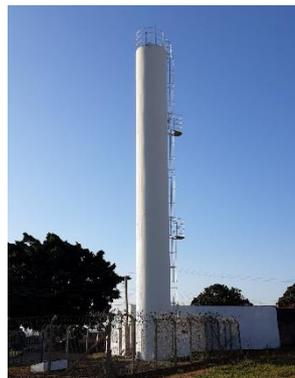
Figura 4.1.51 – Reservatório metálico Europa, de 120 m<sup>3</sup>
