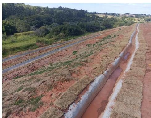
Figura 4.5.40 – Escada hidráulica para amortizar a velocidade da chuva
