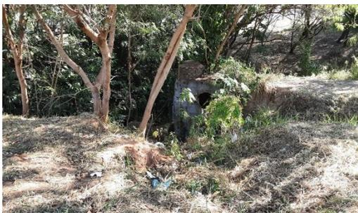
Figura 4.4.139 – Dispositivo de drenagem na R Capitão Isaias Rodrigues Martins, onde os tubos foram deslocados e está ocorrendo processo erosivo
