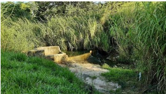
Figura 4.1.18 – Tubulação de recalque em risco devido à erosão do Ribeirão Tibiriçá
