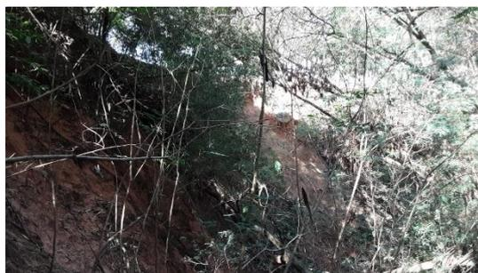
Figura 4.4.137 – Erosão ao lado do dispositivo de drenagem na R Antonio Ribeiro da Silva, comprometendo a estabilidade da canaleta
