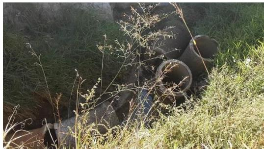
Figura 4.4.146 – Erosão próximo ao Córrego Nova Garça, na R Aparecido Martins. No local, a água coletada é lançada sem dissipador, fora do curso hídrico
