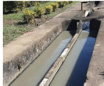
Figura 4.2.20 – Calha parshall da ETE Tibiriçá
