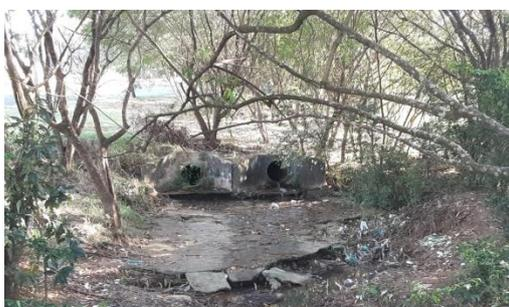
Figura 4.4.141 – Dissipador de drenagem na R Luiz Valsecchi. O corpo hídrico é canalizado da R Rosário Martino até este ponto, em que passa a escoar superficialmente
