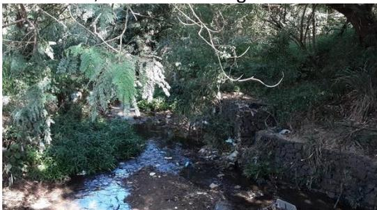
Figura 4.4.127 – Água acumulada adjacente ao dissipador de drenagem em gabião na R Sete de Setembro
