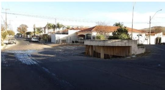
Figura 4.4.95 – Dispositivo de drenagem na R Padre Toledo Leite, esquina com a R José Augusto Escobar, onde ocorrem alagamentos durante precipitações intensas
