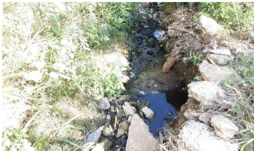
Figura 4.4.133 – Canaleta de drenagem degradada na esquina da R Tupy com a R São Paulo
