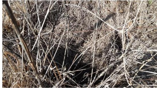
Figura 4.4.216 – PV de drenagem sem tampão e oculto pela vegetação, próximo à R Menoti Baraldi
