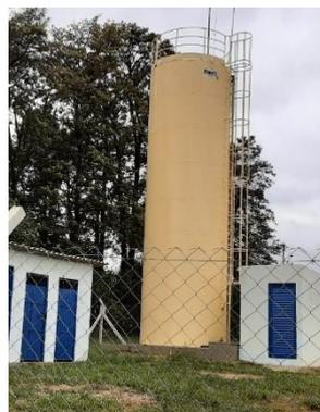
Figura 4.1.49 – Reservatório metálico Ecoville, de 200 m<sup>3</sup>
