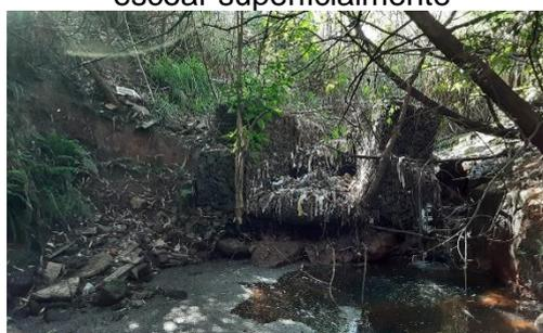
Figura 4.4.142 – Vista do dissipador na R Luiz Valsecchi, onde está ocorrendo processo erosivo à jusante do lançamento e o gabião está rompido
