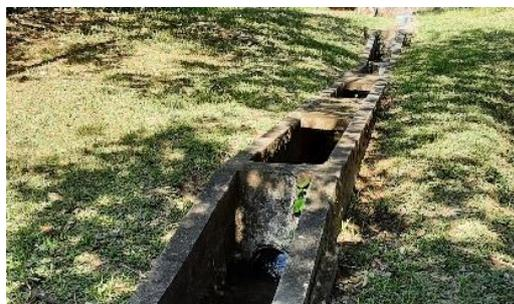
Figura 4.1.13 – Represa Cascata que escoia por gravidade para o tanque de concreto da ECR B2
