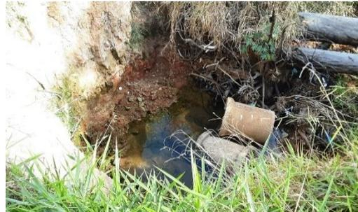
Figura 4.4.166 – Dispositivo de drenagem loteamento Jd. Monte Verde, com falhas na estrutura
