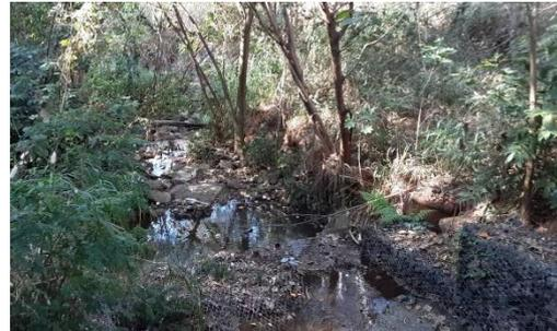
Figura 4.4.186 – Dissipador do Jd. São Benedito, entregue em 2021, com falhas em sua estrutura
