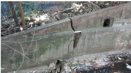
Figura 4.4.125 – Árvore em erosão adjacente ao dispositivo de drenagem da R Gabriela, comprometendo a estabilidade do talude
