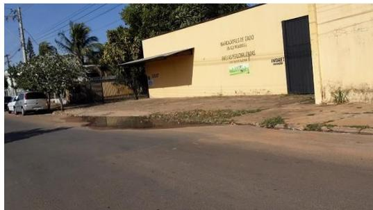
Figura 4.4.101 – Av Labieno da Costa Machado, entre a R Alvino de Oliveira e a R Valter Alves de Souza, onde a água não escoa devido à obstrução da sarjeta
