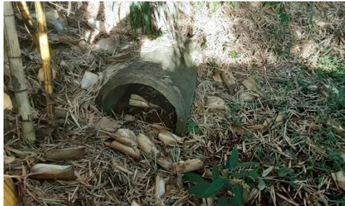
Figura 4.4.178 – Tubo remanescente da drenagem do Jd. Zapata, que foi deslocado por meio de processos erosivos
