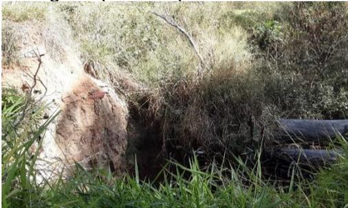
Figura 4.4.165 – Dispositivo de drenagem do loteamento São Lucas, próximo à R Vereador Joaquim Rodrigues Fonseca Brandão. Tubos deslocados devido a processo erosivo
