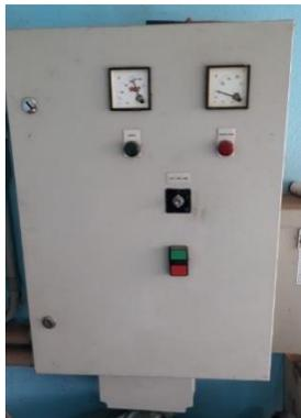
Figura 4.2.37 – Painéis elétricos dos aeradores da ETE Jafa
