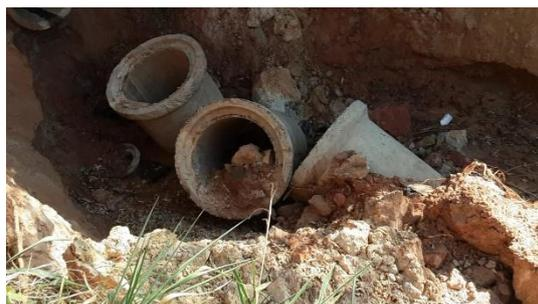
Figura 4.4.150 – Tubos de concreto da rede de drenagem do bairro Jd. Morumbi, deslocados por erosão
