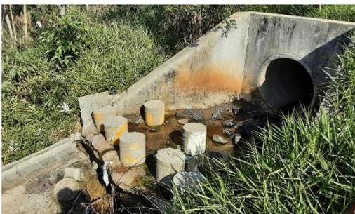
Figura 4.4.187 – Dissipador do Jd. São Benedito, entregue em 2021, com falhas em sua estrutura processo erosivo à jusante do lançamento
