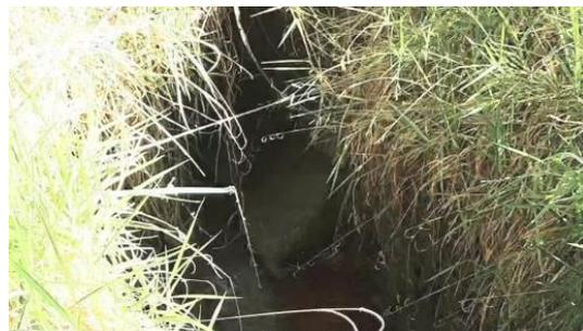
Figura 4.4.173 – Dissipador de drenagem em gabião na tubulação de drenagem superficial do Jd. Morada do Sol, adjacente à EP de esgoto Morada do Sol
