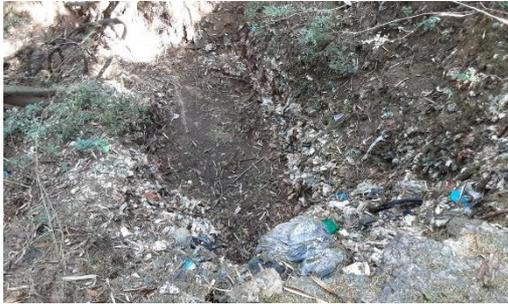
Figura 4.4.215 – PV de drenagem sem tampão e oculto pela vegetação, próximo à R Menoti Baraldi
