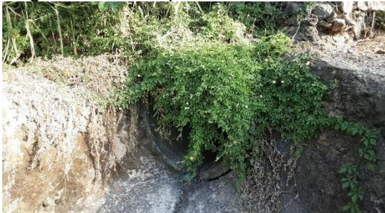
Figura 4.4.177 – Tubo da drenagem do Jd. Zapata, deslocado por processos erosivos
