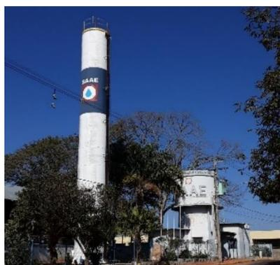
Figura 4.1.53 – Reservatório metálico Vista Verde 1 em Jafa, de 50 m<sup>3</sup>
