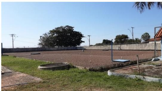
Figura 4.1.40 – Reservatório de concreto enterrado ETA 02, de 2.400 m<sup>3</sup>
