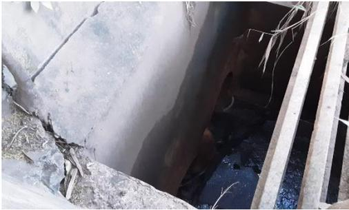
Figura 4.4.157 – Rachadura na estrutura da caixa de drenagem na margem direita da nascente do Ribeirão Tibiriçá
