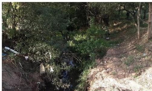
Figura 4.4.130 – Erosão em curso ao lado do dispositivo de drenagem ao fim da R Francisco da Silva Braga, comprometendo a estabilidade da alvenaria
