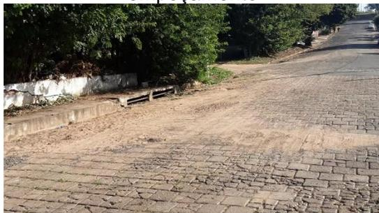
Figura 4.4.119 – Dispositivo na R Sete de Setembro para coleta de água pluvial
