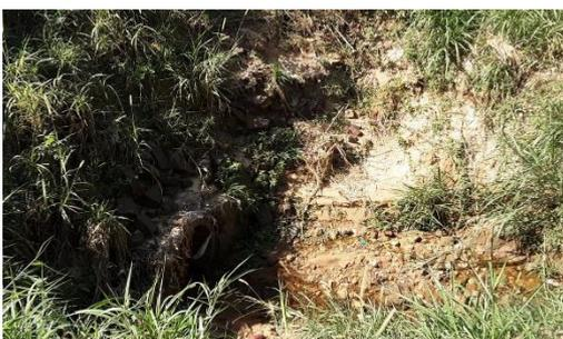
Figura 4.4.169 – Erosão causada pela passagem de água em travessia próximo ao núcleo de apoio ao migrante
