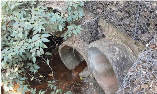
Figura 4.4.185 – Vista do dissipador de drenagem do lago, onde está ocorrendo processo erosivo à jusante do lançamento
