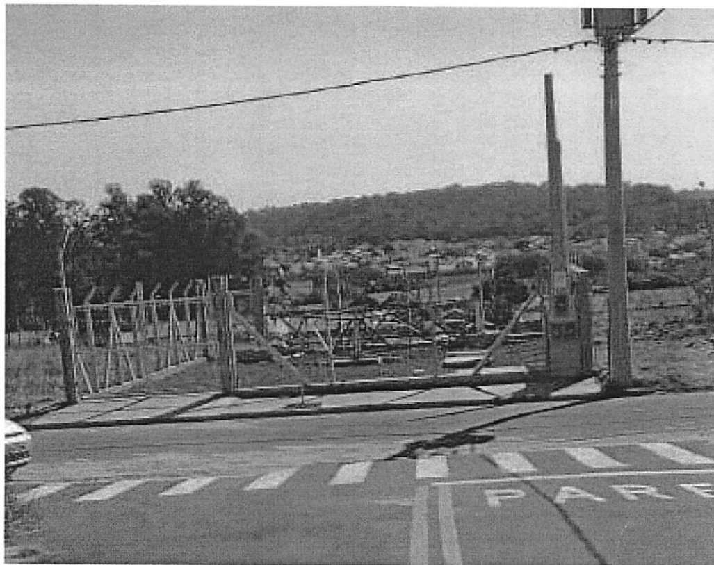
Foto 2-1 Vista da área direta de onde será instalado o empreendimento do site GDWSP.
