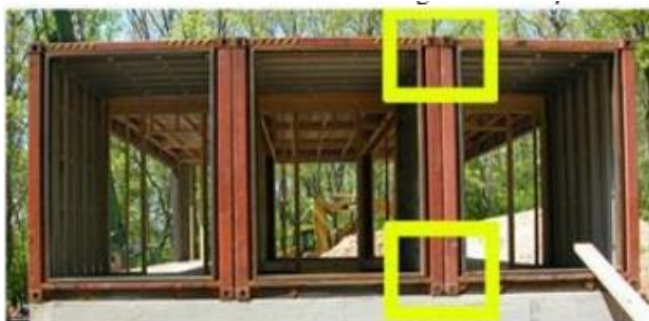
Figura 16 – União dos containers
