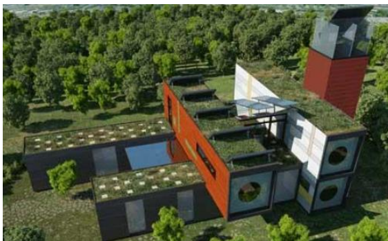
Figura 25 – Telhado verde em casa de container .
