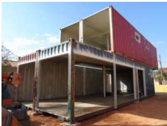
Figura 9 - Recortes dos containers
