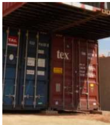
Figura 8 - Containers em cima da fundação
