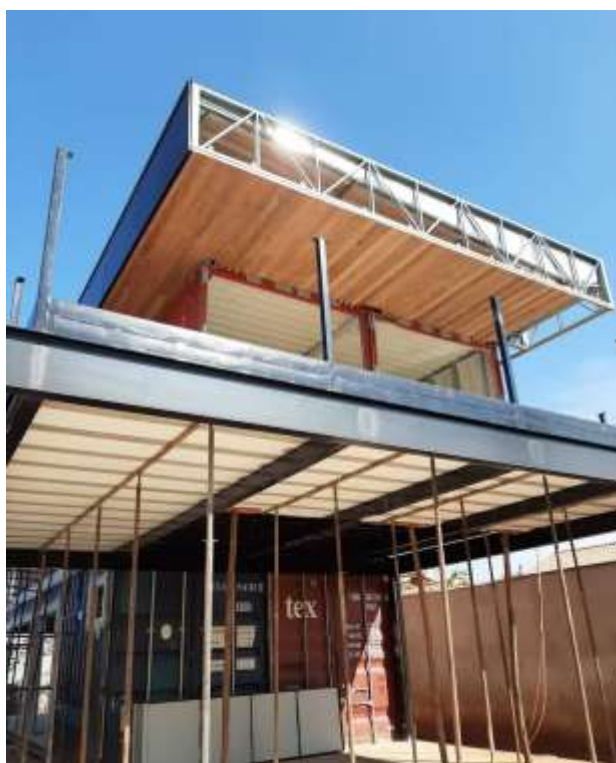
Figura 12 - Cobertura e lajes pré moldadas.
