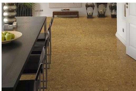
Figura 21 – Revestimento de piso em cortiça para isolamento.
