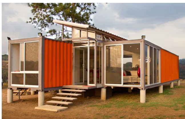
Figura 14 – Container apoiado em suas extremidades.
