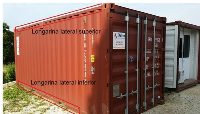
Figura 18 – Longarinas em container
