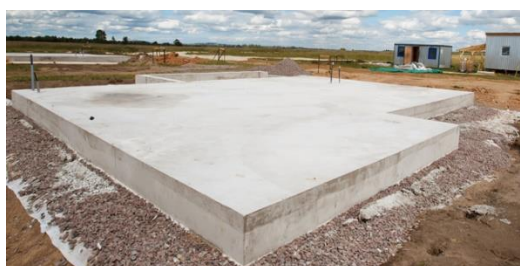
Figura 11 – Radier de concreto
