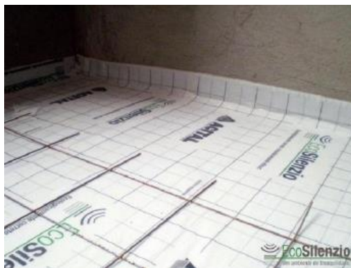
Figura 22 – Execução de Manta de fibra de poliéster.
