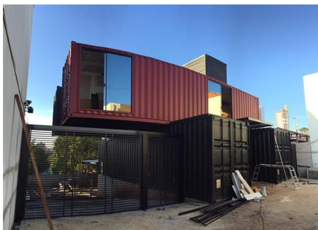
Figura 15 – Container em balanço
