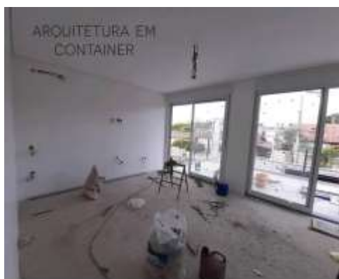
Figura 11 - Acabamentos realizado para execução de pintura das paredes.
