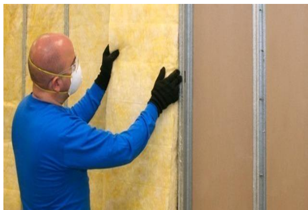
Figura 24 – Aplicação de lã de vidro em divisórias de drywall.
