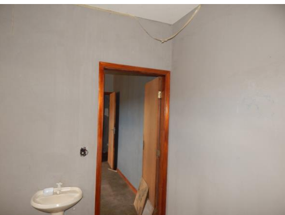
Imagem 12 – parcial sanitário funcionários
