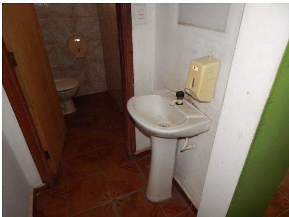
Imagem 10 – parcial sanitário (administração)
