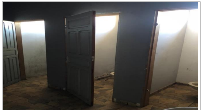
Sanitários: Troca de todo o revestimento, esquadrias, pintura e instalação elétrica.
