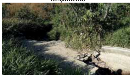
Figura 4.4.189 – Erosão na drenagem do bairro Residencial do Bosque
