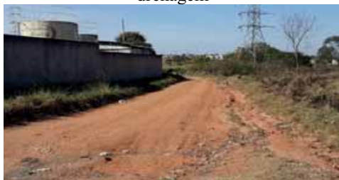
Figura 4.4.67 – Av Vererador Anézio Telles, da R Valter Alves de Souza até a R Maria Conceição Santos Silva que recebe águas pluviais de várias ruas e não possui rede de drenagem
