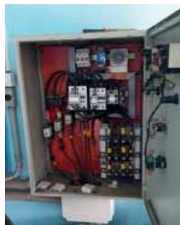
Figura 4.2.37 – Painéis elétricos dos aeradores da ETE Jafa
