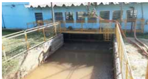
Figura 4.1.5 – Poço de sucção da ECR B1, em que se pode ver à esquerda a tubulação de entrada da água captada no Poço Guarani
