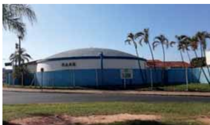
Figura 4.1.45 – Reservatório enterrado de concreto Adrianita, de 80 m 3
