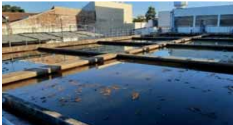
Figura 4.1.31 – Decantadores da ETA Garça
