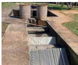
Figura 4.2.5 – Calha parshall da ETE Peixe
