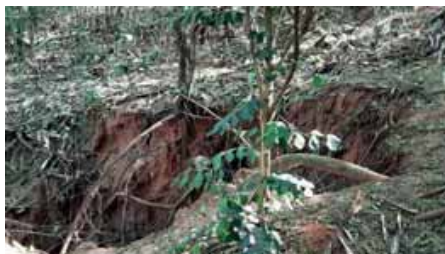
Figura 4.4.139 – Dispositivo de drenagem na R Capitão Isaias Rodrigues Martins, onde os tubos foram deslocados e está ocorrendo processo erosivo
