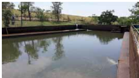
Figura 4.1.12 – Canaleta que escoar a água coletada pelos drenos para o tanque de concreto da ECR B2
