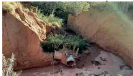
Figura 4.4.189 – Erosão na drenagem do bairro Residencial do Bosque
