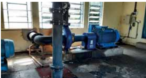
Figura 4.1.15 – Bombas instaladas na ECR B2
