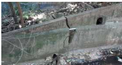
Figura 4.4.126 – Dissipador de drenagem em gabião na R Sete de Setembro, recebendo a água à montante
