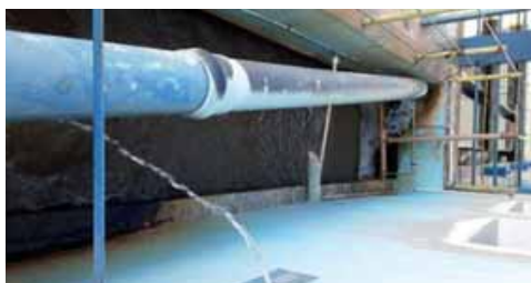
Figura 4.1.29 – Etapa de mistura rápida e coagulação realizada na ETA Garça
