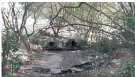
Figura 4.4.142 – Vista do dissipador na R Luiz Valsecchi, onde está ocorrendo processo erosivo à jusante do lançamento e o gabião está rompido
