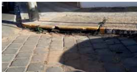
Figura 4.4.72 – Trecho sem boca de lobo esquina R Voluntários e R Heitor Penteado
