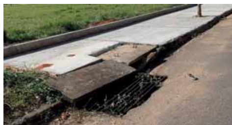
Figura 4.4.217 – Boca de lobo com tampa de concreto solta na R Carlos Ferrari, esquina com a R França
