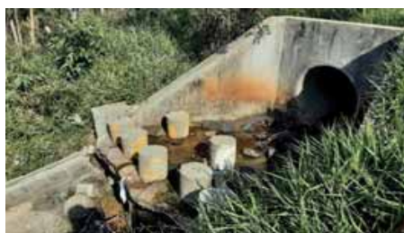
Figura 4.4.188 – Erosão na drenagem do bairro Residencial do Bosque
