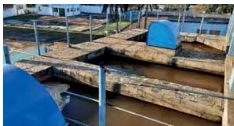
Figura 4.1.30 – Floculadores mecânicos da ETA Garça
