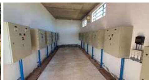
Figura 4.2.15 – Painéis elétricos dos aeradores da ETE Peixe
