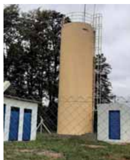
Figura 4.1.50 – Reservatório metálico Campo Belo, de 70 m 3
