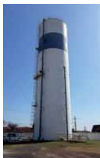
Figura 4.1.43 – Reservatório de concreto Rebello, de 1.000 m³
