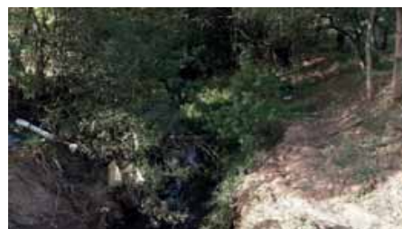
Figura 4.4.131 – Dispositivo de drenagem ao fim da R Francisco da Silva Braga, onde há uma erosão em curso devido à alteração de direção do córrego
