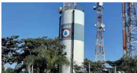
Figura 4.1.46 – Reservatório metálico Vila Araceli (CREA), de 1.000 m 3
