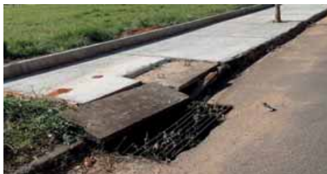
Figura 4.4.101 – Av Labieno da Costa Machado, entre a R Alvinho de Oliveira e a R Valter Alves de Souza, onde a água não escoou devido à obstrução da sarjeta
