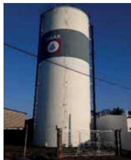
Figura 4.1.48 – Reservatório metálico Le Sorelle, de 60 m 3
