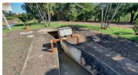
Figura 4.2.7 – Medidor ultrassônico que registra a vazão afluyente à ETE Peixe
