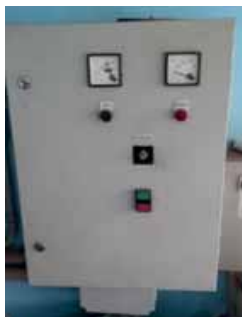
Figura 4.2.36 – Painéis elétricos dos aeradores da ETE Jafa
