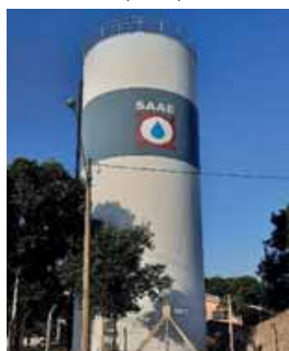
Figura 4.1.49 – Reservatório metálico Ecoville, de 200 m 3
