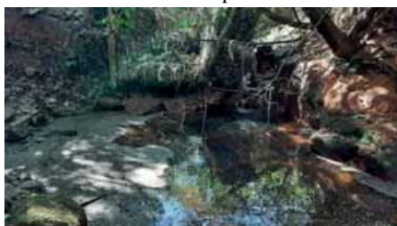
Figura 4.4.142 – Vista do dissipador na R Luiz Valsecchi, onde está ocorrendo processo erosivo à jusante do lançamento e o gabião está rompido
