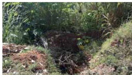
Figura 4.4.169 – Erosão causada pela passagem de água em travessia próximo ao núcleo de apoio ao migrante
