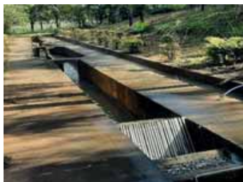
Figura 4.2.20 – Calha parshall da ETE Tibiriçá
