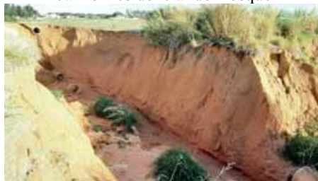
Figura 4.4.188 – Erosão na drenagem do bairro Residencial do Bosque
