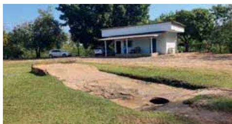
Figura 4.2.14 – Plataforma para descarregamento de esgoto, localizada antes do pré-tratamento da ETE Peixe
