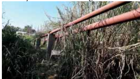
Figura 4.4.37 – Travessia de tubulação de esgoto sobre o Córrego da Cascata, aos fundos da estação elevatória de esgoto Paineiras 2
