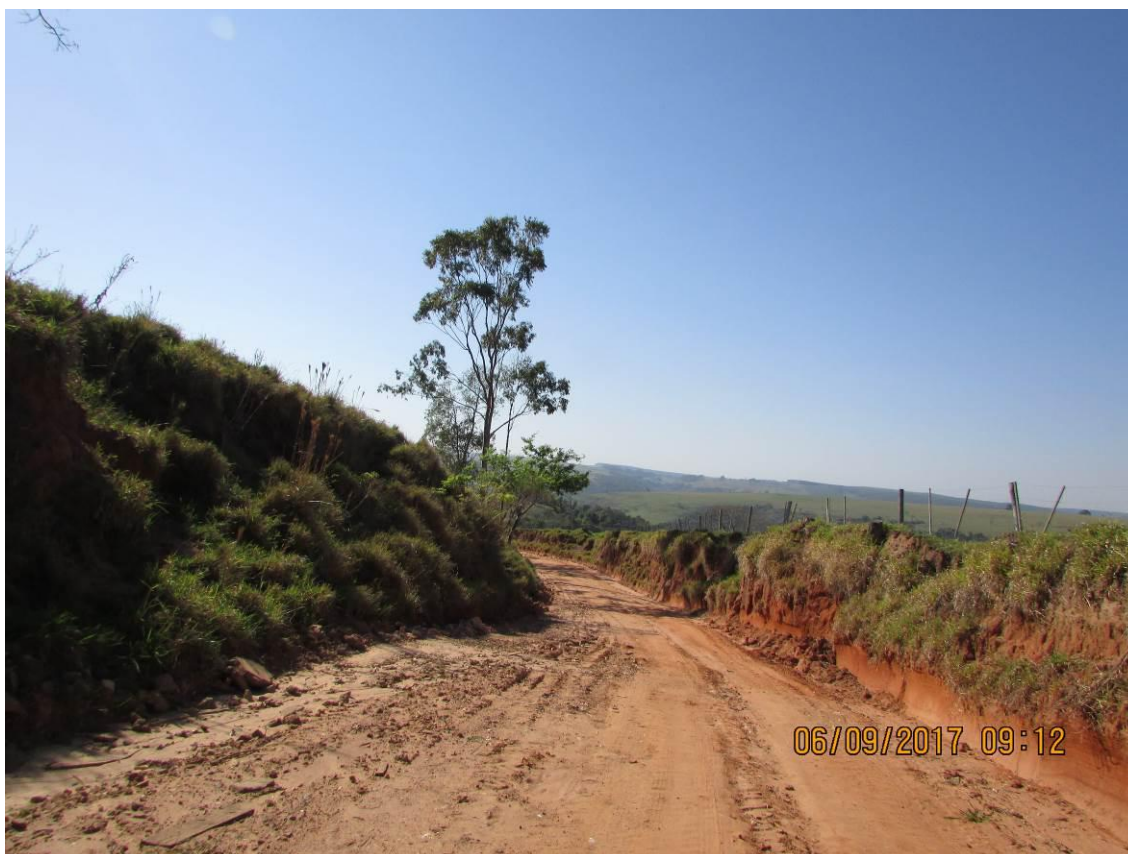
Figura 92 - Solapamento de barranco e processo erosivo no leito carroçável.
