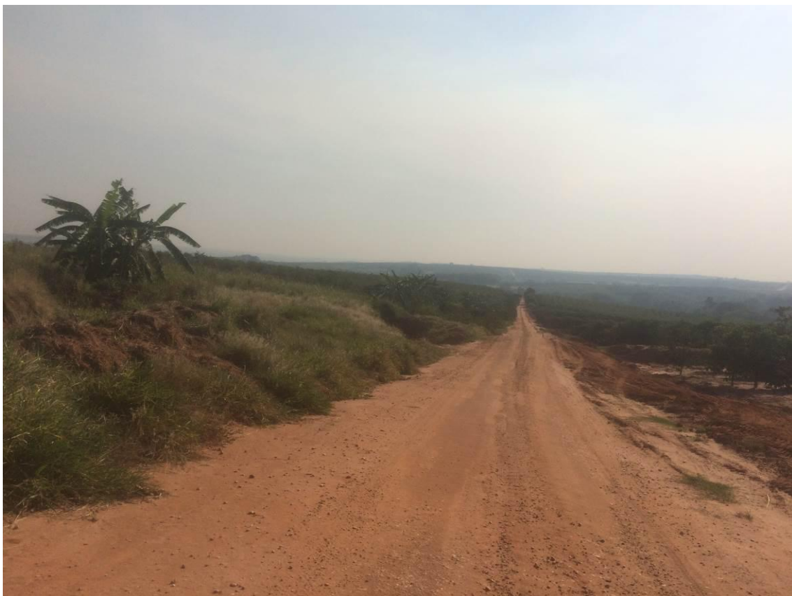
Figura 85 - Trecho com ausência de saída d'água.
