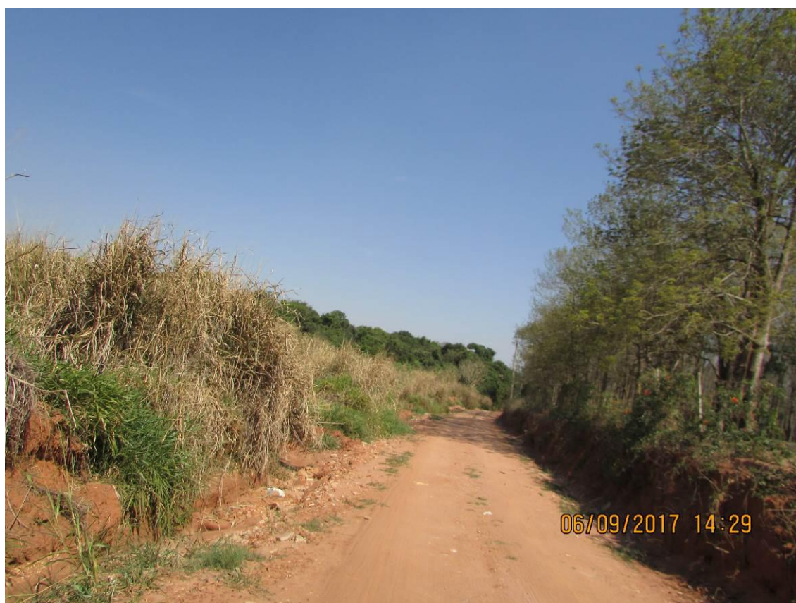
Figura 133 - Barranco e ausência de saída d'água.
