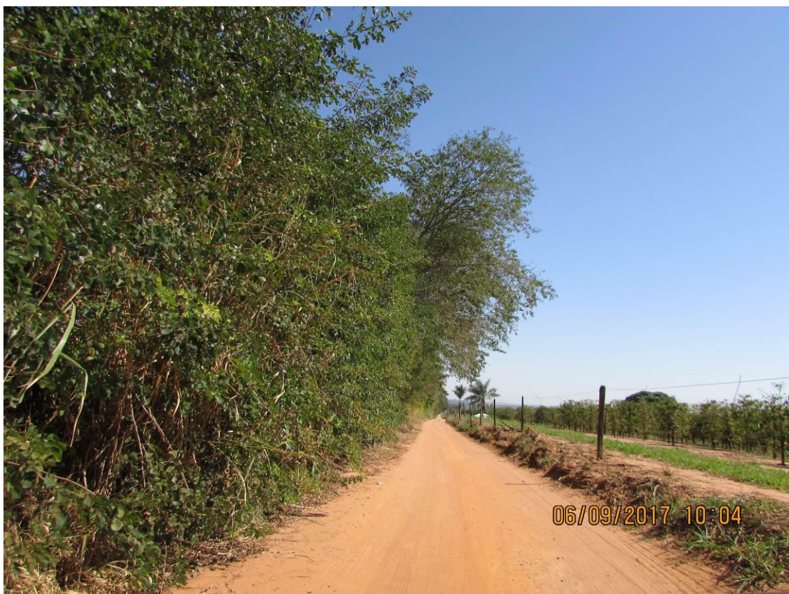
Figura 103 - Ausência de saída d'água.
