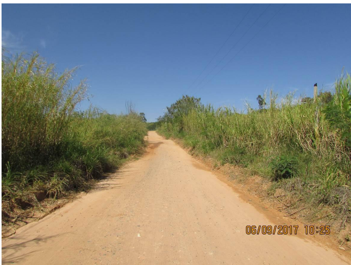
Figura 107 - Ausência de saída d'água.
