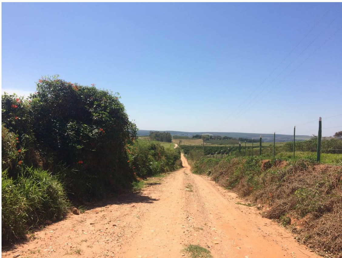
Figura 55 - Ausência de saída d'água.
