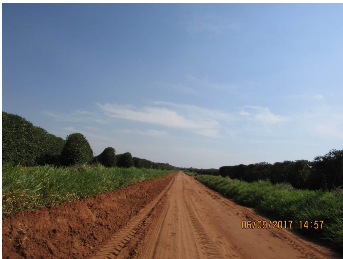
Figura 139 - Ausência de saída d'água.
