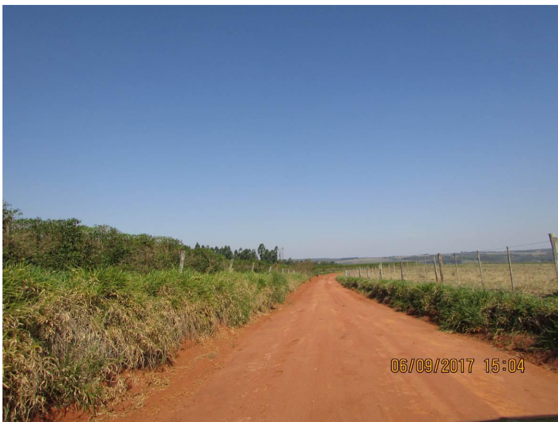
Figura 141 - Ausência de saída d'água.
