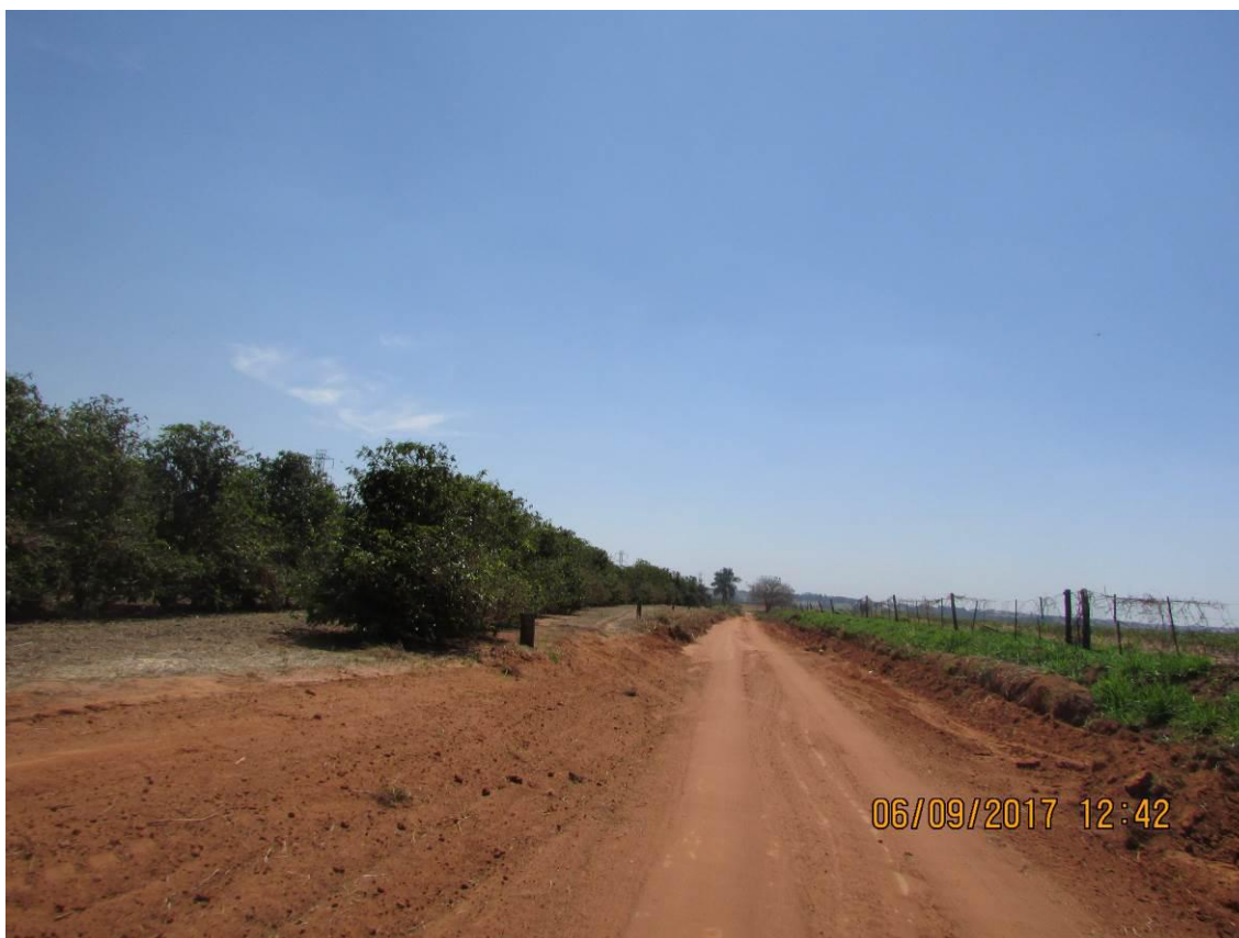
Figura 111 - Ausência de saída d'água.
