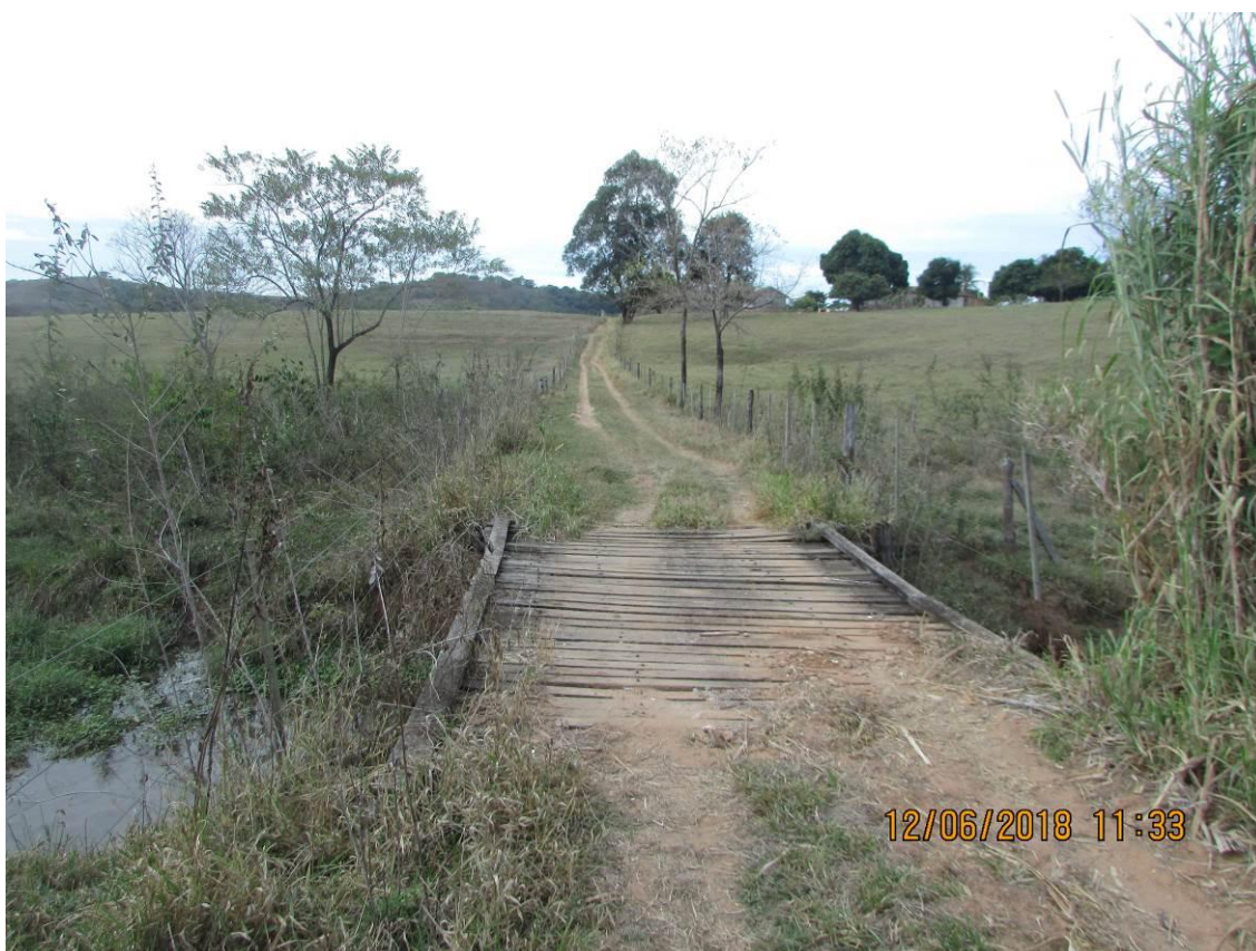
Figura 181 - Ponte de madeira com dimensões de 6 m x 4 m x 1,5 m.
