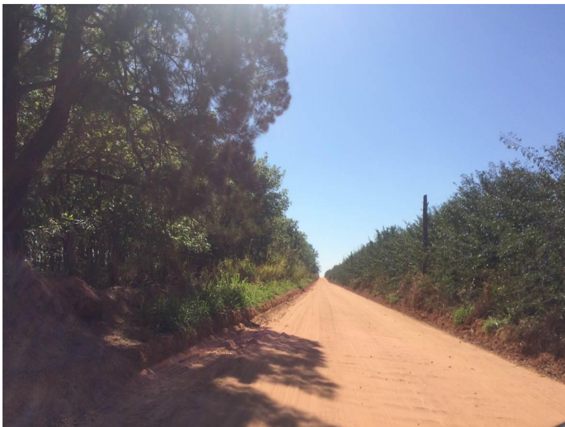
Figura 46 - Ausência de saída d'água.
