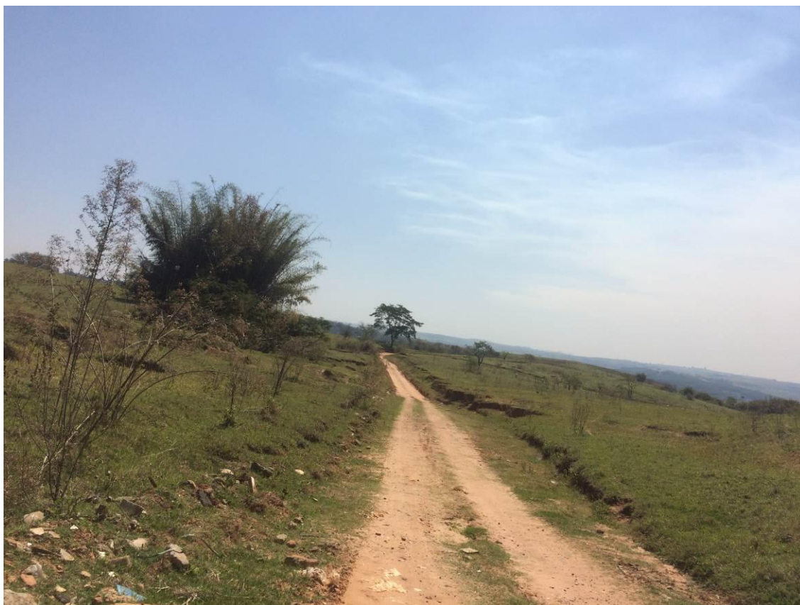
Figura 63 - Plataforma não conformada.
