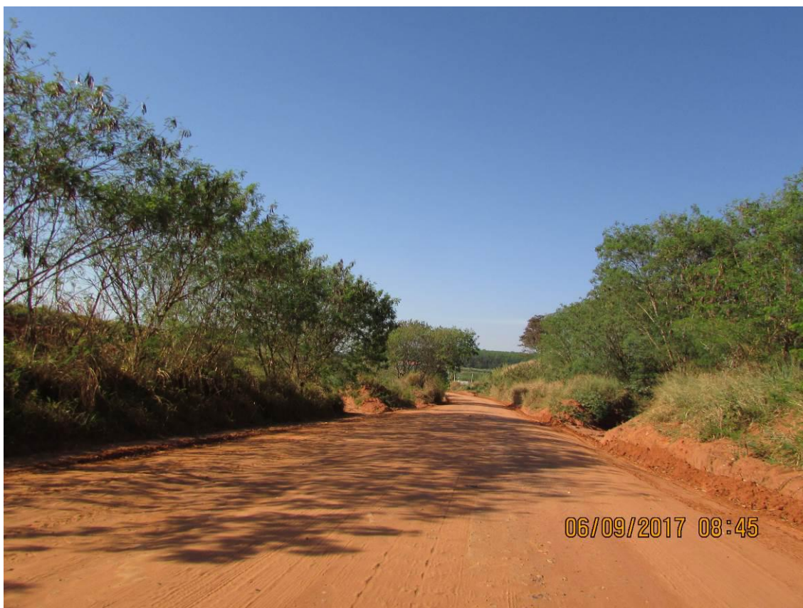
Figura 87 - Ausência de revestimento e saída d'água.
