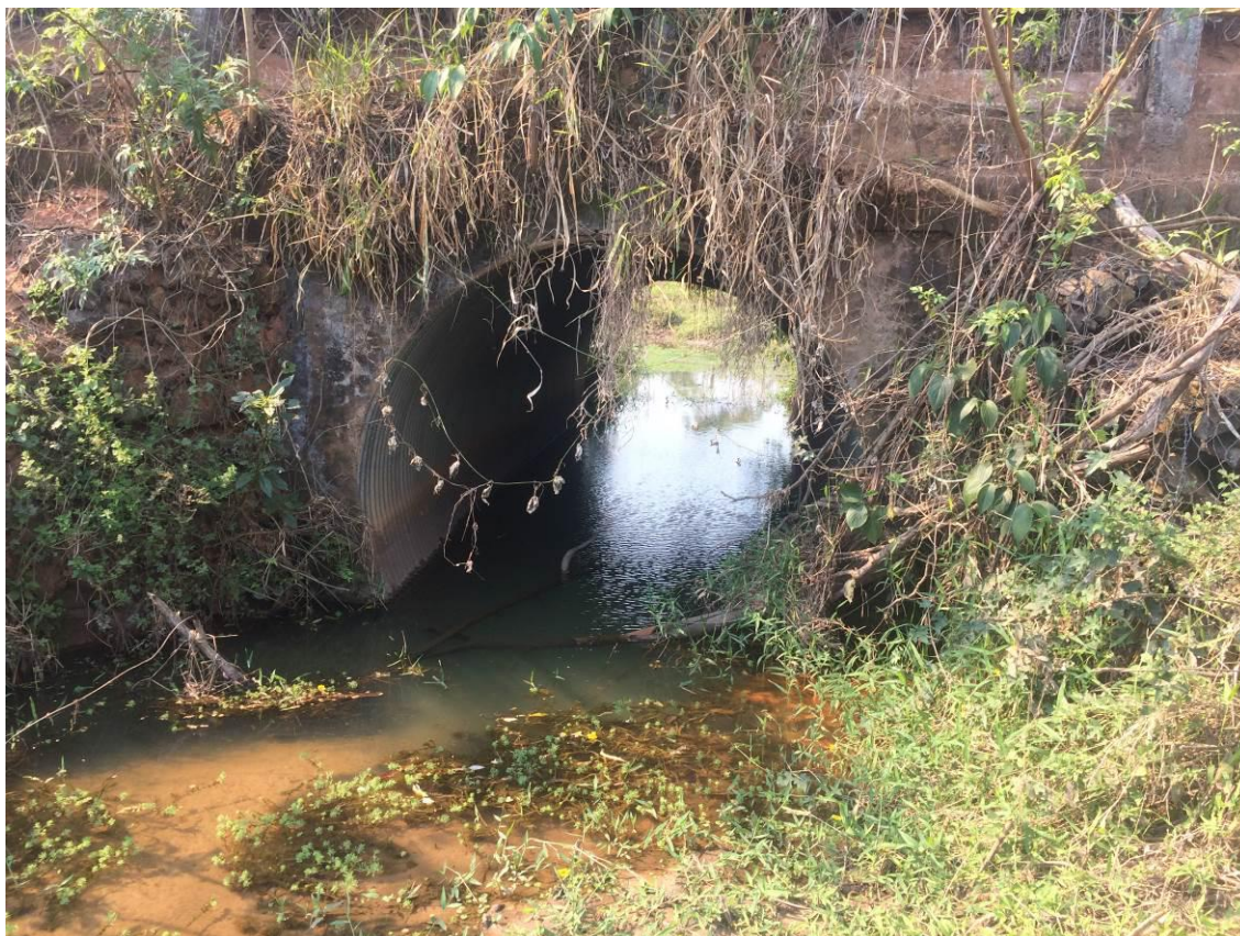
Figura 74 - Tubulação ármica com diâmetro de 2000 mm.
