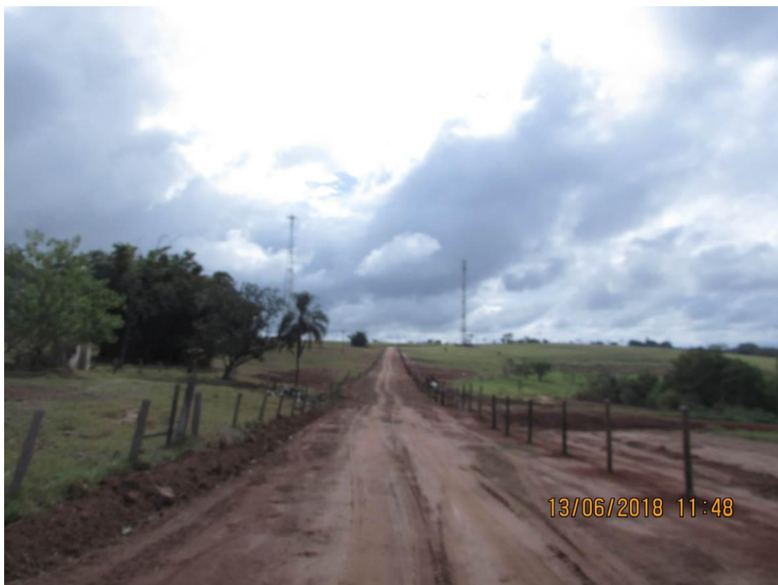
Figura 197 - Sem saída d'água.
