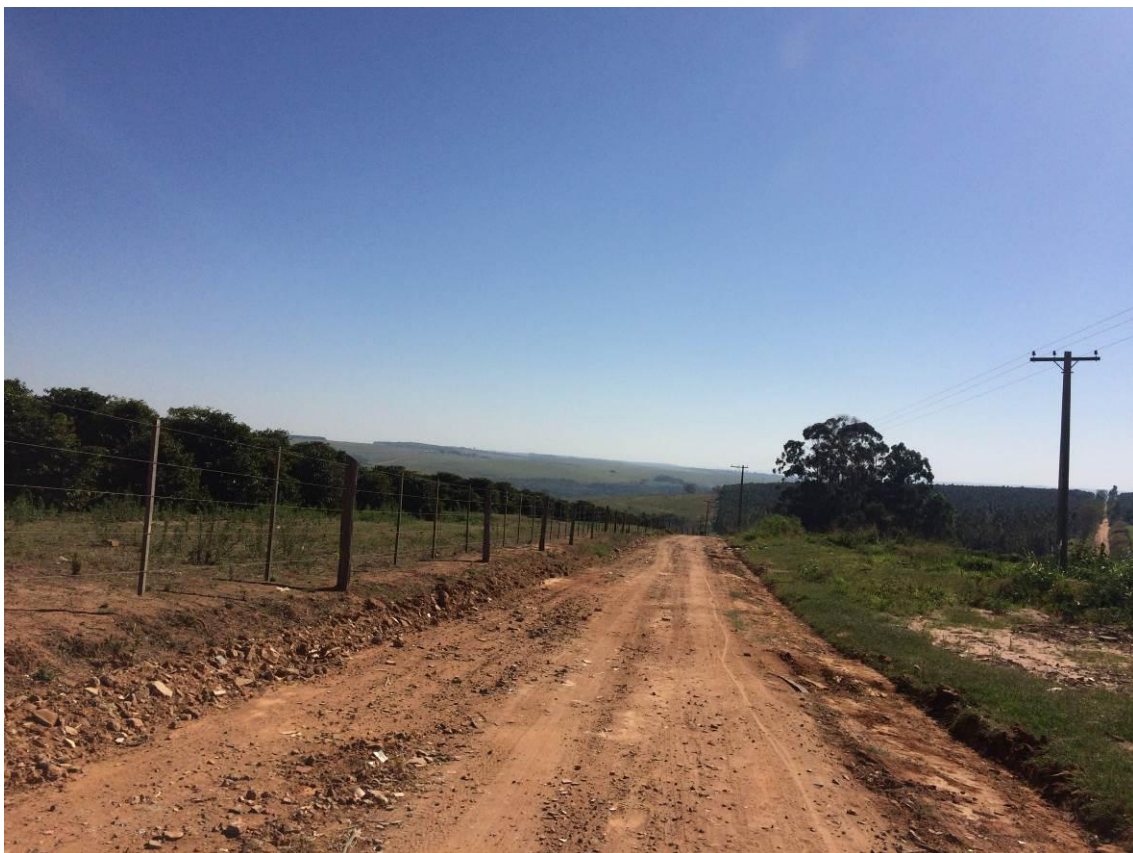
Figura 41 - Ausência de saída d'água.
