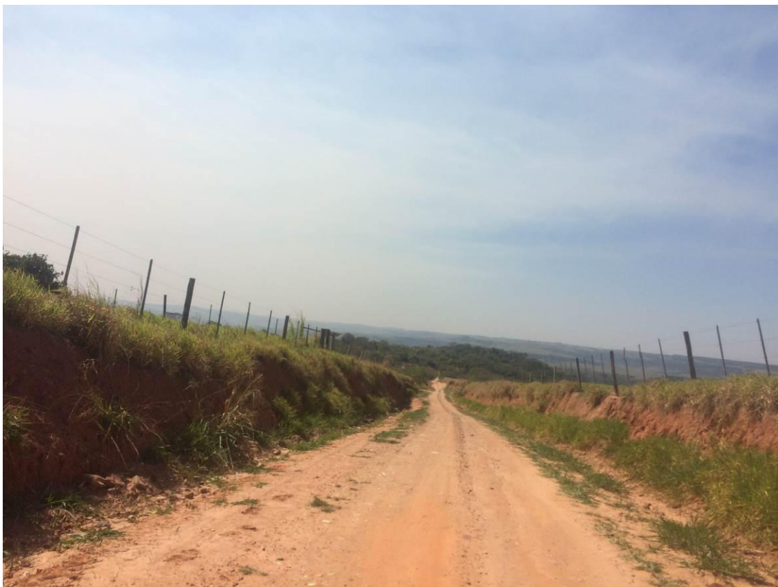
Figura 66 - Ausência de saída d'água.
