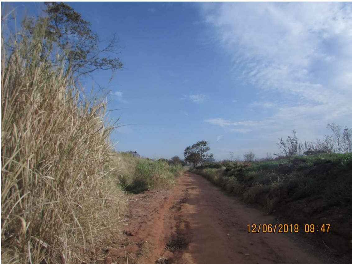
Figura 159 - Processo erosivo no leito carroçável.
