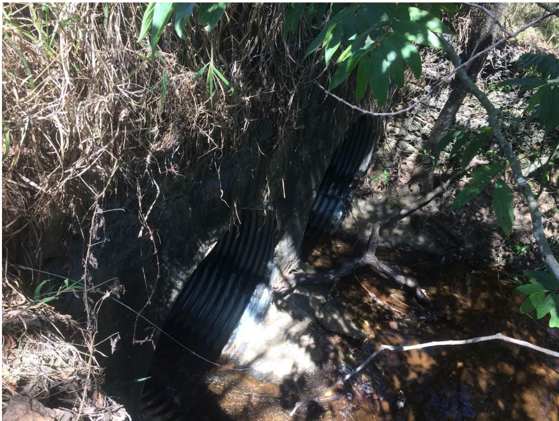
Figura 58 - Duas tubulações ármicas com diâmetro de 1500 mm.
