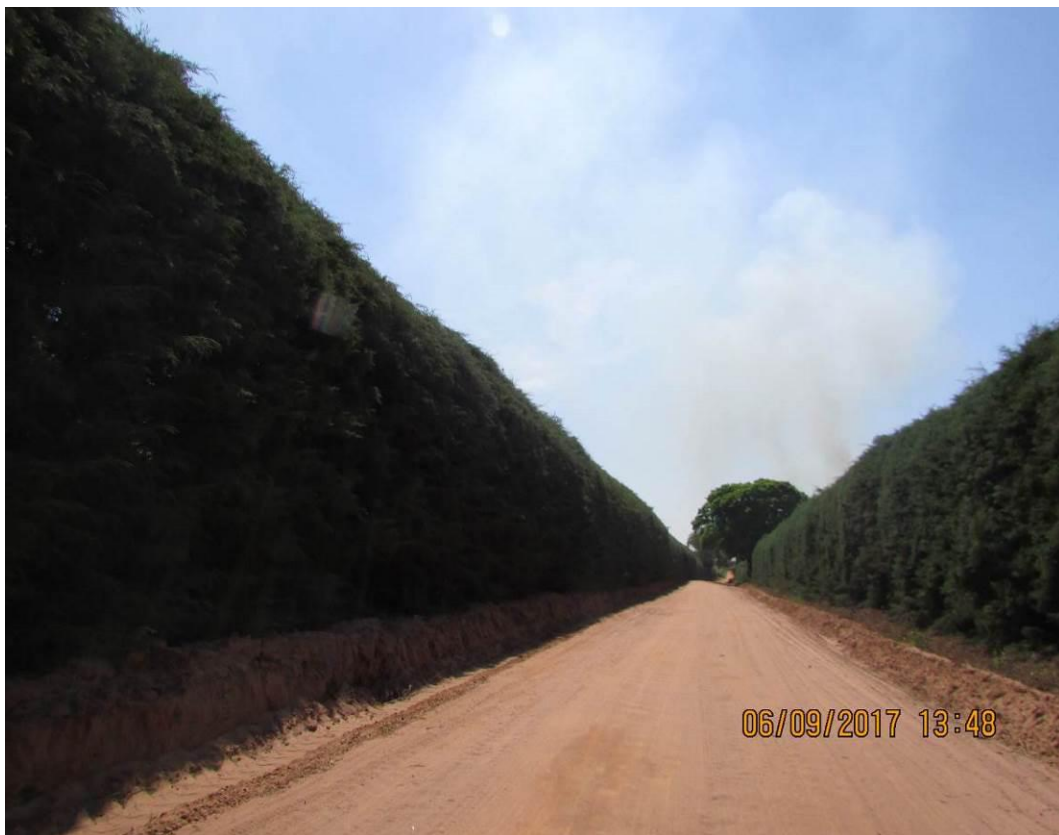
Figura 125 - Ausência de saída d'água.
