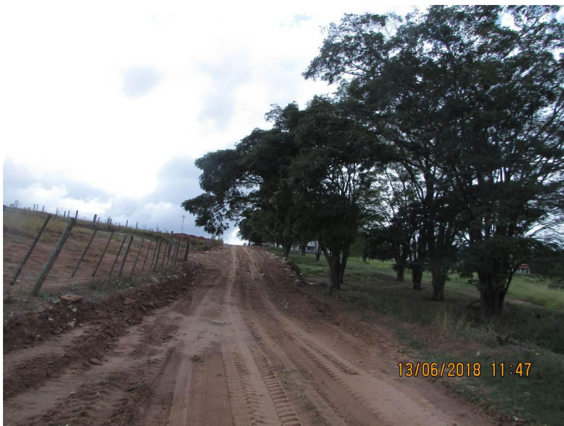
Figura 196 - Plataforma não conformada.
