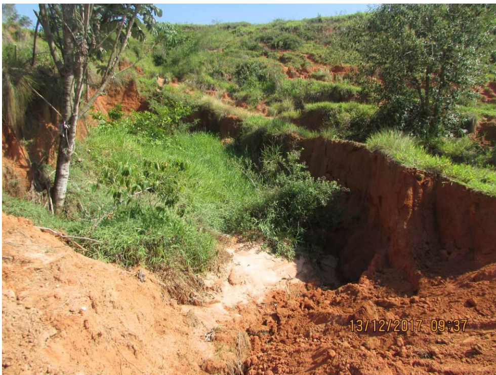
Figura 36 - A jusante da estrada, após o rompimento causado pelo processo erosivo.
