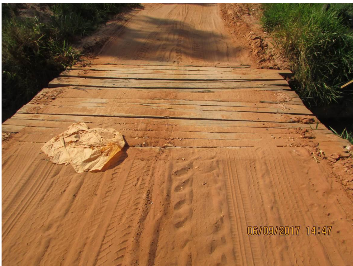
Figura 137 - Ponte de madeira com dimensões de 2,5 m x 3,3 m x 1,3 m.
