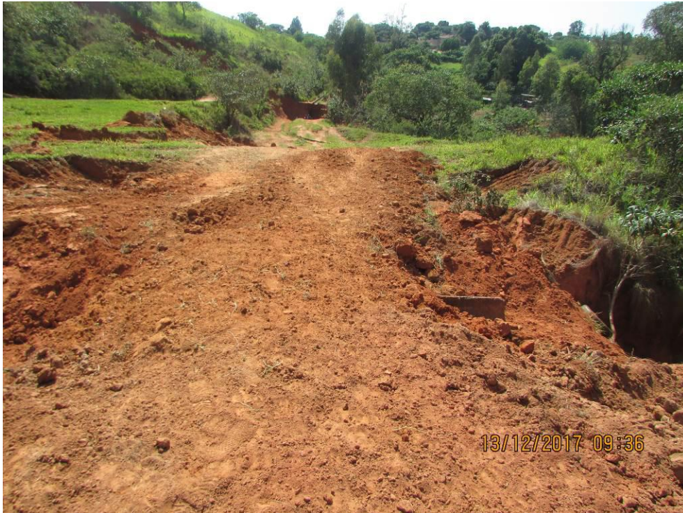
Figura 35 - Aterramento da estrada após o rompimento causado pela erosão.
