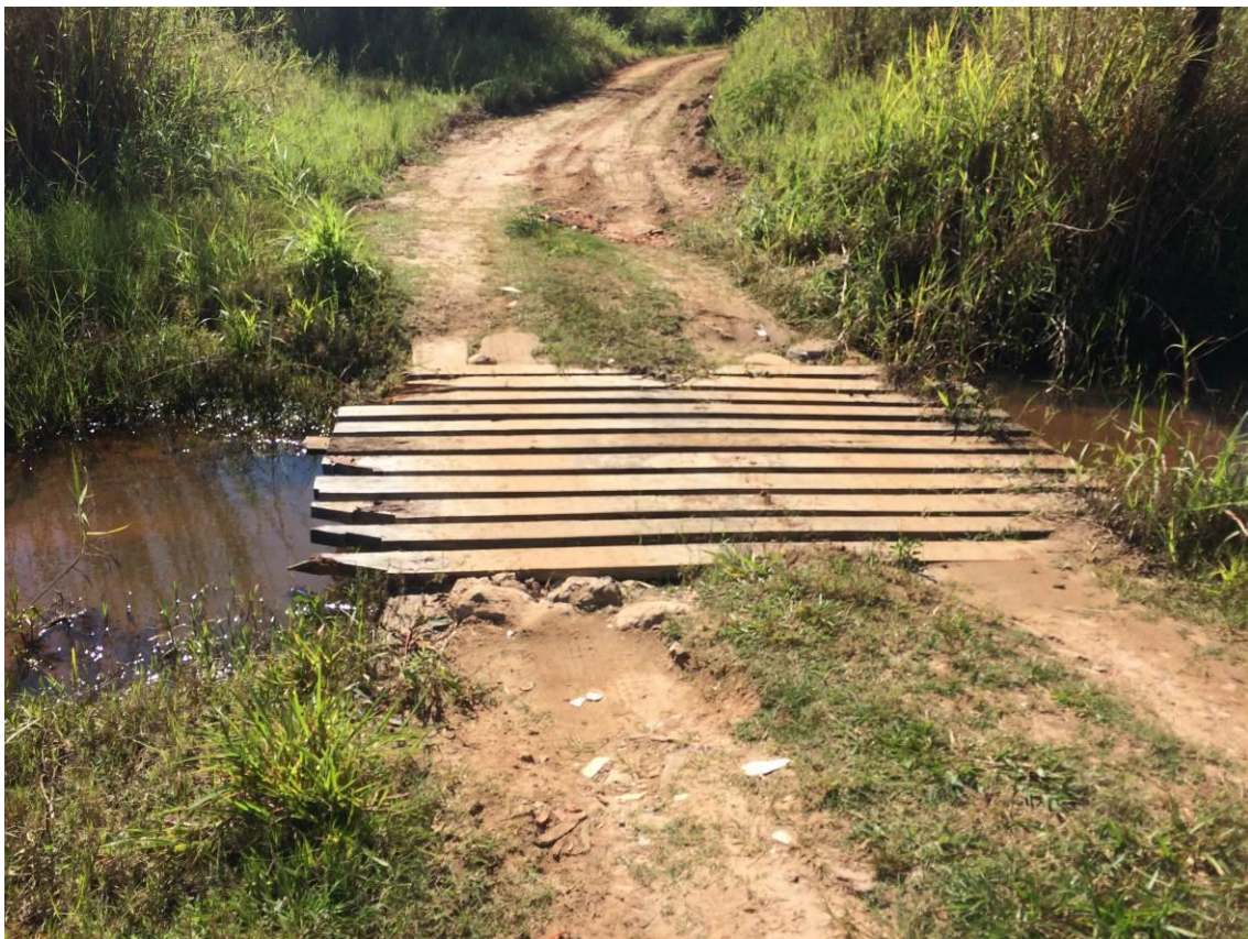
Figura 45 - Ponte de madeira com dimensões de 2,4 m x 3,0 m x 0,2 m.
