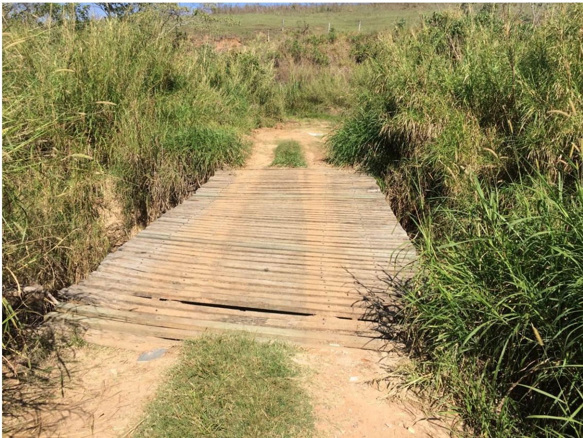
Figura 44 - Ponte de madeira com dimensões de 8,7 m x 3,3 m x 2,7 m.
