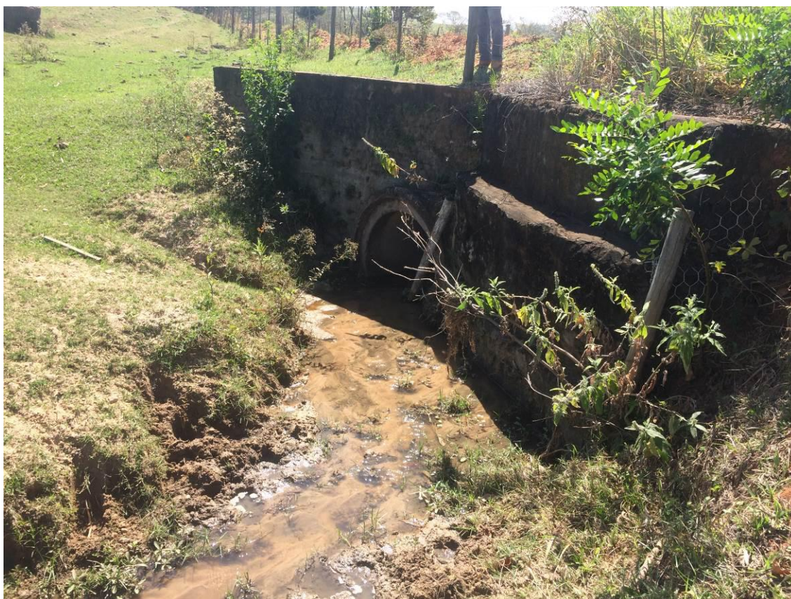
Figura 60 - Tubulação de concreto com diâmetro de 800 mm.
