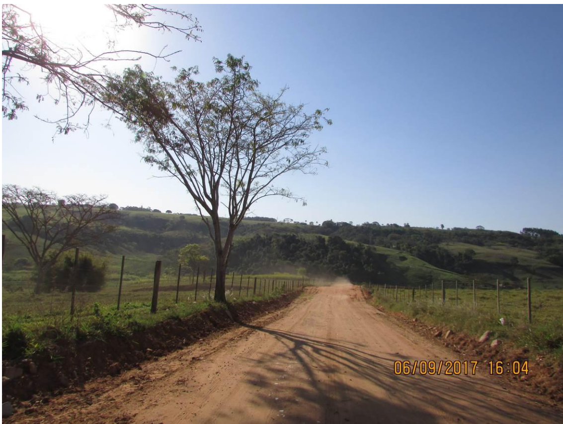
Figura 151 - Ausência de saída d'água.
