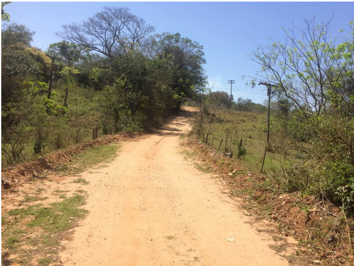
Figura 57 - Plataforma não conformada.
