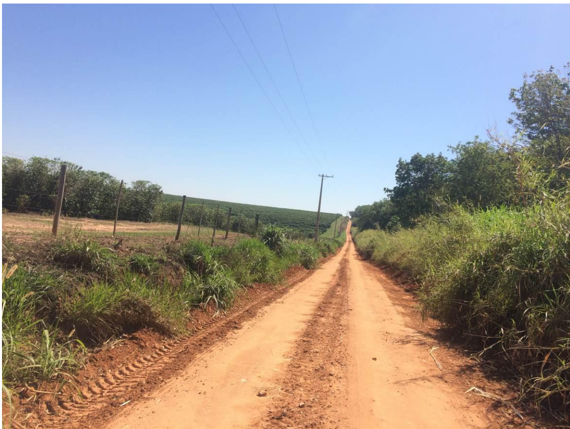
Figura 51 - Ausência de saída d'água, lombadas e revestimento.
