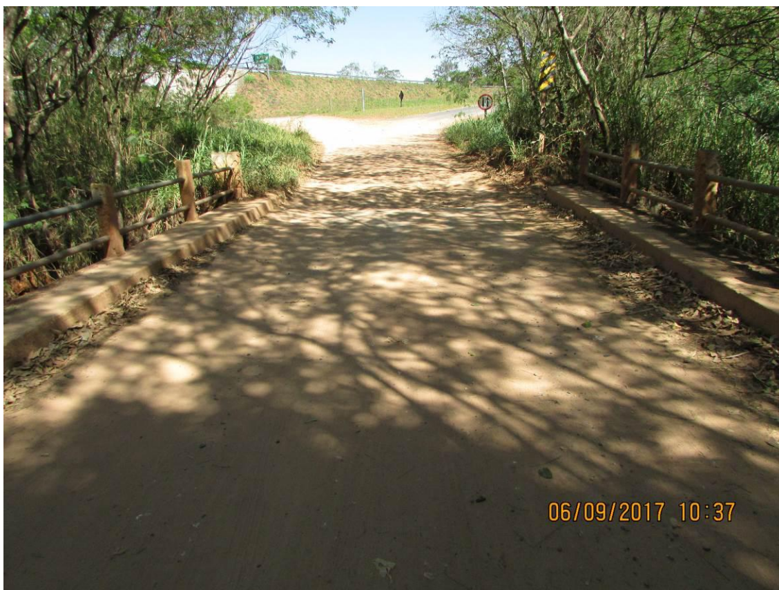
Figura 108 - Ponte de concreto com guarda-corpo, com dimensões de 10,0 m x 6,0 m x 4,6 m.
