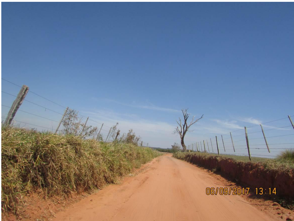
Figura 118 - Ausência de saída d'água.
