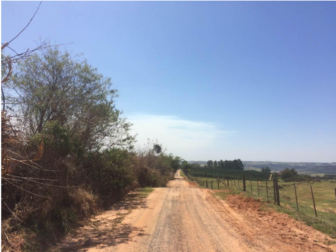
Figura 56 - Trecho com lombadas, saída d'água e resquícios de pedra brita.
