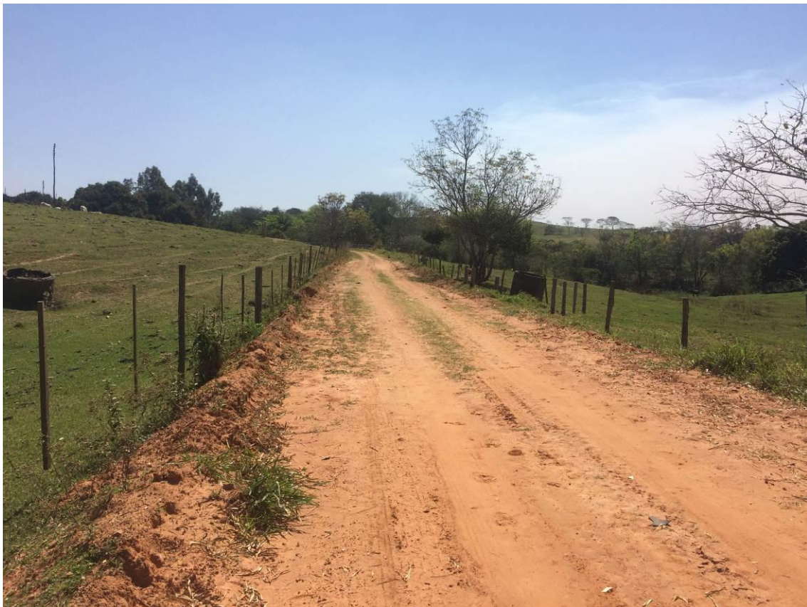
Figura 59 - Ausência de saída d'água.
