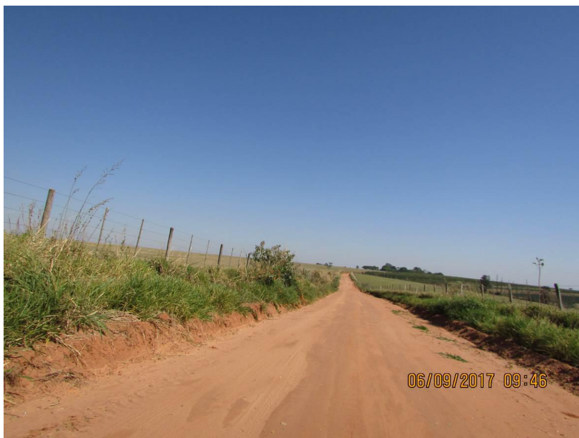
Figura 98 - Ausência de saída d'água.
