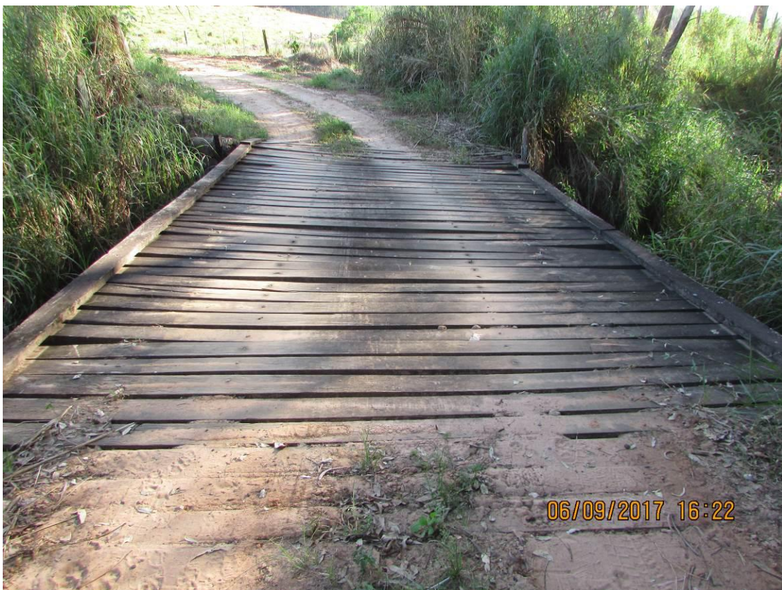
Figura 156 - Ponte de madeira com dimensões de 8,0 m x 4,0 m x 2,7 m.
