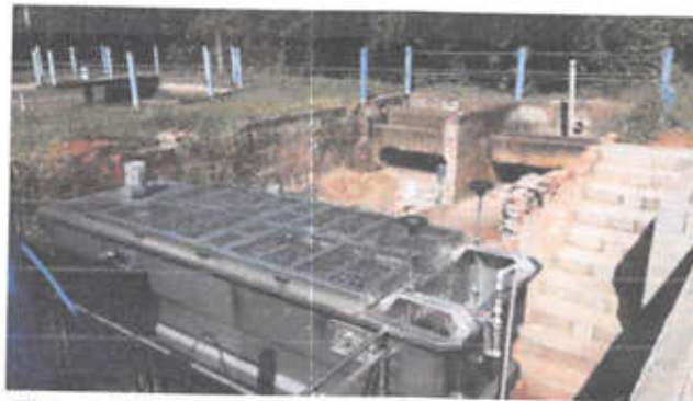
Figura 4.2.38 – Reforma em andamento na ETE Jafa
