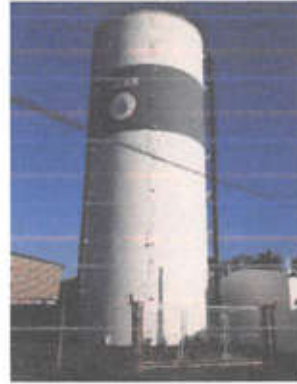
Figura 4.1.48 – Reservatório metálico Le Sorelle, de 60 m 3
