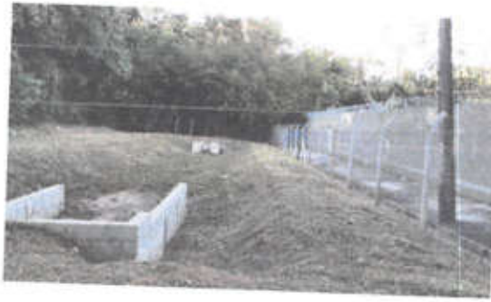
Figura 4.4.205 – Bacia de detenção do Residencial Gran Villagio
