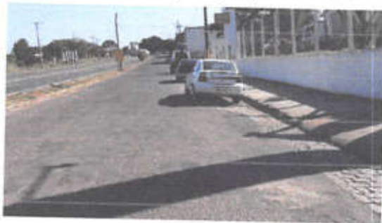
Figura 4.4.47 – Vista da Av Presidente Vargas, entre a R Santo Antônio e R Santa Eulália, onde a água escoava em velocidade elevada durante precipitações intensas
