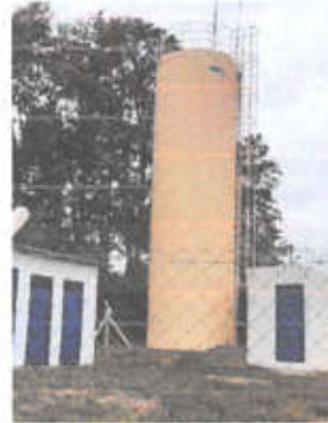
Figura 4.1.50 – Reservatório metálico Campo Belo, de 70 m 3
