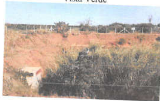
Figura 4.4.208 – Cercamento a ser concluído da bacia de retenção do Distrito Empresarial
