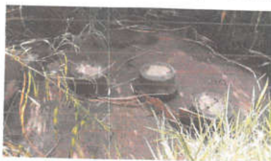
Figura 4.4.192 – Dissipador da bacia de retenção do Distrito Empresarial
