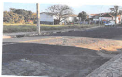
Figura 4.4.55 – Esquina da Av Presidente Vargas com a R da Estação, em que ocorrem alagamentos durante precipitações intensas
