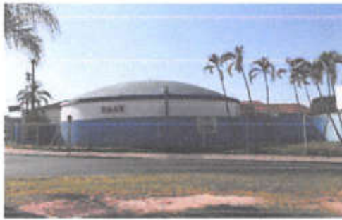
Figura 4.1.45 – Reservatório enterrado de concreto Adrianita, de 80 m 3
