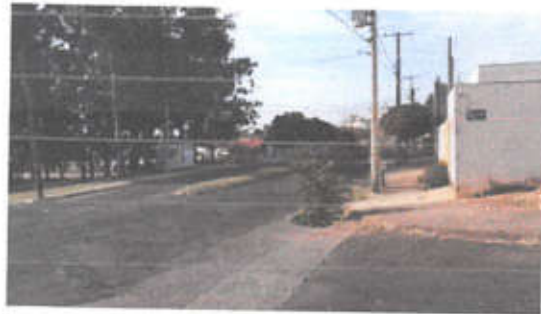
Figura 4.4.113 – R Nelo de Stefani esquina com a R Domingos Scurachio, onde ocorrem empoçamentos durante precipitações intensas
