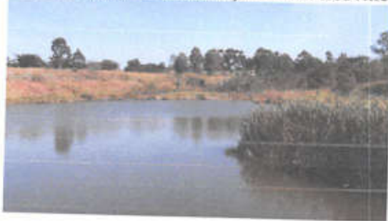
Figura 4.4.199 – Bacia de retenção 1 do bairro São Sebastião e do Jd. Ecoville
