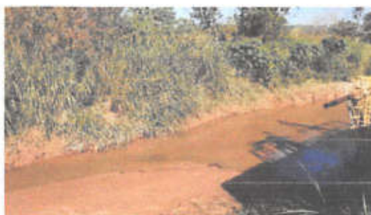
Figura 4.1.4 – Situação atual da barragem do Córrego da Cascata
