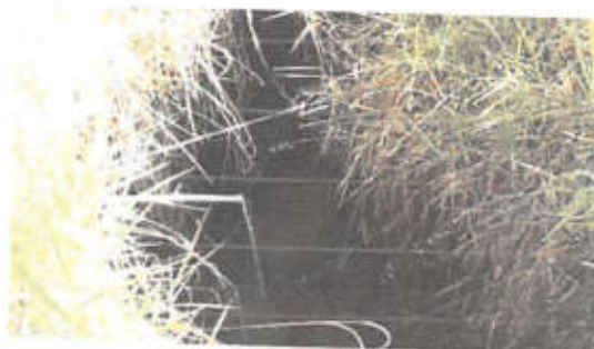
Figura 4.4.172 – Tubulação de drenagem superficial do Jd. Morada do Sol
