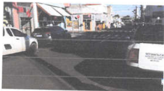
Figura 4.4.73 – R Cel Joaquim Piza, esquina com a R Heitor Penteadó, onde ocorrem empoçamentos
