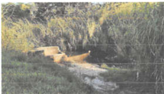
Figura 4.1.17 – Barramento de concreto da Captação Tibiriçá
