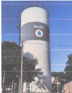
Figura 4.1.49 – Reservatório metálico Ecoville, de 200 m 3
