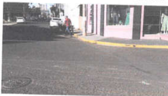
Figura 4.4.74 – R Cel Joaquim Piza, esquina com a R Heitor Penteadó, onde ocorrem empoçamentos
