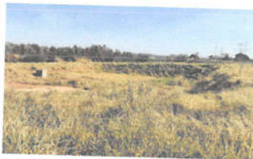
Figura 4.4.193 – Bacia de detenção do Jd. Le Sorelle
