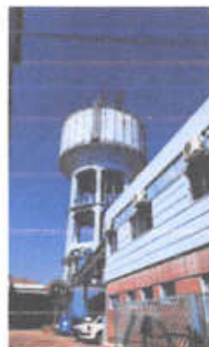
Figura 4.1.44 – Reservatório metálico Jd. Nova Garça (Comute), de 500 m 3
