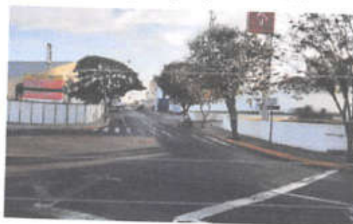
Figura 4.4.53 – Esquina da Av Dr Labieno da Costa Machado com a Alameda Mathias Manchini, em que ocorrem alagamentos durante precipitações intensas
